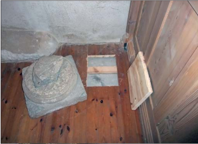
Ett provhål i golvet nära södra korsarmen, visade att det var gjutet under bänkkvarteret. Foto ÖLM 2011.
