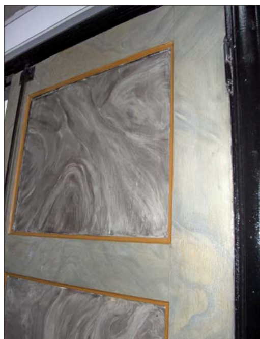
Ett parti av de åtgärdade dörrarna.
