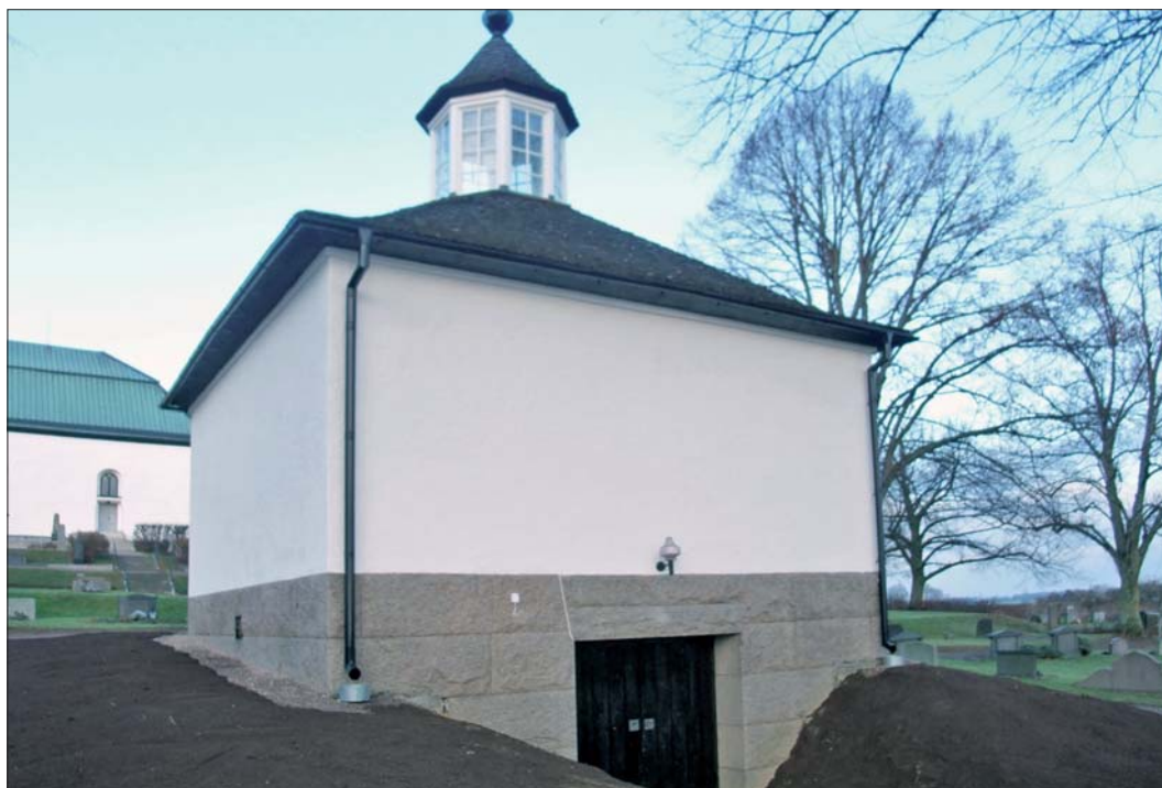
Dräneringen är färdigställd.
