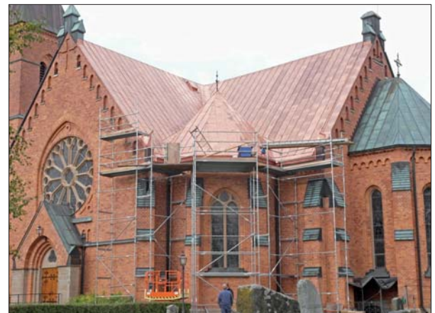
Det nylagda taket vid slutbesiktningen.
