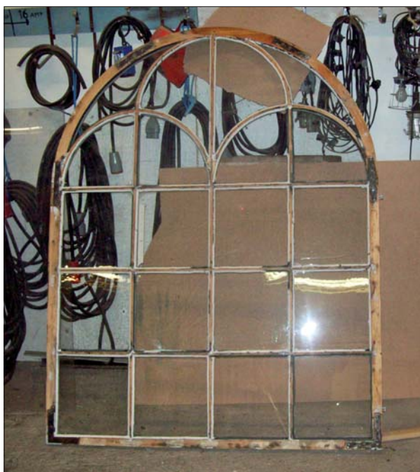
Fönsterbågarna skrapades. Foto Joakim Karlsson.
