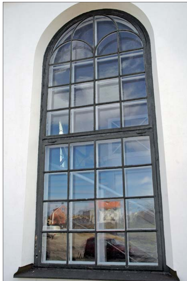
Fönster före renoveringen.
