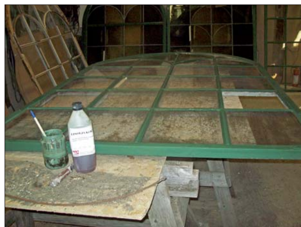
Ommålning av fönstren med en mer rent grön kulör än tidigare. Foto Joakim Karlsson.
