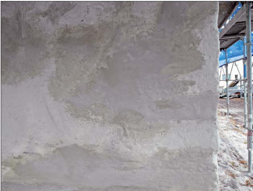
Putslagning på tornfasaden.
