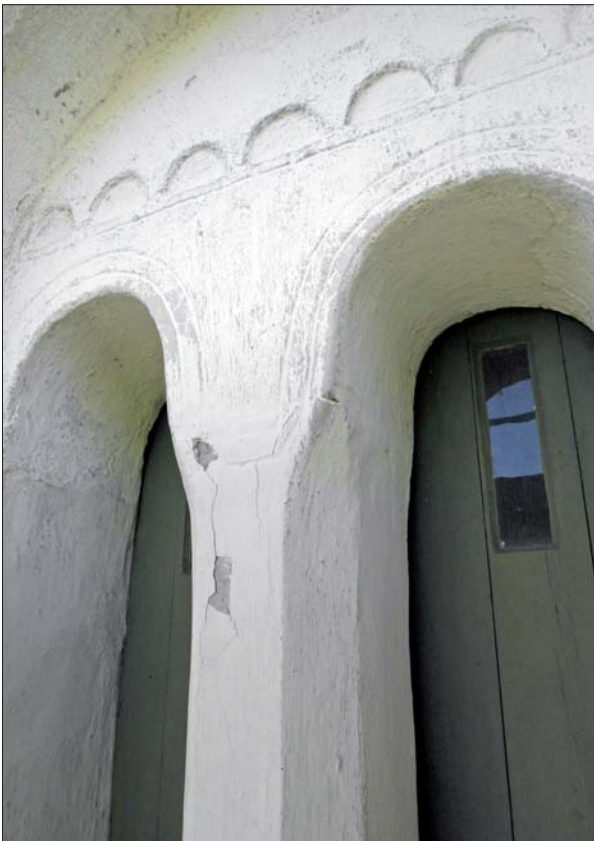
Sprickor i putsen vid de medeltida tornöppningarna. Troligen är det en äldre lagning i själva smygen.
