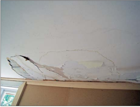
Ovan. Skador på det pappspända taket. Nyttillverkad hålkärsläst. T h. Flaggstängen före renskrapning.
