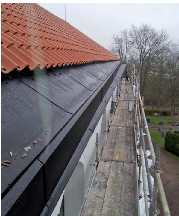
De två fotografierna visar den nyttillverkade ståndrännan. Foto Fredrik Åstrand.
