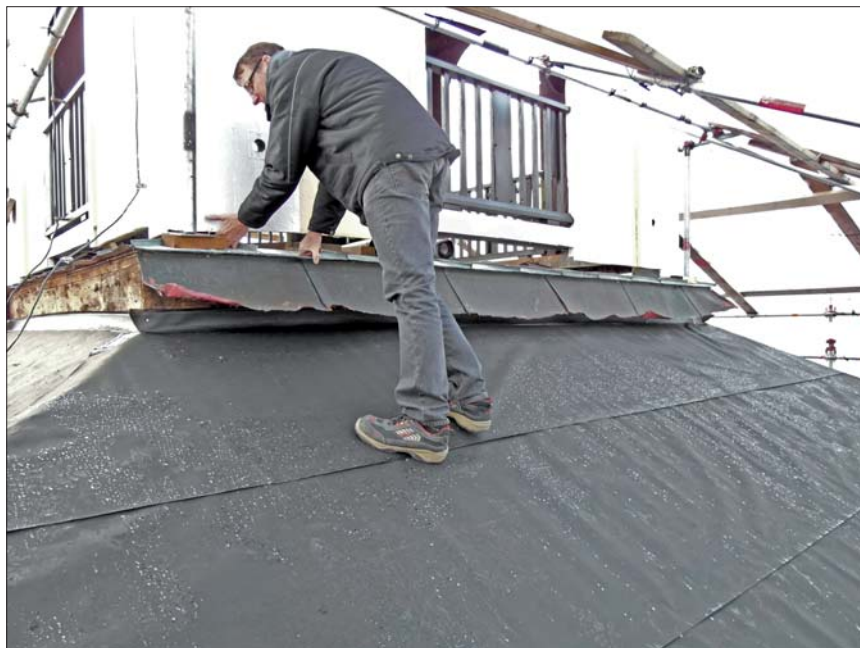
Pappen vid lanterninens bottenbjälke rivs bort.
