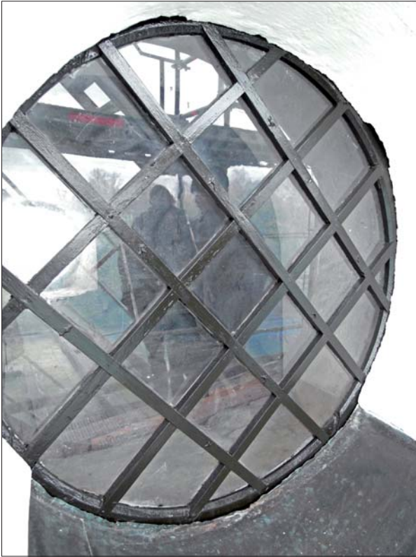
Ett av de runda tornfönstren efter målning.
