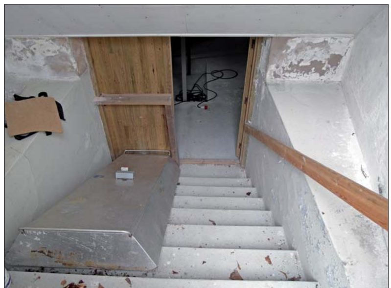
Gravkapellet. Skador vid källarmedgången.
