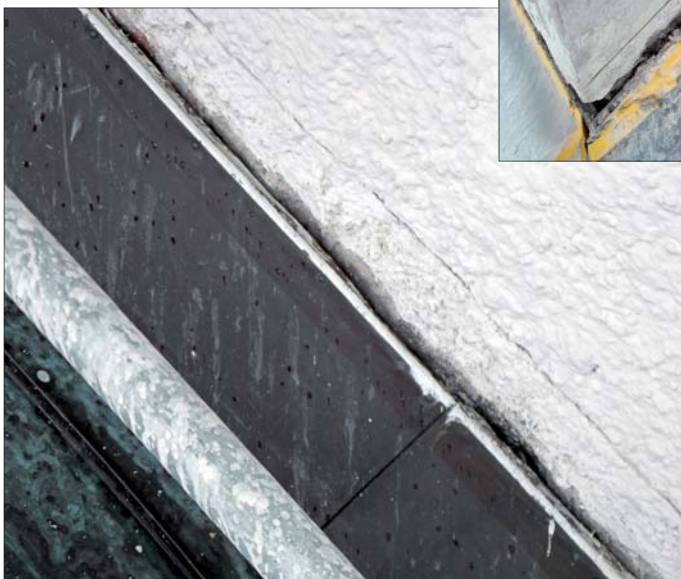
Uppsågning av spår för att fästa förstärkningen av ståndskivan.
