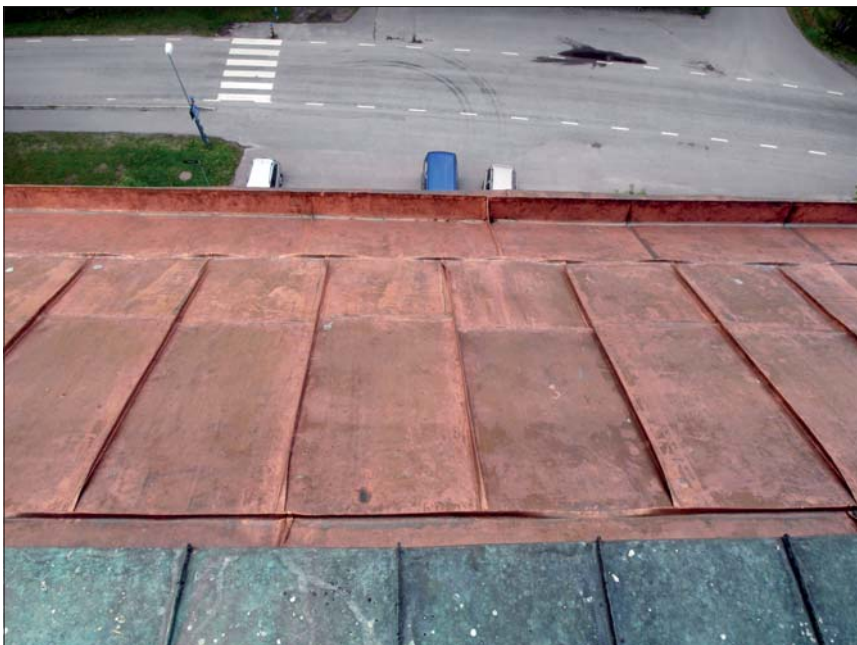
Ny kopparplåt på torntaket.
