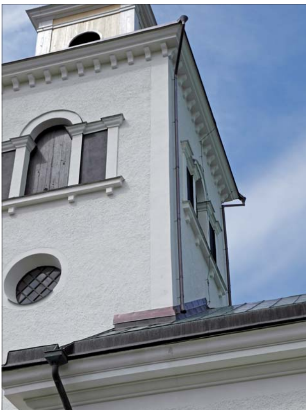
Nymonterade stuprör och ståndskiva.
