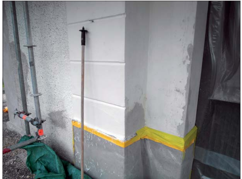
Putslagningar invid kyrkans västportal.
