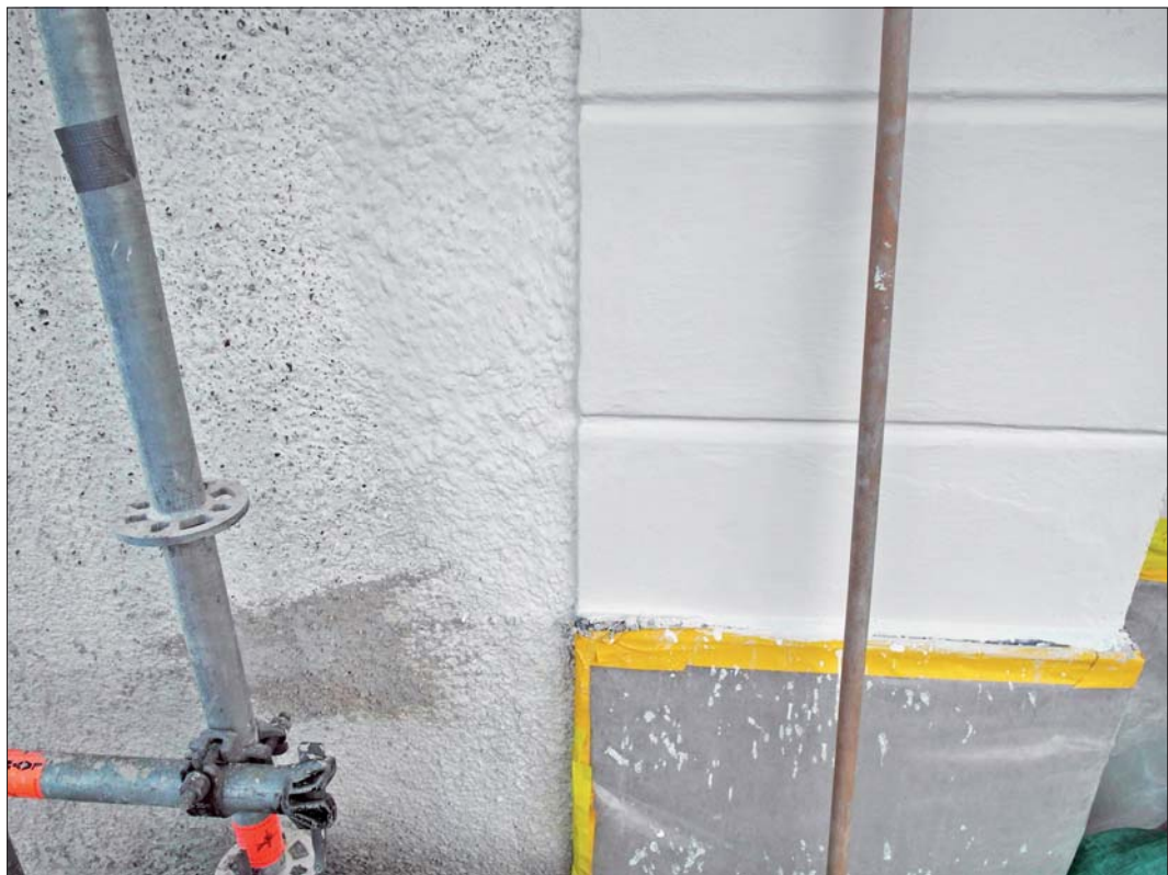
Avfärgningsprov på fasaden vid västingången.
