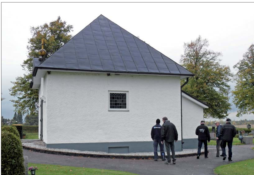
Källarfönstret på södra sidan har satts igen.
