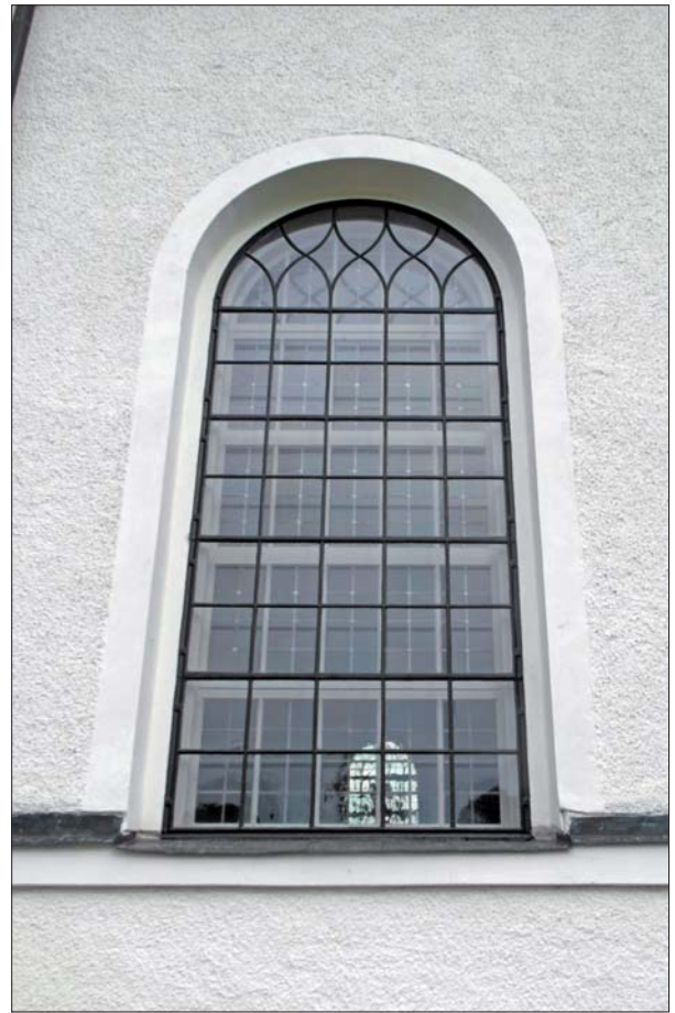
Färdigmålad fönsterbåge på sydsidan.
