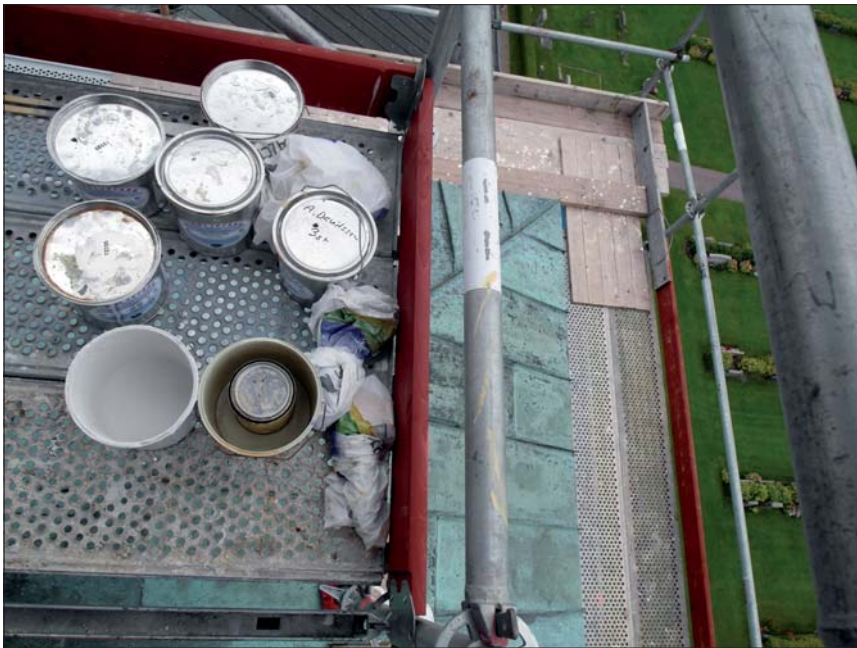
Under färgburkarna för målning av lanterninen, syns torntaket innan omläggning.
