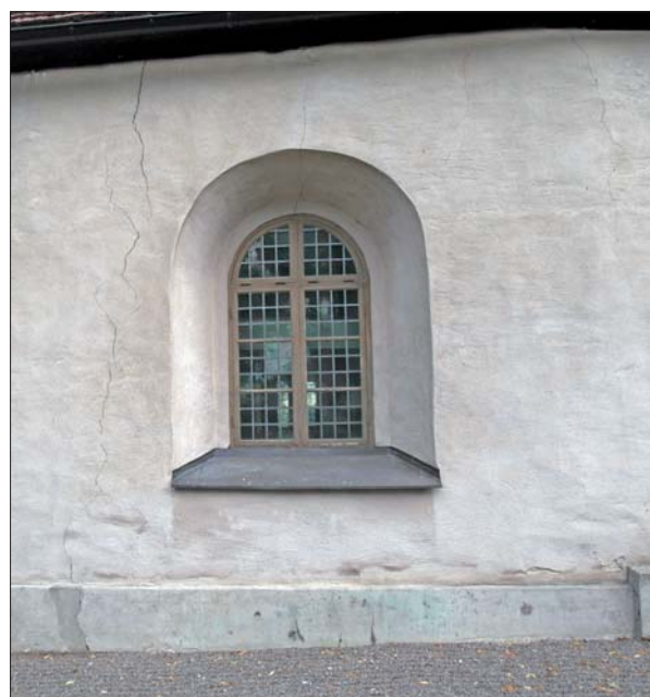
Befintlig fasadputs, troligen från 1959/60.
