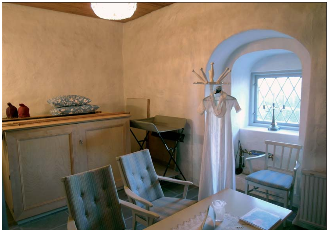
F d brudkammare/väntrum före renoveringen, sydvästra delen.
