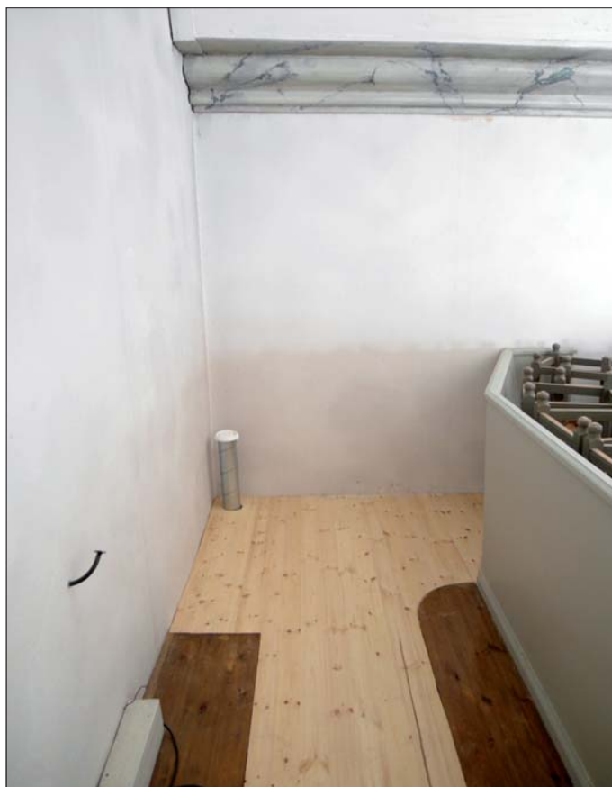
När läktartrappan tagits bort, sattes öppningen igen på orgelläktaren. Senare tonades brädorna in något.
