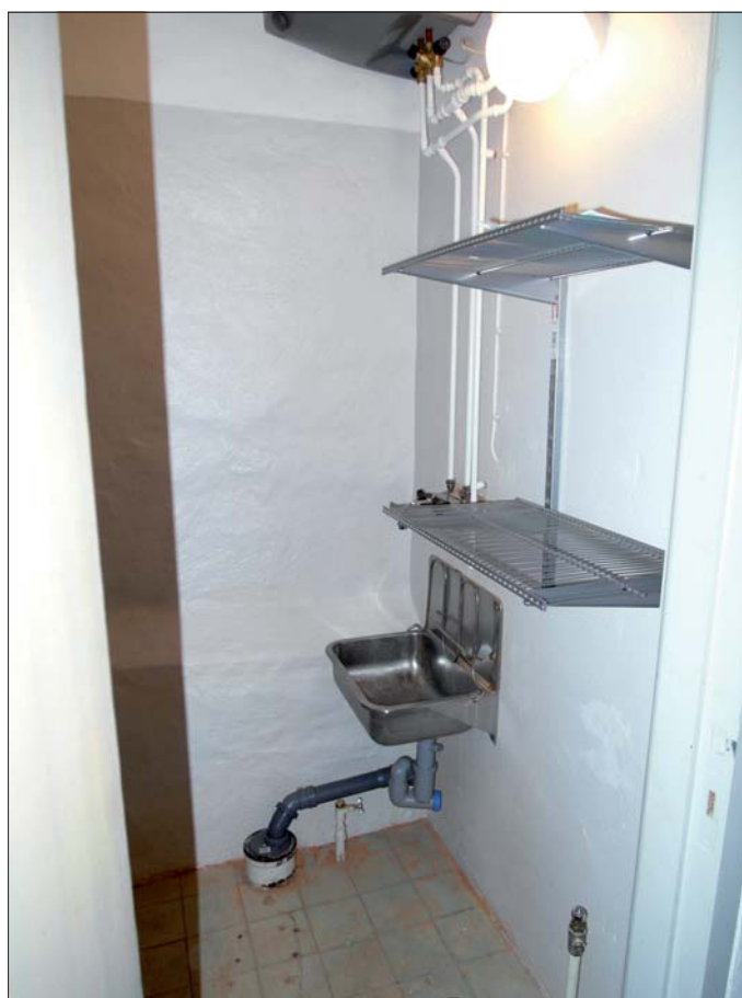
Den tidigare toaletten gjordes om till städutrymme. Utslagsvask m m monterades på den sekundära väggen i väster.
