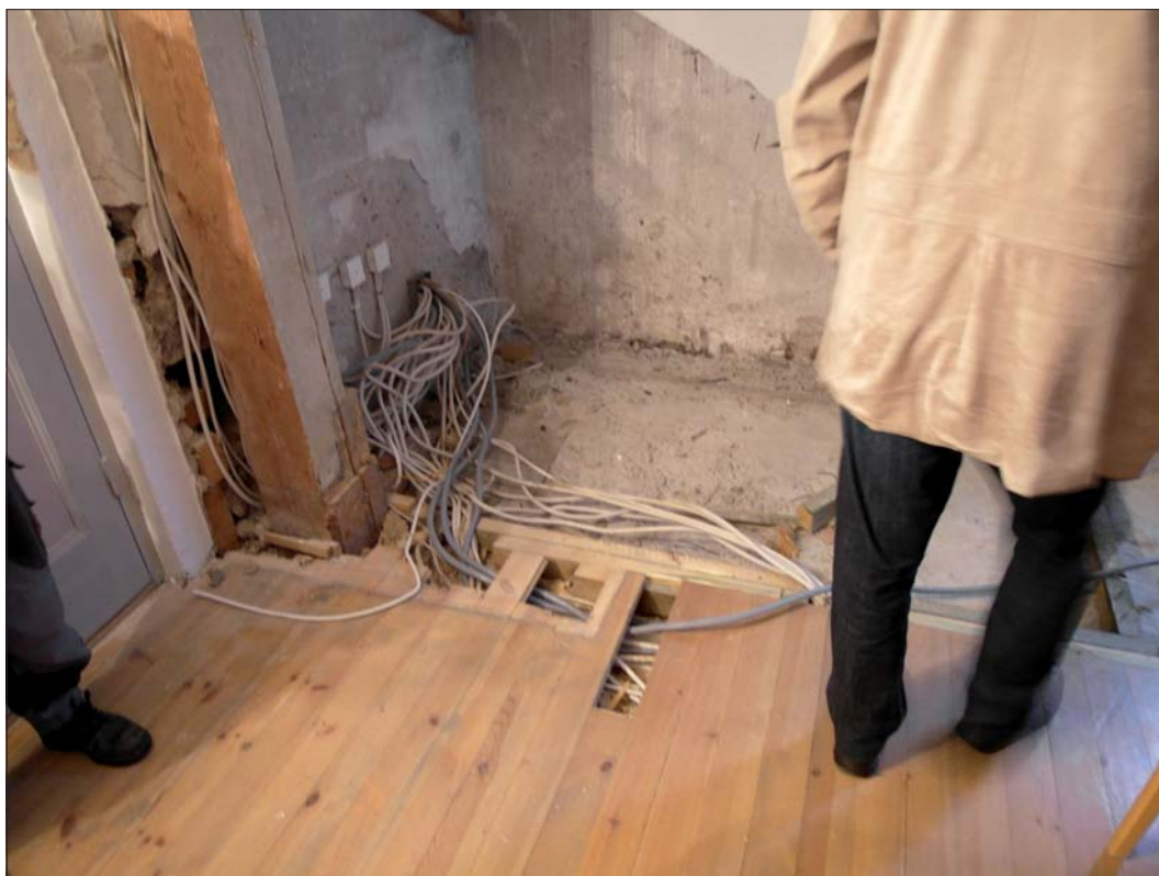
I utrymmet för den nya HWC var det gjutet under golvbrädorna.
