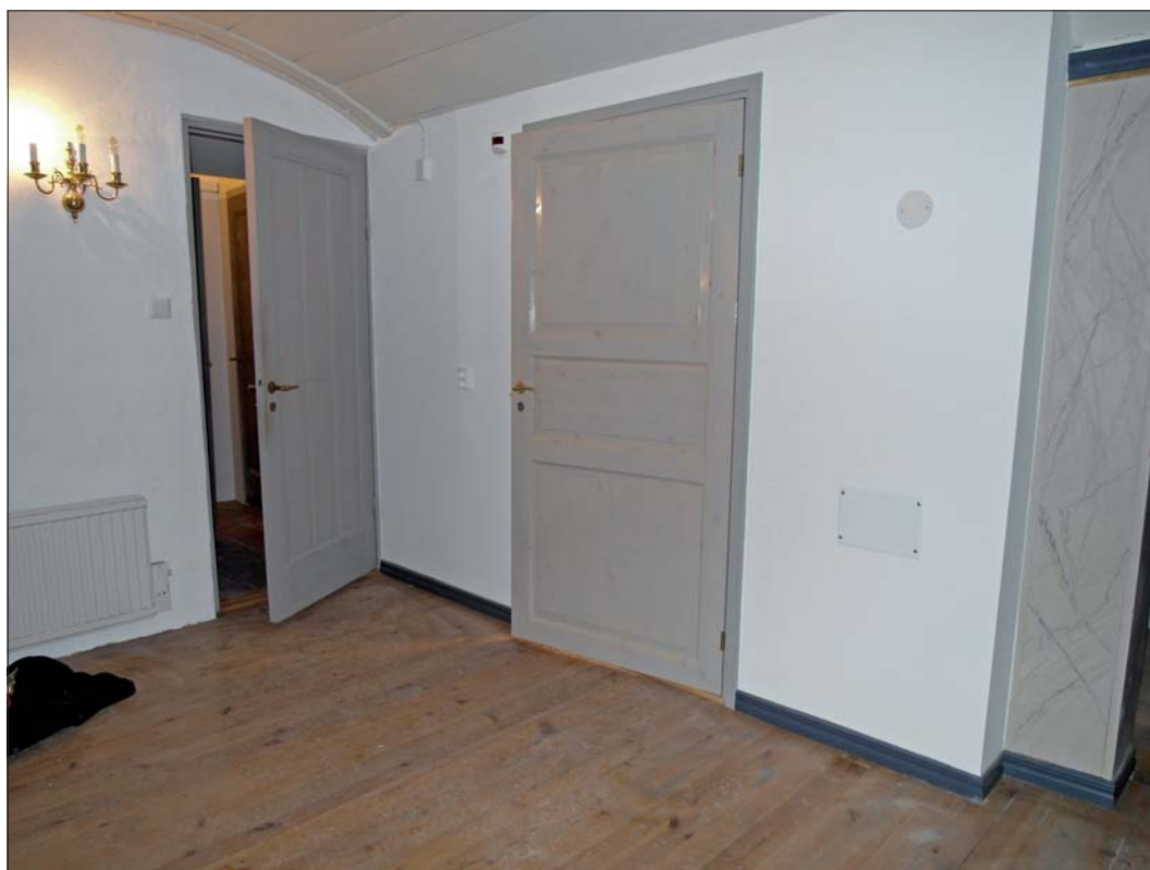
Den nya inbyggnaden för HWC under orgelläktaren.
