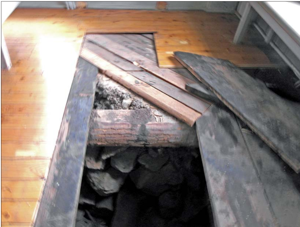
Golvet i södra korsarmens sydöstra hörn. Under det nuvarande brädgolvet ligger det äldre golvet och en lagning över ett stenfundament som har burit en eldstad.
