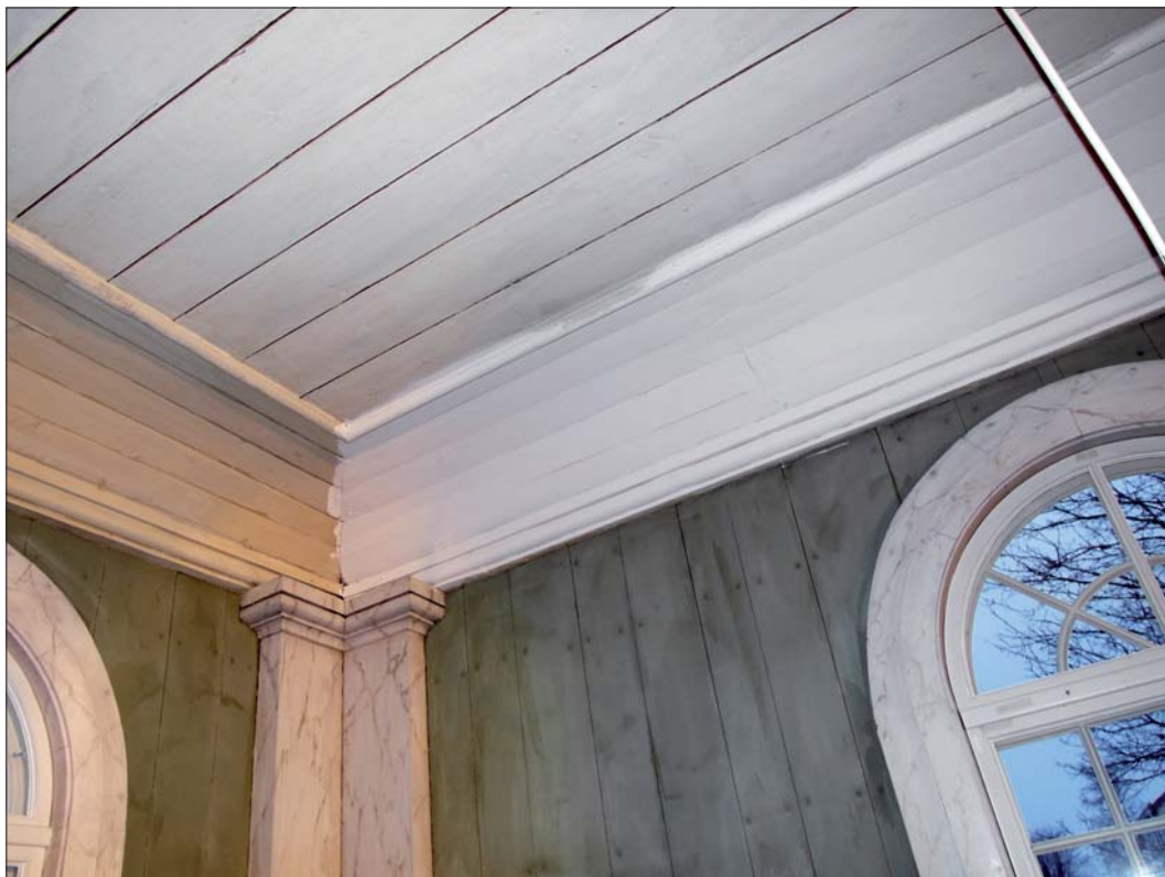
Provmålning av takfärgen.
