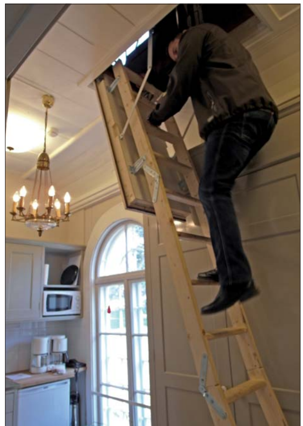
Nyttillverkad nerfällbar trappa till vinden.
