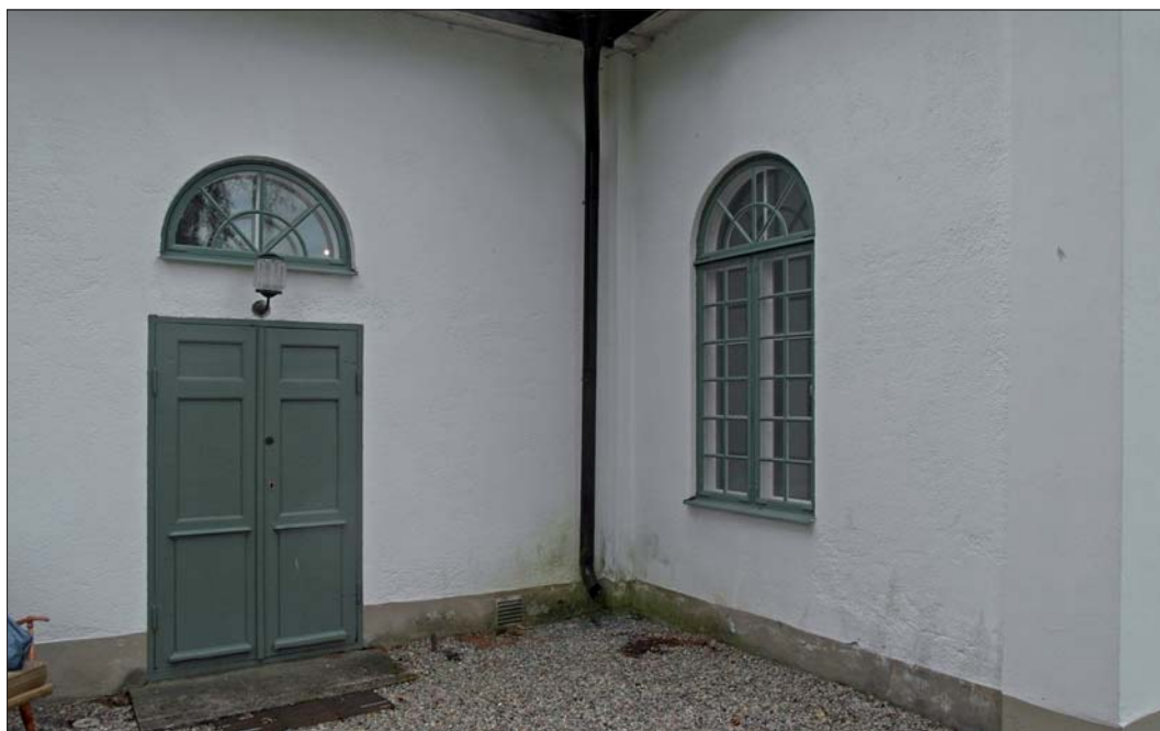
Kyrkans nordvästra parti. Ombyggnaden innebär att dörren i norra korsarmen och fönstret i långhusets norra vägg bytte plats.
