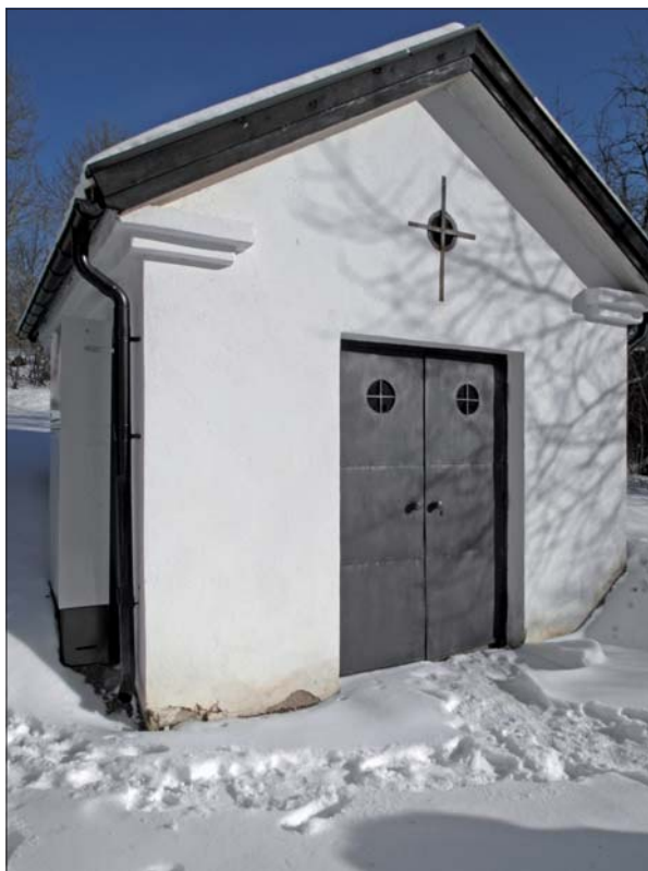
Elmätarskåpet placerades på distans på bisättningshusets västra fasad.
