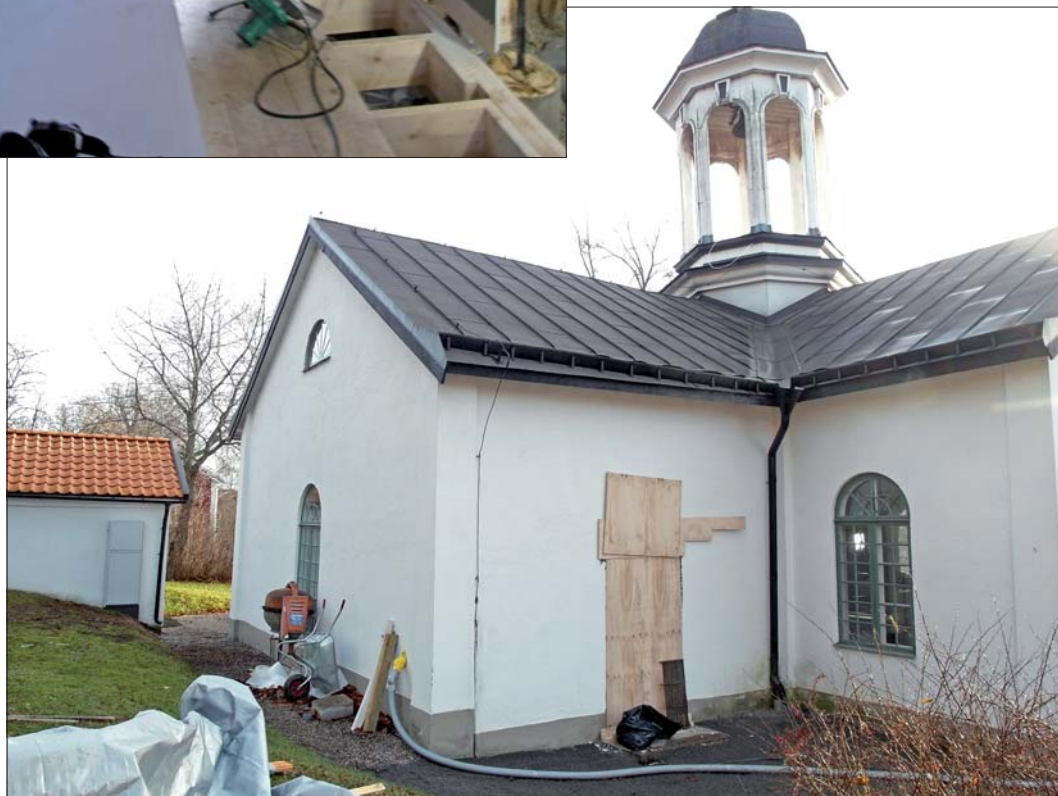
Det befintliga dörrhålet har täckts för.
