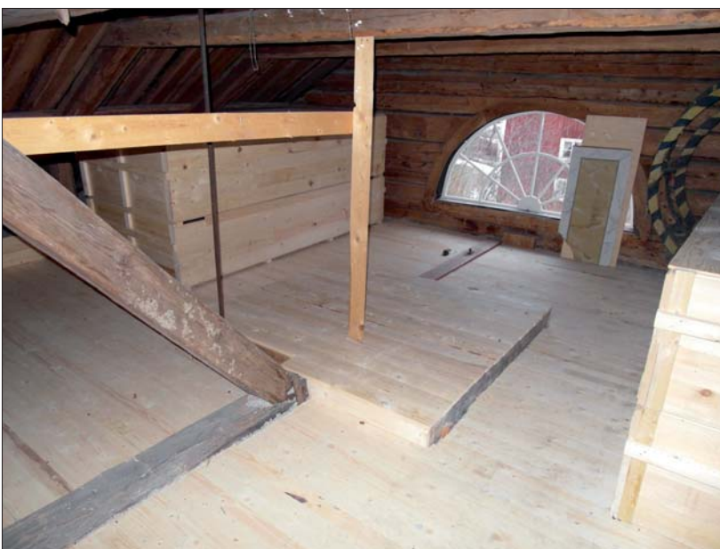
På vinden byggdes ett brädgolv över den befintliga isoleringen av lösull. Förhöjningen är en inbyggnad av en äldre ventilation.
