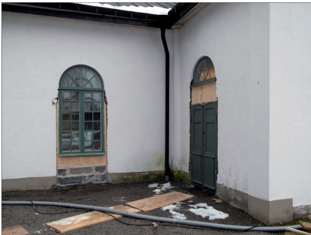
Dörr och fönster har bytt plats.
