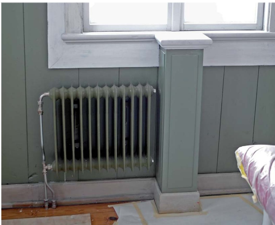
Nytt element i koret. Även rördragningen målades sedan i väggens kulör.
