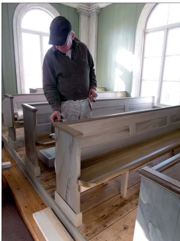
Christer Gustavsson målar överliggeren på en av bänkarna i södra korsarmen.
