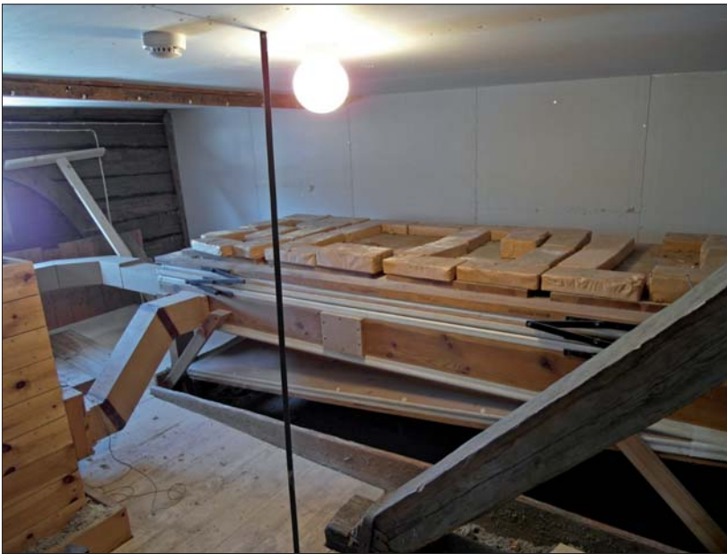
På vinden byggdes orgelfläkten in i ett särskilt rum.
