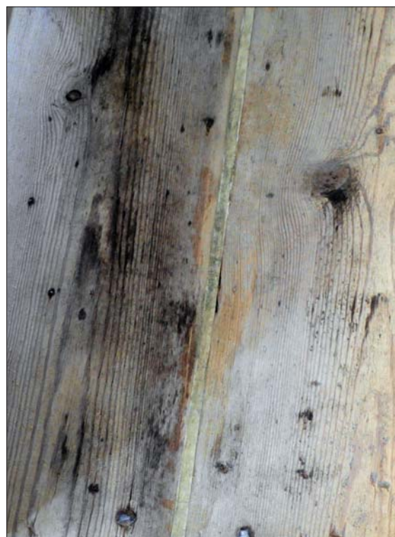
De största golvspringorna tätades med trälistor.
