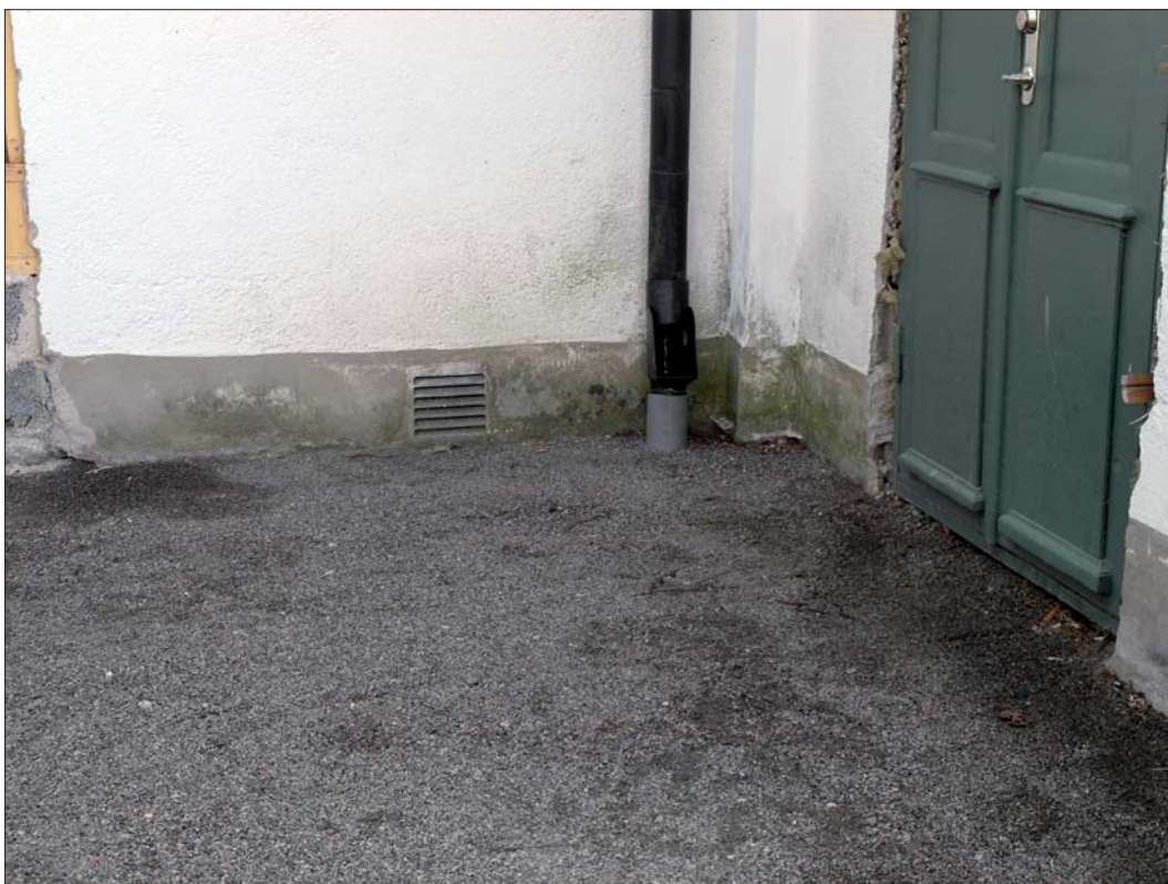
Gången fram till dörren på norra sidan har hårdgjorts.
