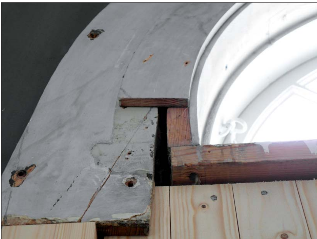
Dörren har satts in på sin nya plats och omfattningen till överljuset har monterats.
