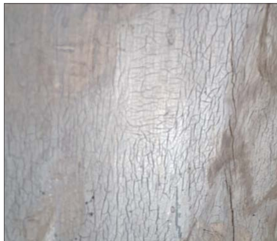
På pilastrarna fästes färgflagor.
