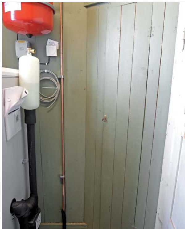
Värmepumpen till bergvärmeanläggningen sattes in i den äldre sakristian, öster om koret. Rördragningar gjordes framför den igensatta kordörren. På bilden syns en äldre skåpdörr.
