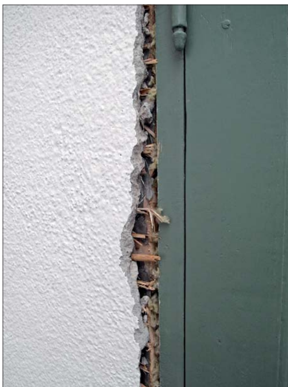
Vid dörrkarmen syns reveteringsmattan under 1960-talets puts.
