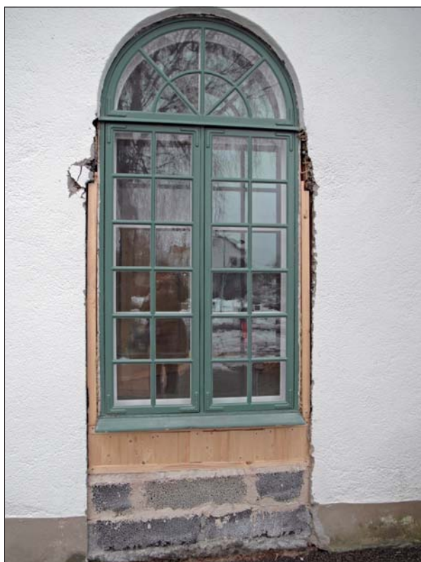
Fönstret på sin nya plats i norra korsarmen. Under fönstret syns lecablock, en nutida version av 1940-talets lättbetong. Blocken användes för att sätta igen det tidigare dörrhålet.
