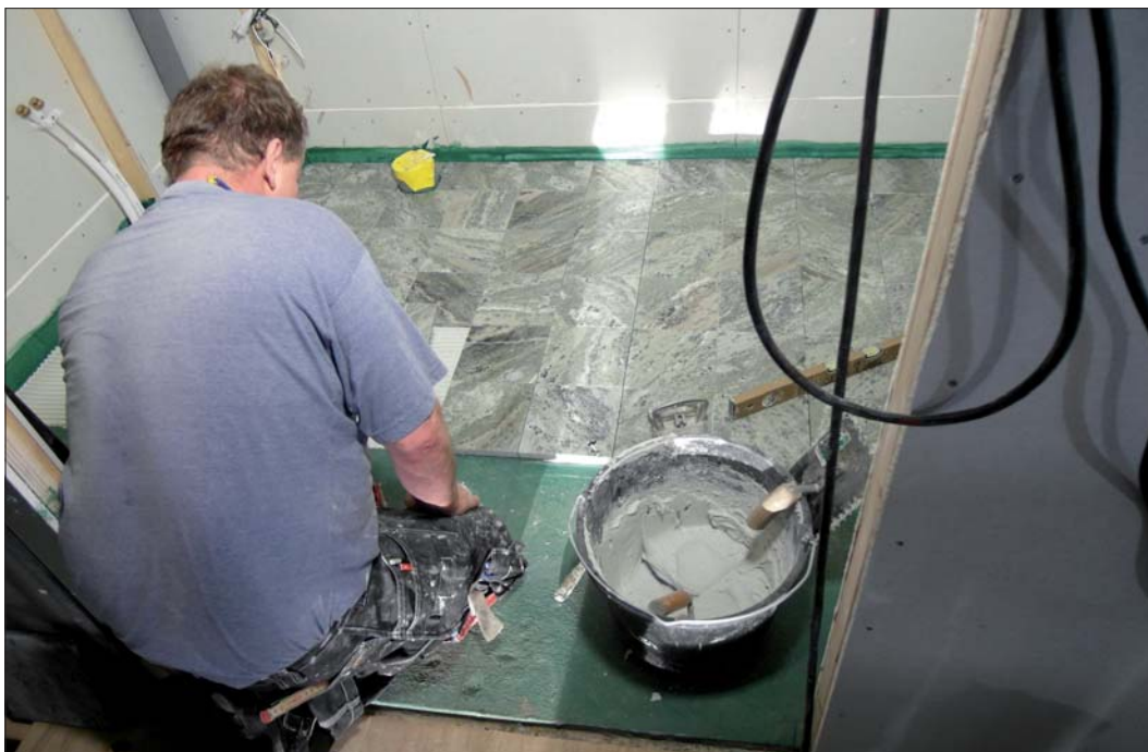
Golvläggning på RWC.
