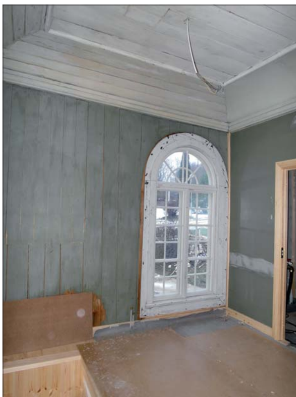
Fönstrets nya placering från insidan.
