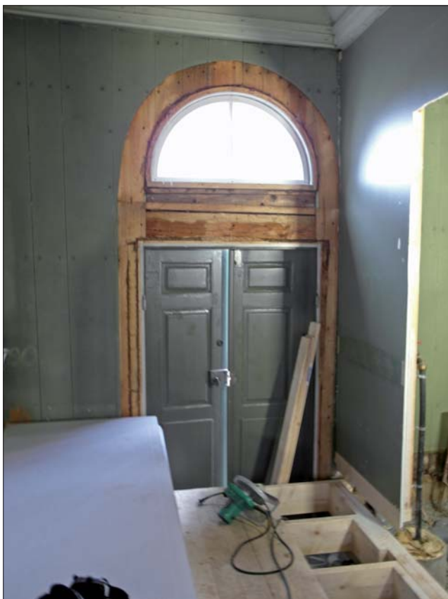
Dörrfodren runt den dörr som ska flyttas har tagits bort och det nya golvet håller på att läggas i norra korsarmen. Foto mot väster.
