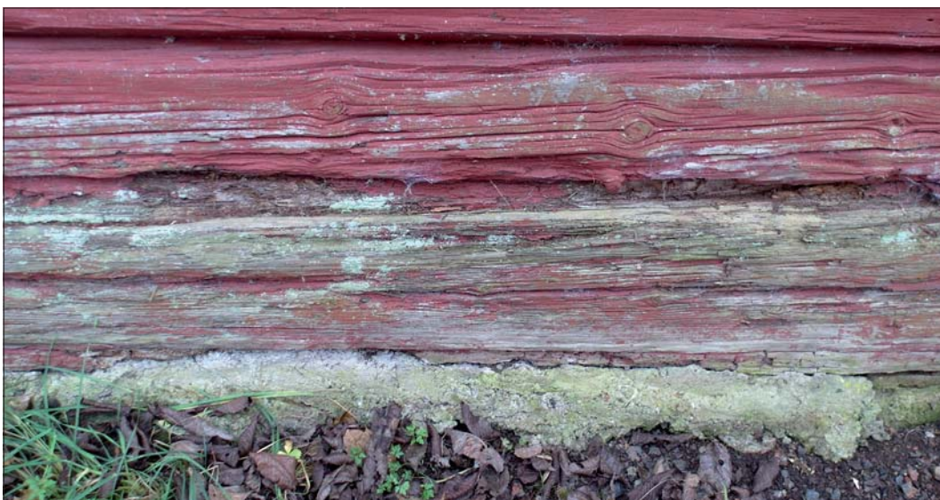
Skador i timret och cementbruk upp på timret, östra gaveln.
