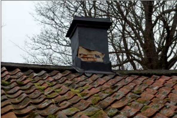
Taket är belagt med handslaget tegel. I nock sitter skorstenen.
