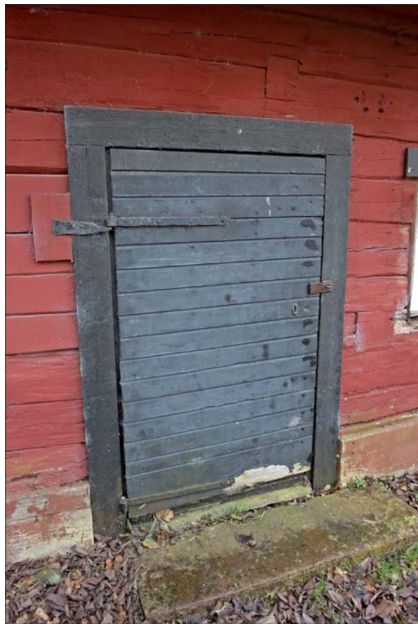
Dörr mot nordväst klädd med fasspontpanel. Kalksten framför ingången.
