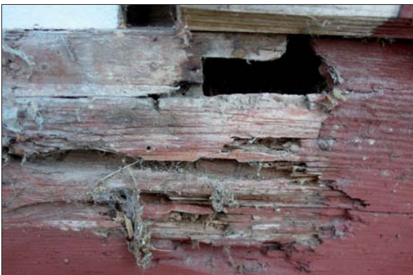
Rötskada i anslutning till ett av fönstren på norra sidan.
