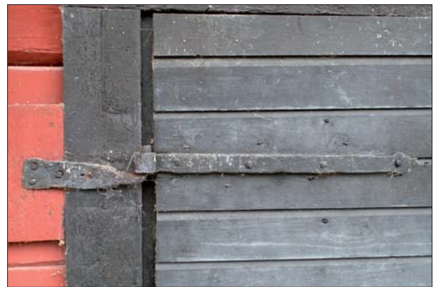
Smitt bandgångjärn på den nordvästra dörren.
