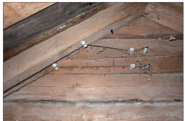
Elledningar av textil och isolatorer av porslin.
