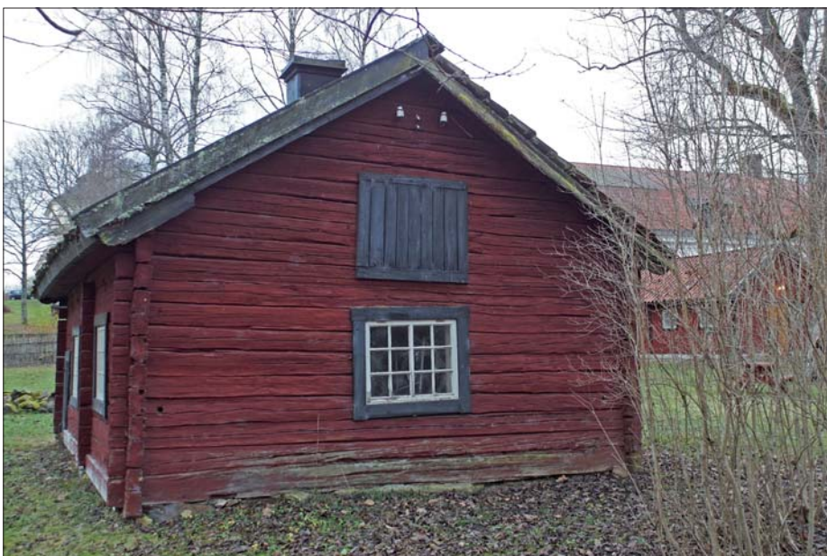
Östra gaveln med lucka upp till vinden.
