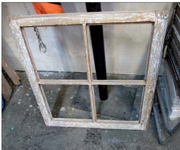
En av två ursprungliga fönsterbågar som renoveras i verkstaden.
