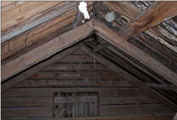
Nock mot väster med taksparrar, rötskador på bräddtak.
