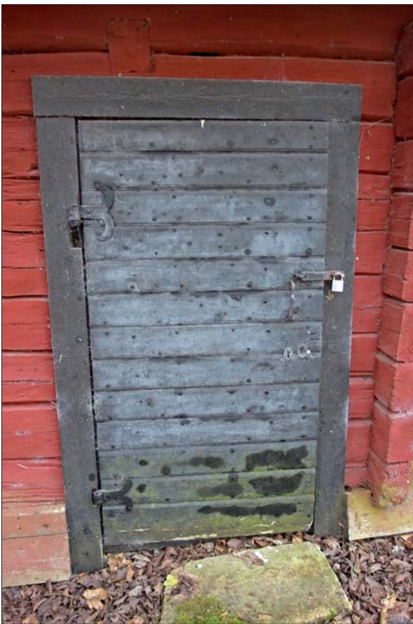
Dörr mot nordöst klädd med pärlspontpanel. Kalksten framför ingången.
