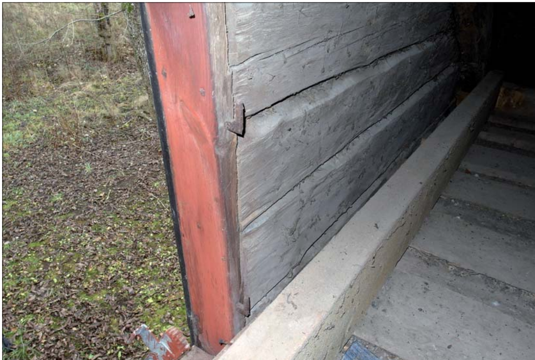
Gavelröste med gångjärn med öppning mot öster.
