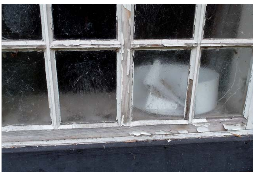
Fönsterbågar med skador, kittbortfall.
