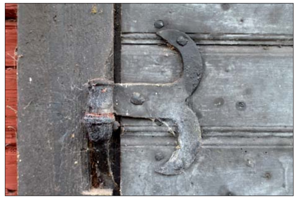
Smitt gångjärn av äldre typ på nordöstra dörren.
