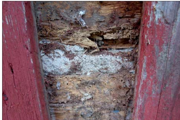
Rötskador bakom brädinklädningen.
