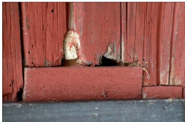
Gammal skada över ett av fönstren på norra sidan.
