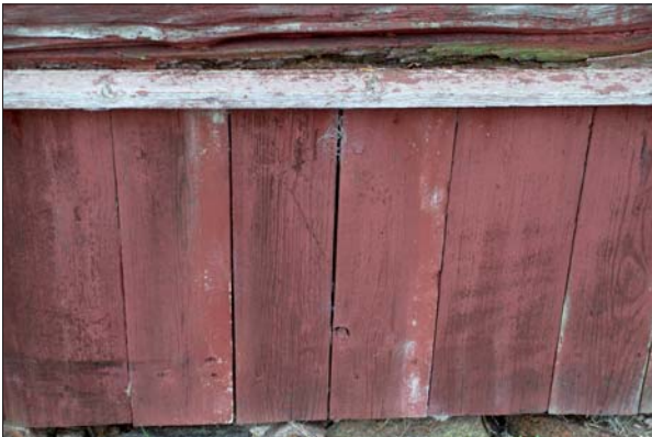
Brädinklädning på nederdelen av västra gaveln.
