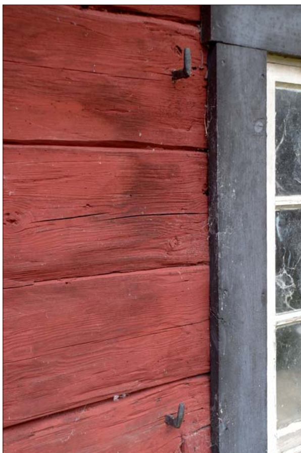
Gångjärn efter fönsterluckor, på södra långsidan.
