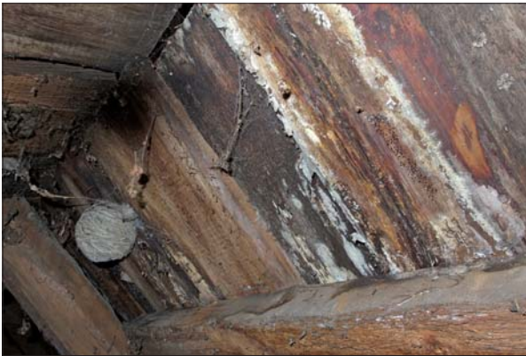
Rötskador på bräddtak.
