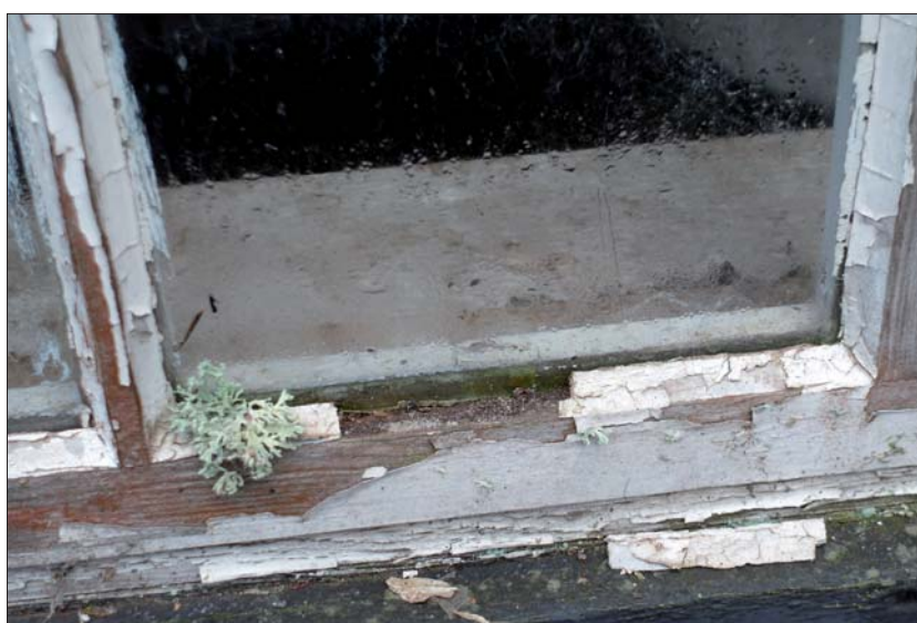
Fönsterbåge med kittbortfall och flagnande målning. Under den vita kulören finns en rödbrun kulör.
