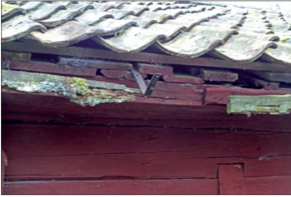
Krokar efter hängrännor, rötskadade takfotsbräda.
