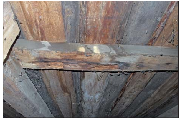
Rötskador på horisontell läkt.
