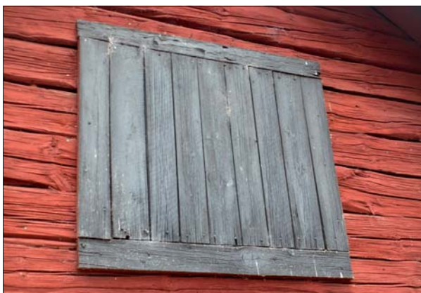
Igenspikad öppning på den östra gaveln.
