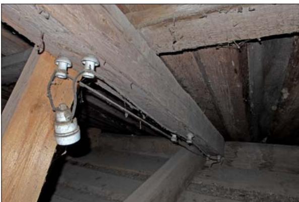
Elledningar av textil och isolatorer av porslin.
