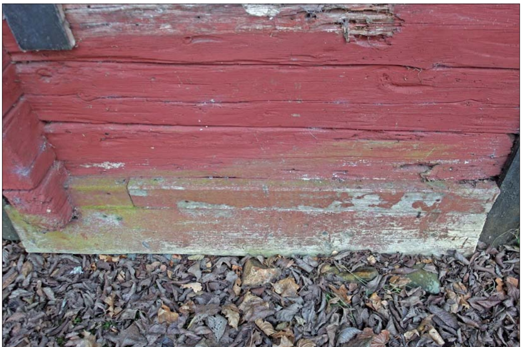
Syllen är kompletterad med brädor på båda långsidorna.
