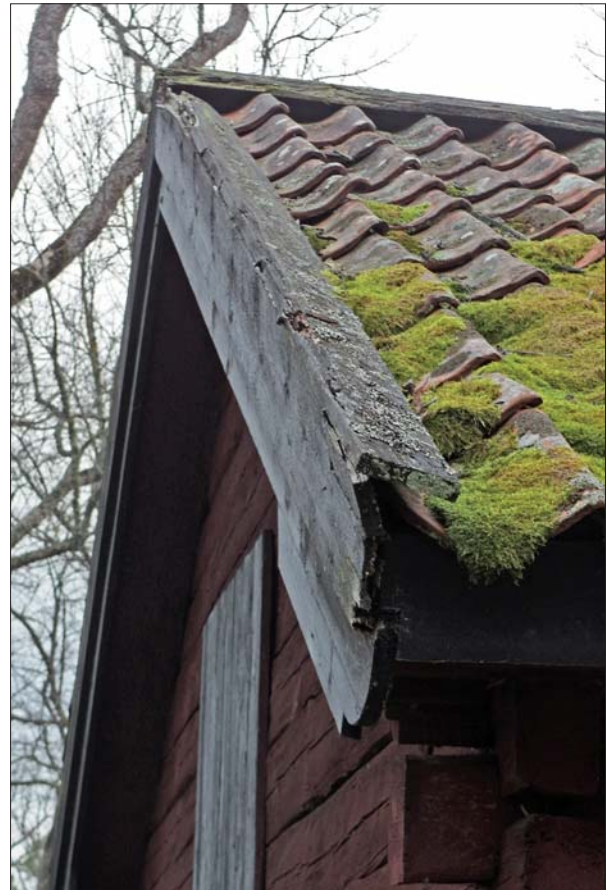
Vindskiva och skurlist som är mycket rötskadade.
