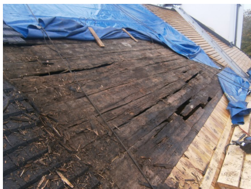
Skador i taktron. Foto Hälsinge Takspån.
