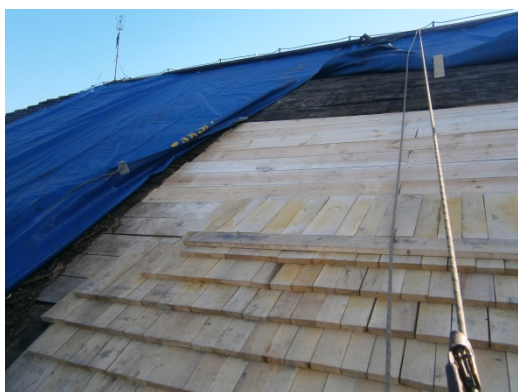
T v: lagning av taktrons med nytt furuvirke. T h: trasig taknock, som byttes ut. Foto Hälsinge Takspån.
