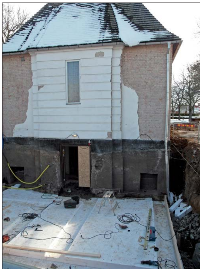
Grundarbeten för tillbyggnaden. Runt gravkapellet har grävts för dräneringsarbeten och fasadens puts har knackats ned.
