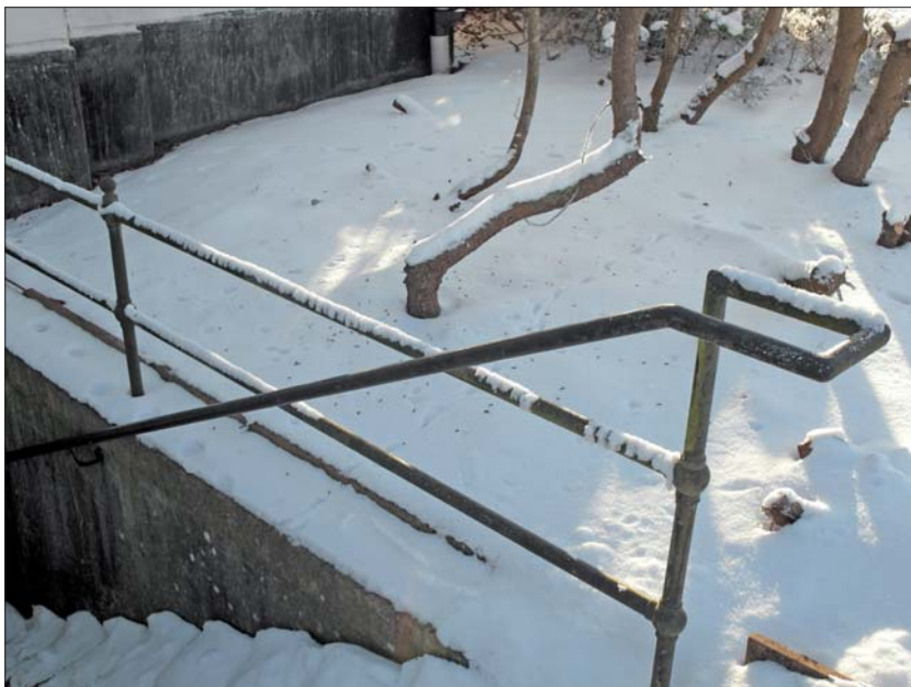
Källarens trapp- räcke gick att återanvända.
