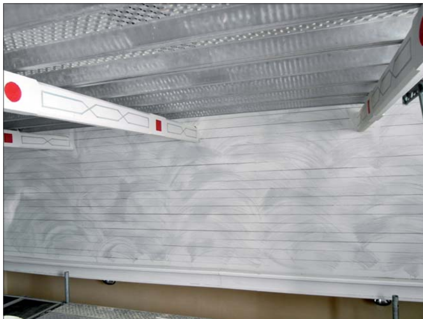
Tak och tvärbalkar har rengjorts
