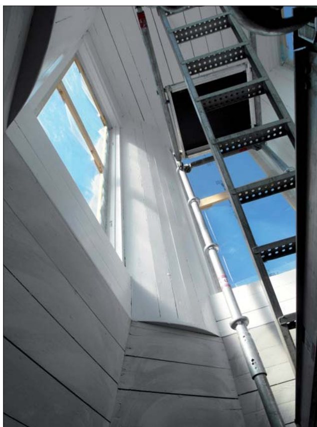
Lanterninens väggar målades med linoljefärg i befintlig vit kulör.
