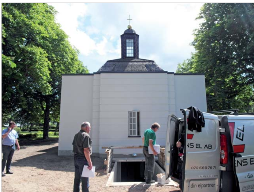
Tillbyggnaden från norr. Den nya norra väggan är mer dominant i verkligheten än vad den verkar på ritningen.
