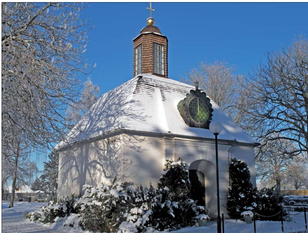
Gravkapellet från sydväst, innan arbetet påbörjades.
