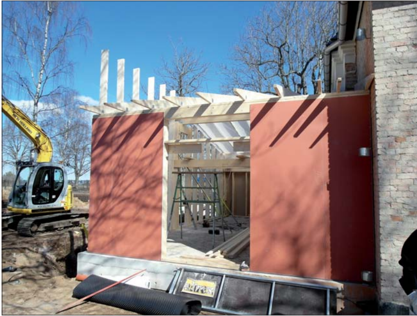
Tillbyggnaden från väster.
