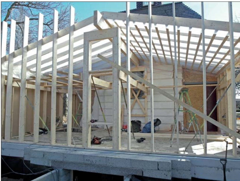
Tillbyggnaden från norr.
