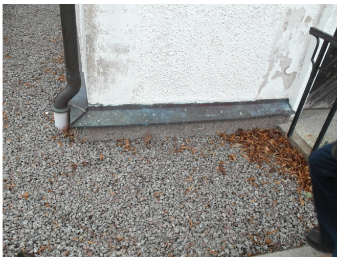
Färgsläpp på de slätputsade partierna i väster.
