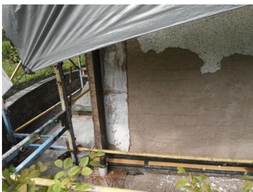
Spritputsens är nerknackad på södra fasaden.
