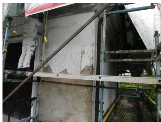
Takfotsinklädnanden av plåt renskrapas.
