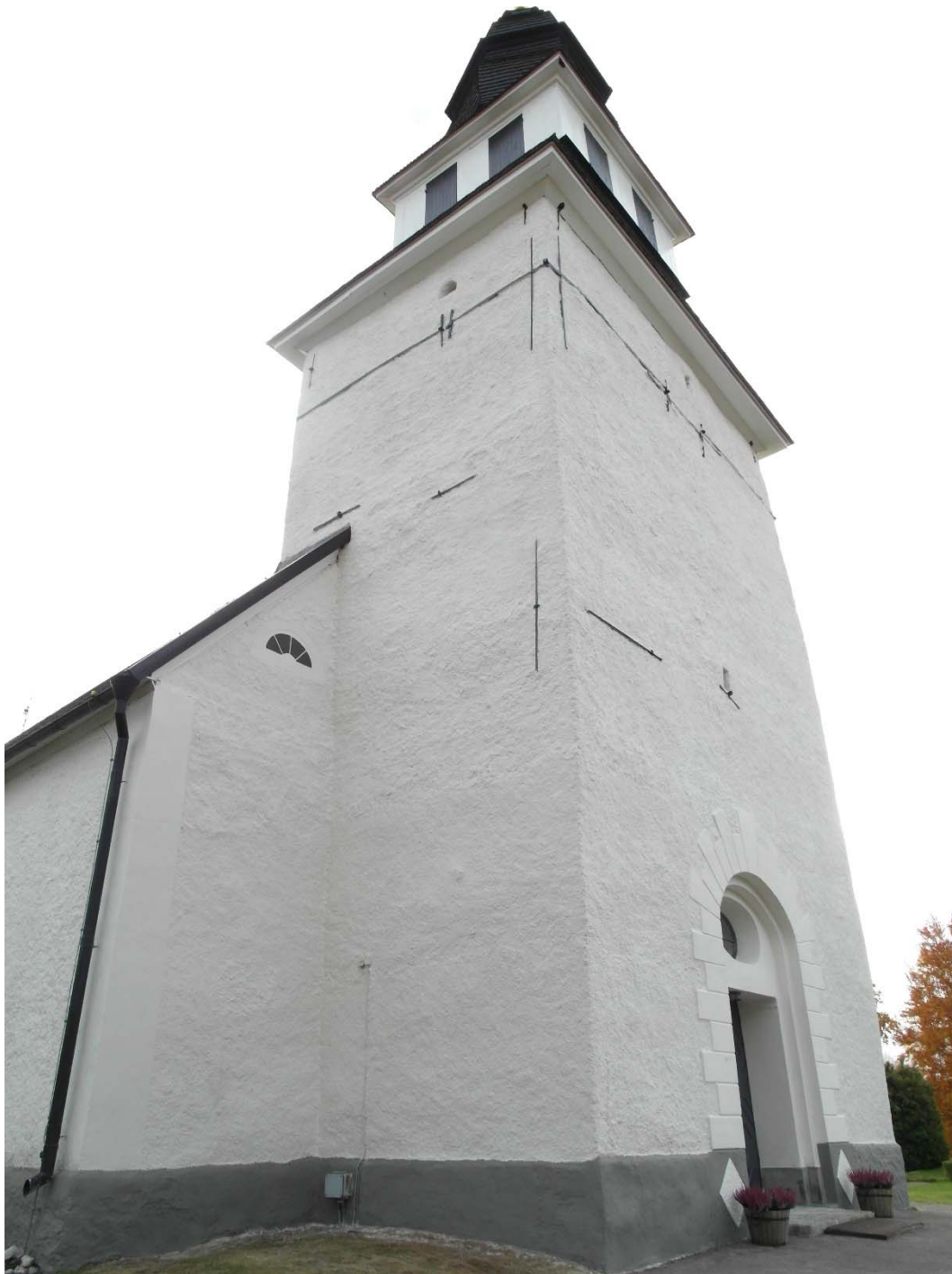
Tornet från nordväst efter slutfört arbete.
