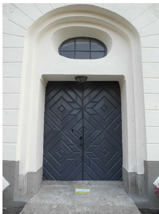
Västportalen är färdigställd.
