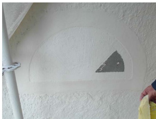
Norra lunettfönstret är ett blindfönster.
