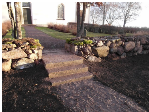
Trappan i södra muren före och efter justering. Trappan hade satt sig och ett av stegen sjunkit inåt.
