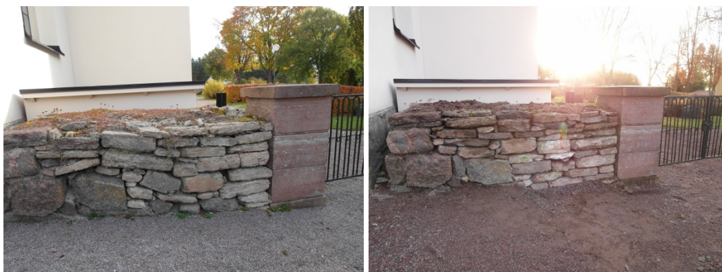
Mur vid sydvästra grinden före och efter renovering.
