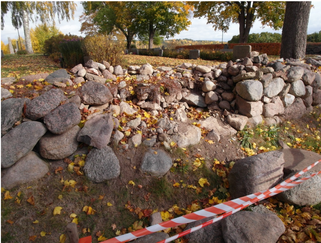
Den mest omfattande murskadan i södra muren.
