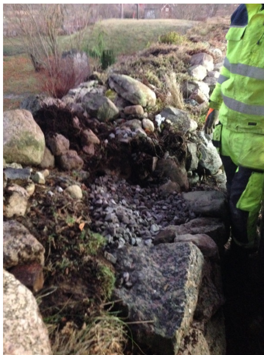
Fyllningen kompletterades med grovt singel. Södra respektive västra muren. På västra murens norra del gjordes lagningar på kyrkogårdssidan. Foto Kent Norrman.
