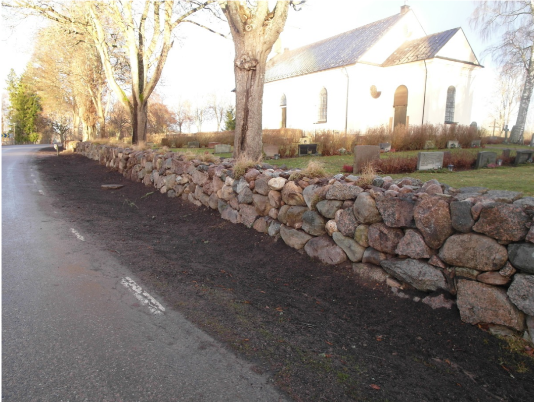
Södra muren efter renovering.
