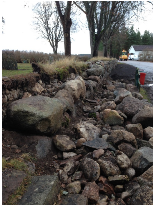
T v: den södra murens konstruktion. T h: delar av muren har plockats ned. Foto Kent Norrman.
