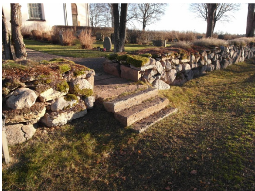
Trappan i södra muren före och efter justering. Trappan hade satt sig och ett av stegen sjunkit inåt.
