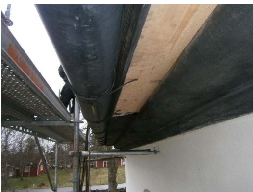
Utbytt del av takfoten. Foto Hälsinge Takspån. Utbytt del av taktron.
