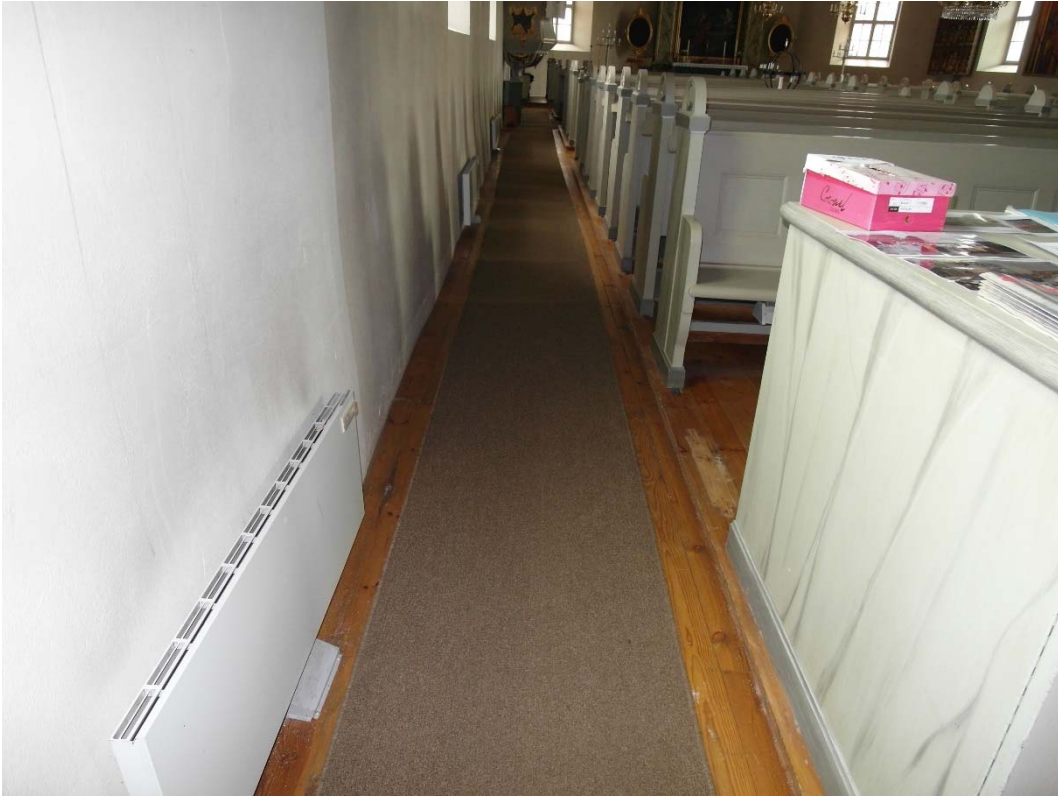
Äldre vägg radiatorer.
