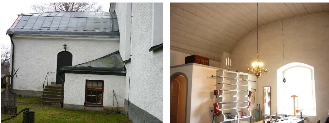
T v: Pannrummet ligger i hörnet mellan sakristian och norra långhusväggen. T h: I den lilla inbyggnaden i sakristian ryms WC och ett förrum. I den välvda öppningen skimtar dörren ut till kyrkogården. Foto Östergötlands länsmuseum 2004.
