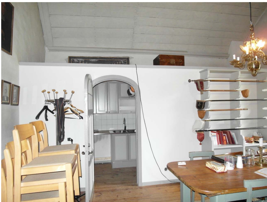
Den nya väggen är färdig och det mesta av pentryts inredning är monterat.
