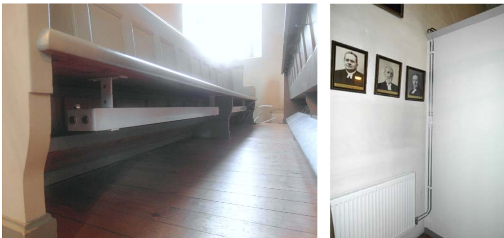
T v: I de båda främre bänkkvarteren sitter nya vattenburna bänkvärmare. T h: Rördragning i sakristian. Rören går att måla in i väggfärgen.
