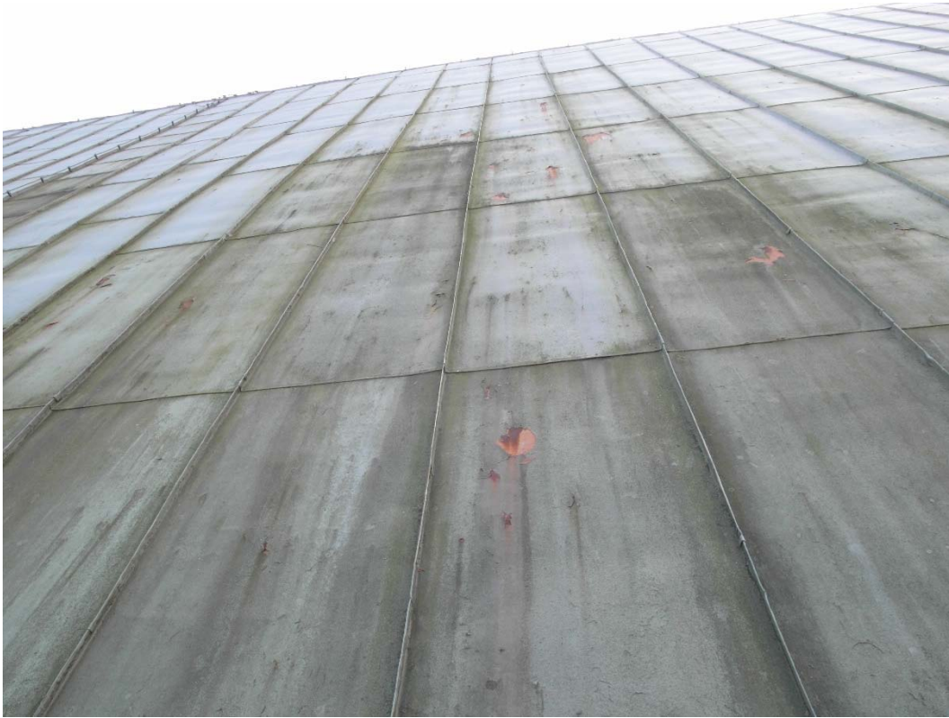
Befintlig takplåt på långhuset.
