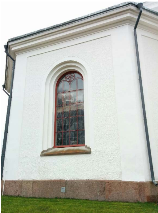
T v: En hyvlad bräda täcker den tidigare springan under plåtkanten. Takfotens utseende har ändrats något, men ger ett mer genomarbetat intryck. T h: Cementholkarna täcks med kupolgaller. På norra sidan sitter nytillverkade stuprör.
