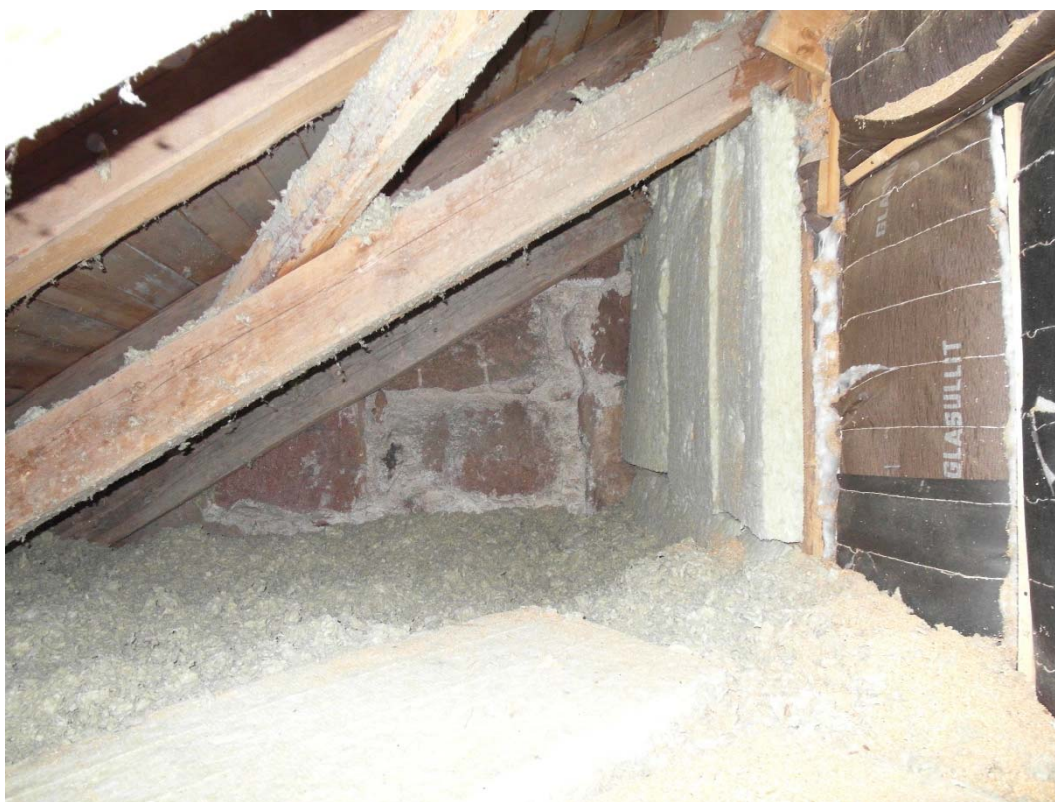
Tidigare vindsisolering. Foto mot västväggen.
