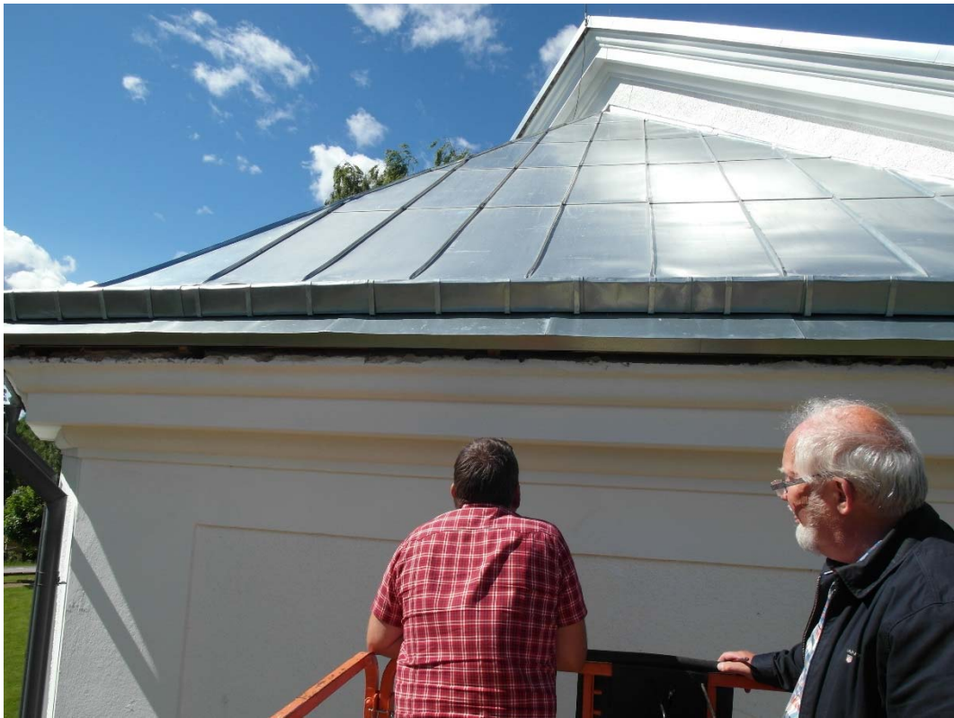
Granskning av springan som blivit mellan plåt och takfot i samband med att taket har höjts.
