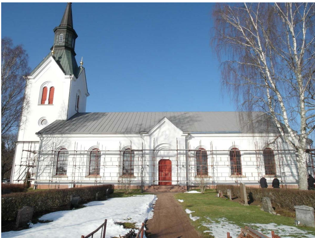
Västra Ryds kyrka. Ställningsarbete.
