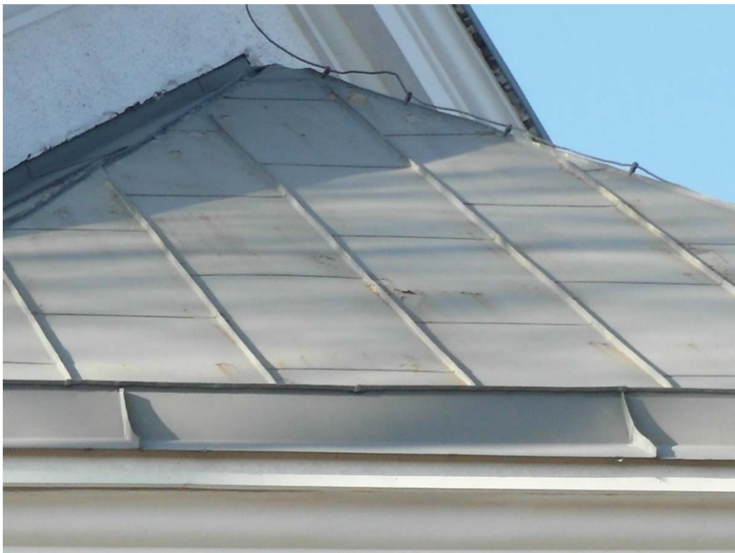
Befintligt tak på sakristian.
