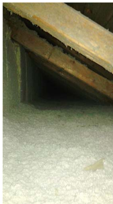
Vindsluckan vid orgelläktaren försågs med ett handtag. Befintlig isolering på vinden utökades. Foto Camilla Jacobsson, Ydre pastorat.
