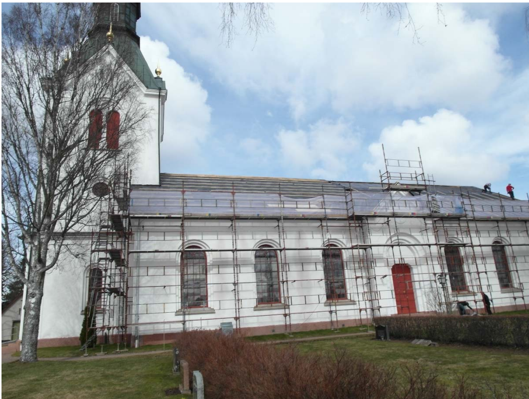
Läktning för det nya taket pågår.
