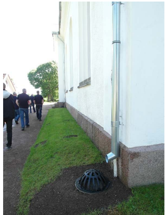
T v: En hyvlad bräda täcker den tidigare springan under plåtkanten. Takfotens utseende har ändrats något, men ger ett mer genomarbetat intryck. T h: Cementholkarna täcks med kupolgaller. På norra sidan sitter nytillverkade stuprör.
