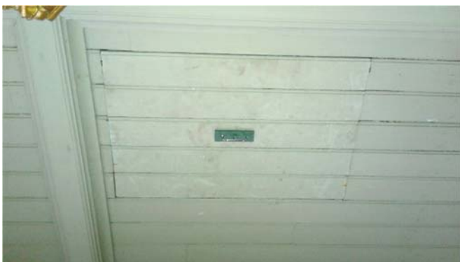
Vindsluckan vid orgelläktaren försågs med ett handtag. Befintlig isolering på vinden utökades. Foto Camilla Jacobsson, Ydre pastorat.
