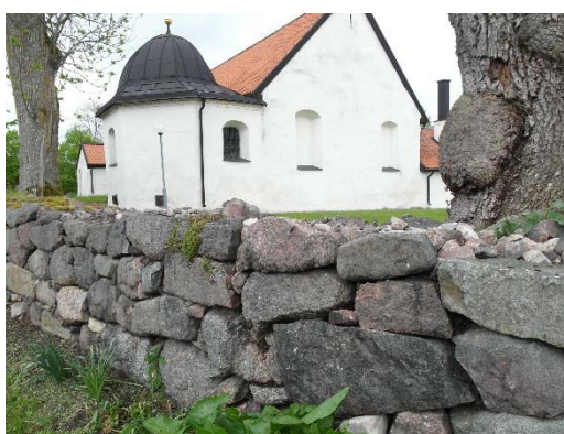
En del av södra muren lades om i anslutning till en stor ask.
