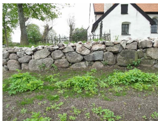
På större delen av norra mursträckningen plockades krönet om.
