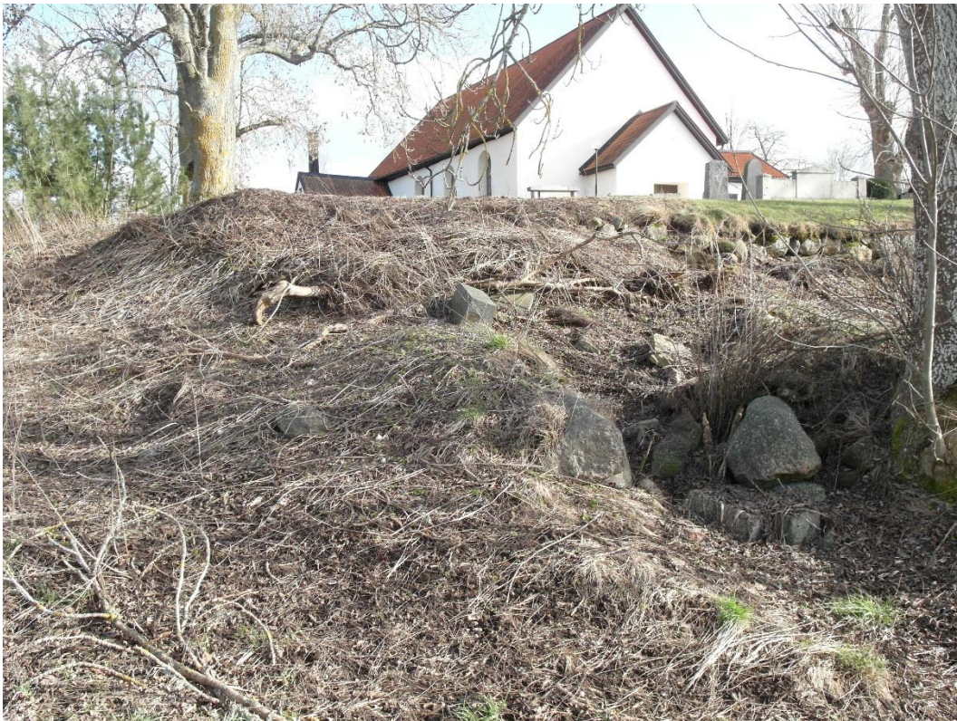
Nordvästra murhörnet före renovering. I förgrunden syns rester av en jordkällare.
