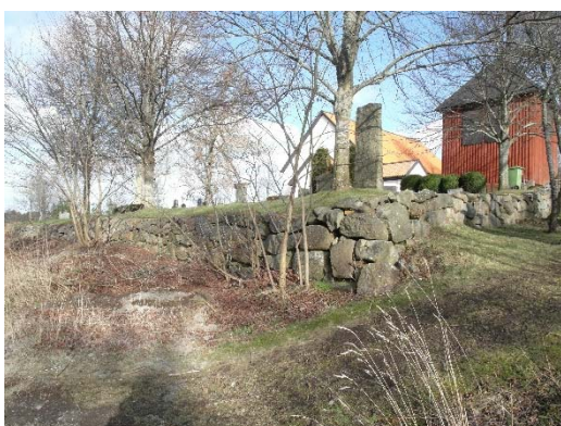
Hela västra muren lades om. Dessutom gjordes en ny släntning av kyrkogårdsmarken, som här ligger högre än muren. Utanför muren har vegetationen närmast muren röjts bort.
