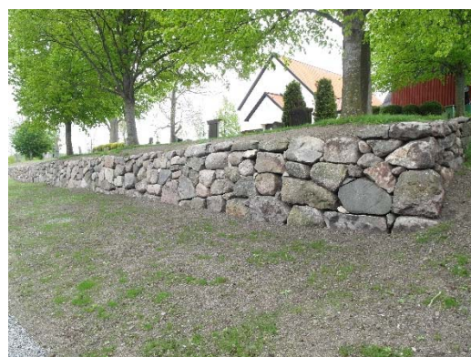
Hela västra muren lades om. Dessutom gjordes en ny släntning av kyrkogårdsmarken, som här ligger högre än muren. Utanför muren har vegetationen närmast muren röjts bort.
