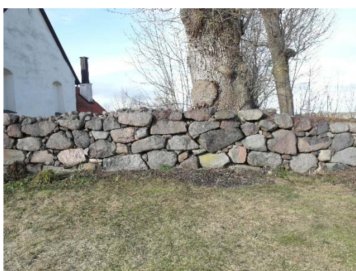
En del av södra muren lades om i anslutning till en stor ask.
