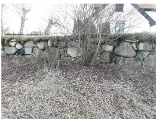
På större delen av norra mursträckningen plockades krönet om.
