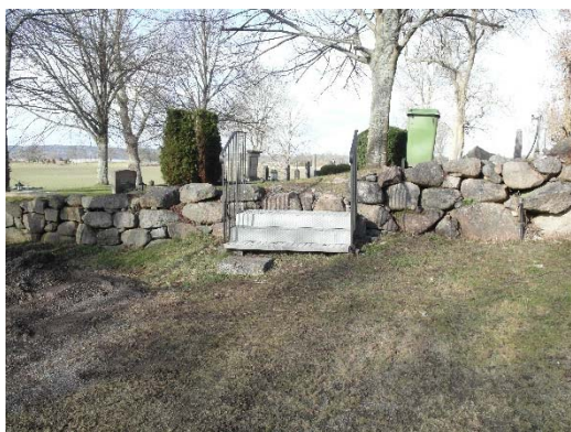
Södra muren före och efter renovering. Omläggningen gjordes inte lika omfattande som förslaget föreskrev.
