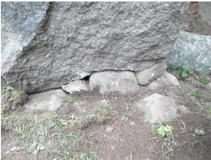
Kilning av grundstenen med mindre stenar.
