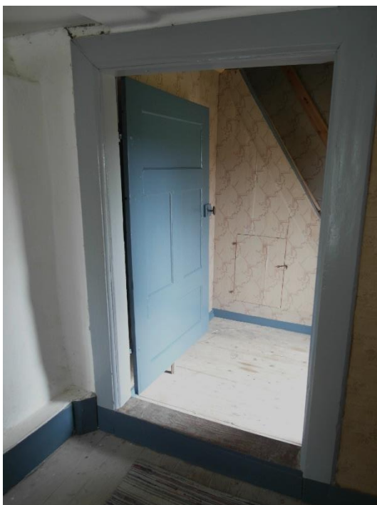
Hagalund även foder och dörrblad mellan förstuga och stugan är nymålat.
