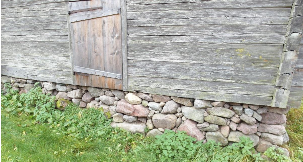
Grunden efter genomfört arbete, mot norr.
