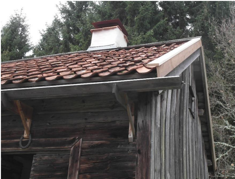
Hagalund efter byte av skurlister och en vindskiva.
