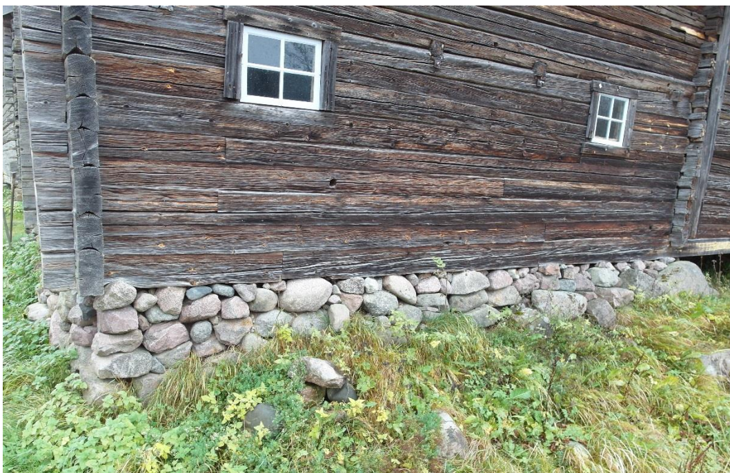
Ladugården A6, grundstenarna är åter på plats med hjälp av hydrauliskt kalkbruk.
