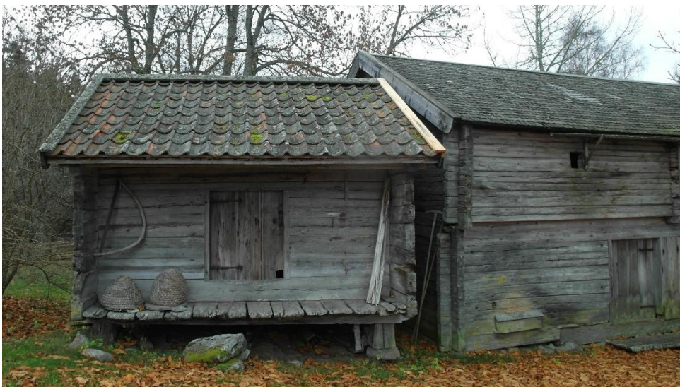
Efter byte av tre skurlister på stolpboden.
