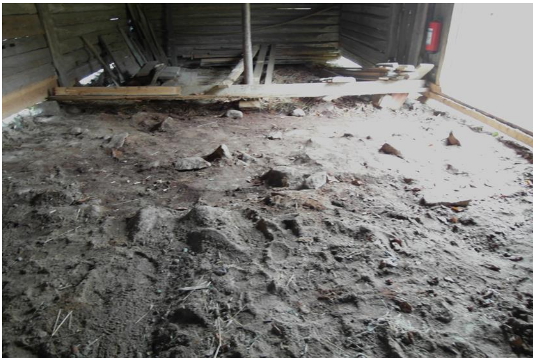
Utgrävning av jord och hussvampsangripet virke.
