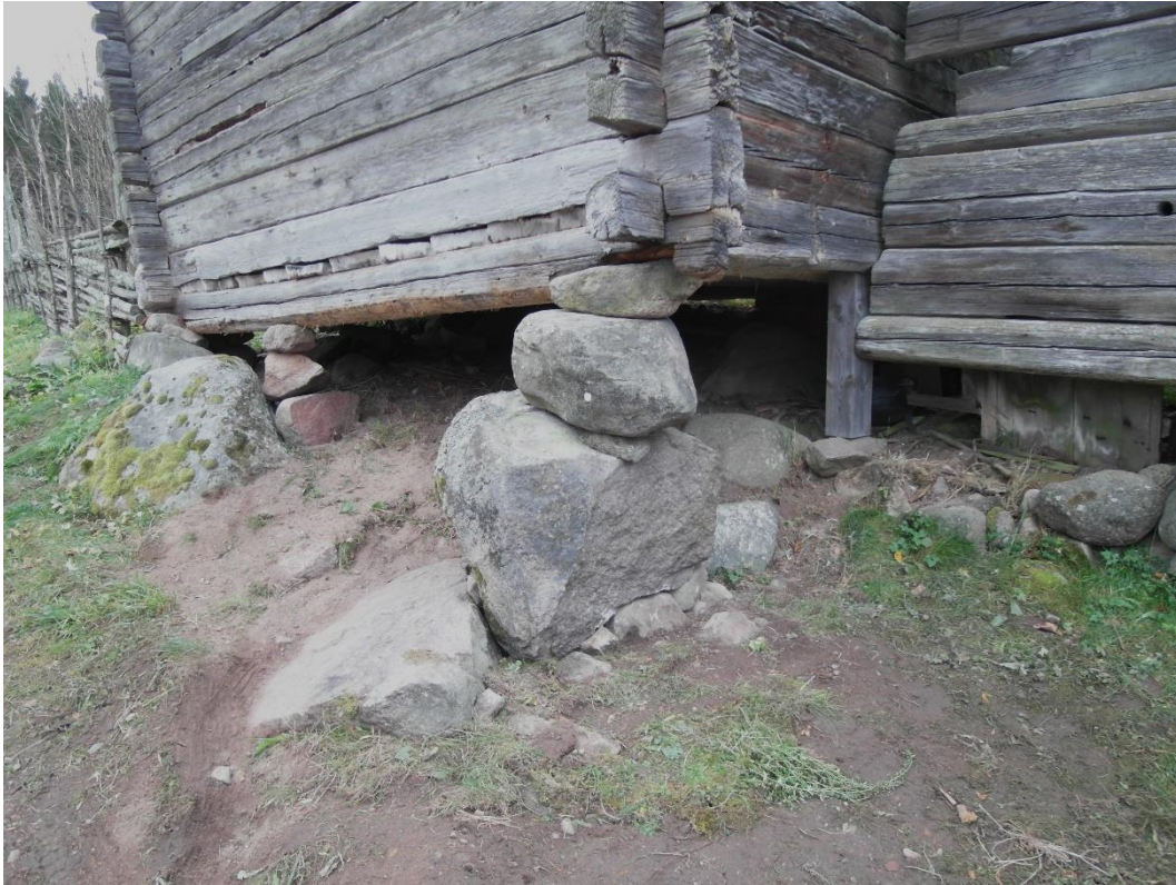
Stenupplag vid visthusboden A 2 efter upprätning och omläggning av stenar.
