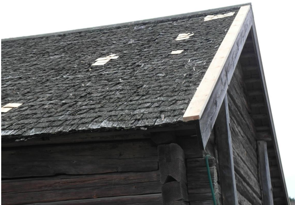
Loge A 7 med en av fyra nya skurlister och upplagning av sticketak.
