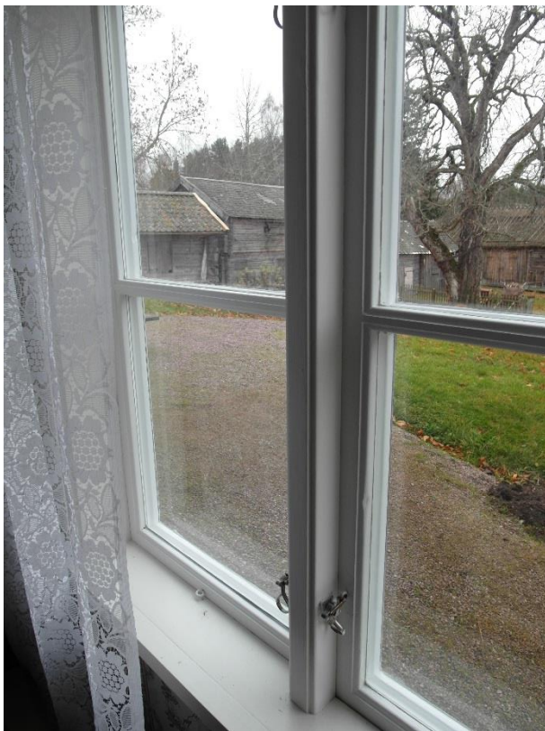
Målning av de kopplade innerbågarna.
