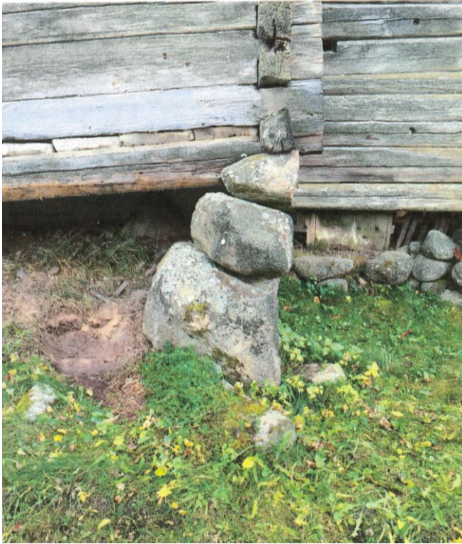
Visthusboden A 2 med stenupplag som håller på att "kalva".
