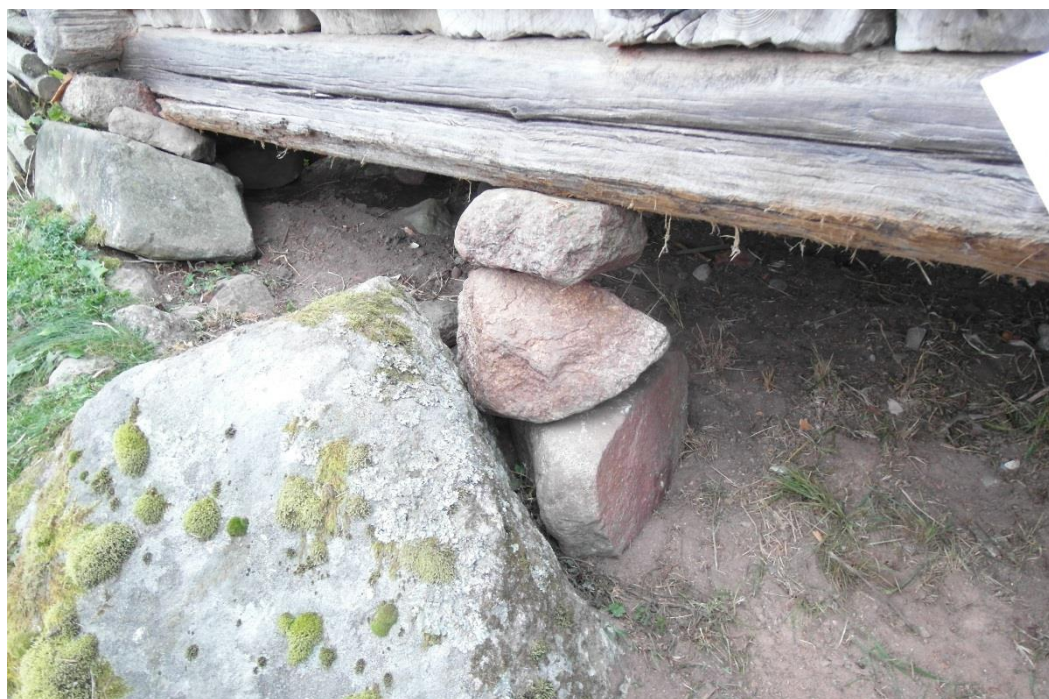
Förstärkt upplag med en sten, norra långsidan.
