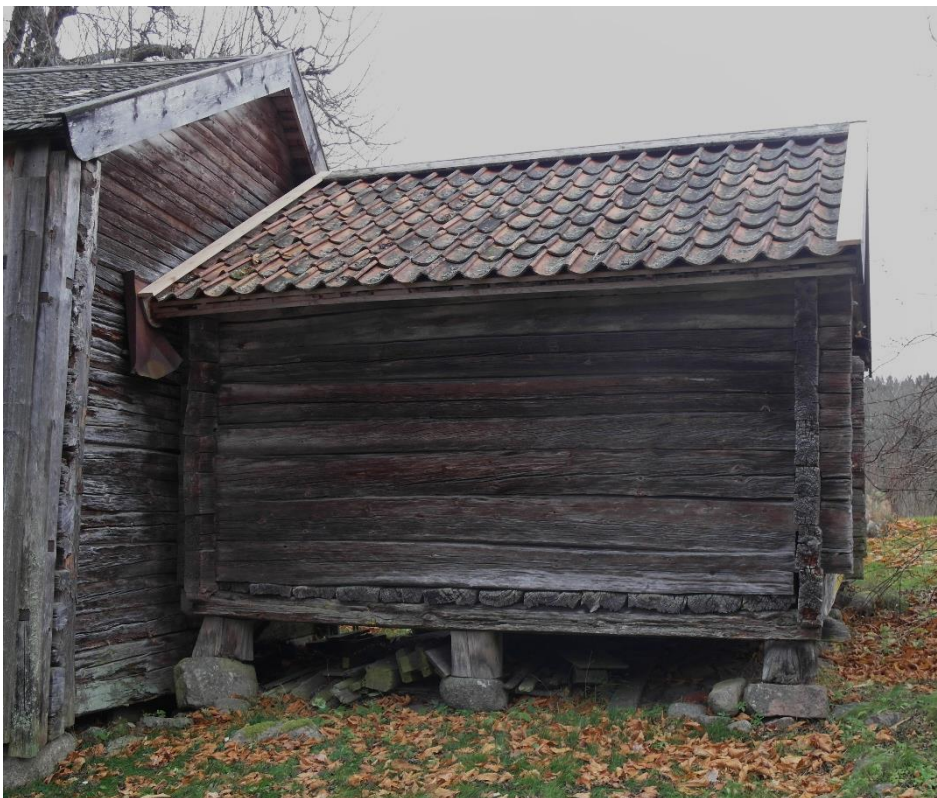
Stolpboden efter byte av skurlister.
