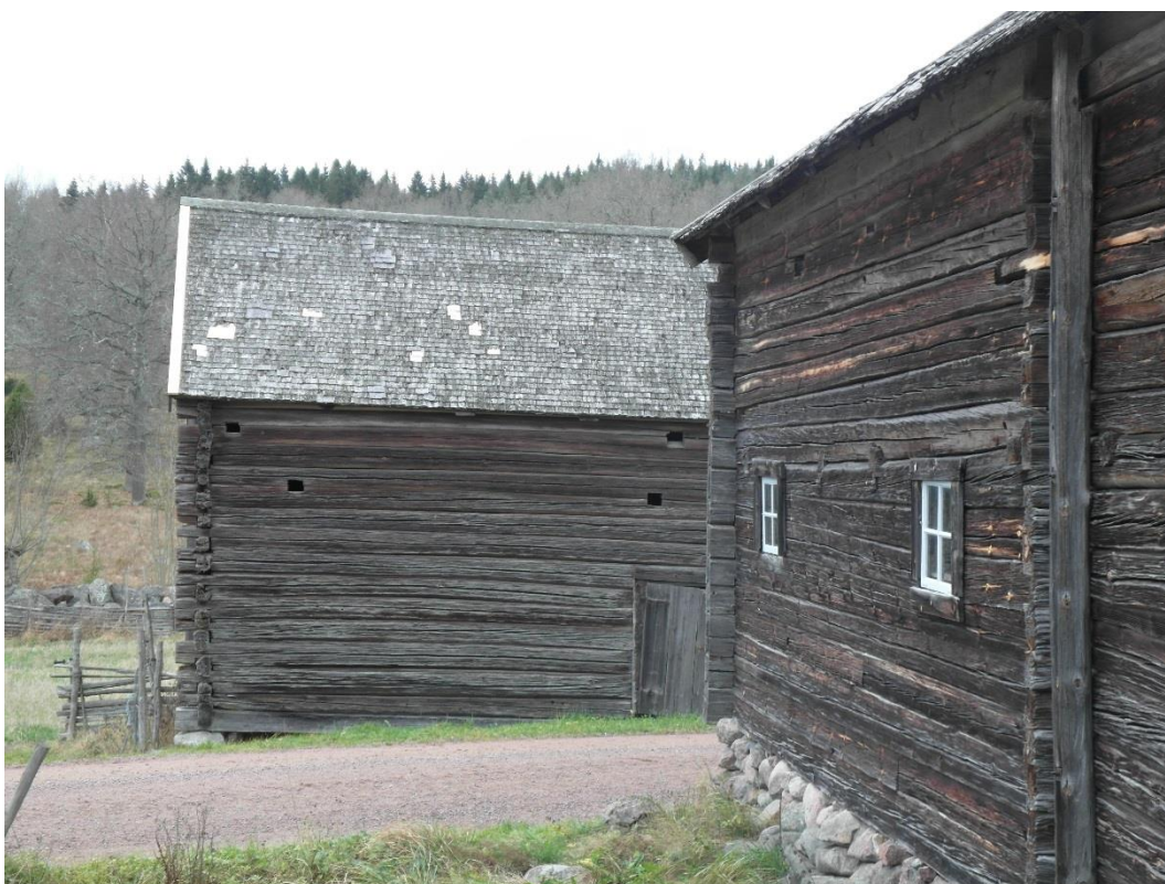
Loge A 7 efter byte av skurlister.
