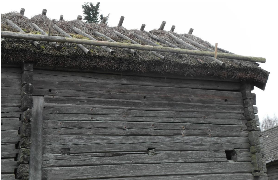
Stall/lövlada, upplagning med horisontell slana på plats och ny dymling på norra takfallet.
