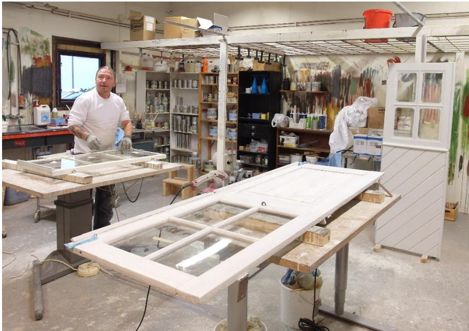
Mellanstrykning pågår i verkstaden.
