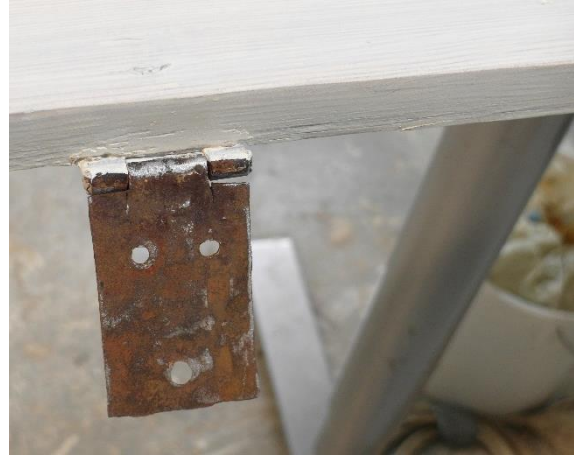
Innerdörr stuken med järnoxidgult S 3050 – Y 20R. Gångjärn före rostskyddsbehandling.
