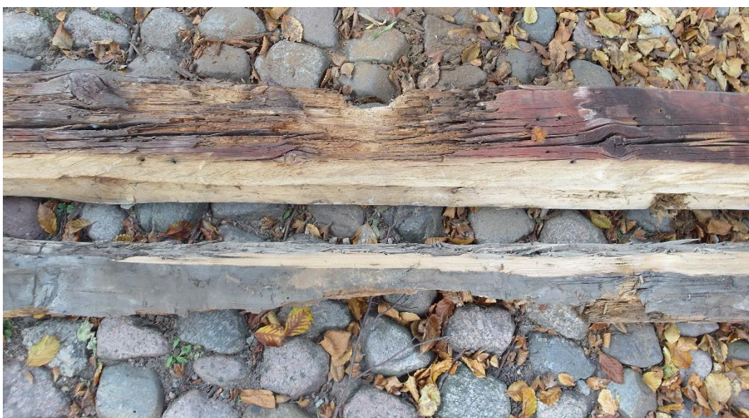
De båda rötskadade stockarna.
