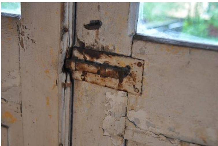
Flagnad färg och rostigt lås på ytterdörrens insida.
