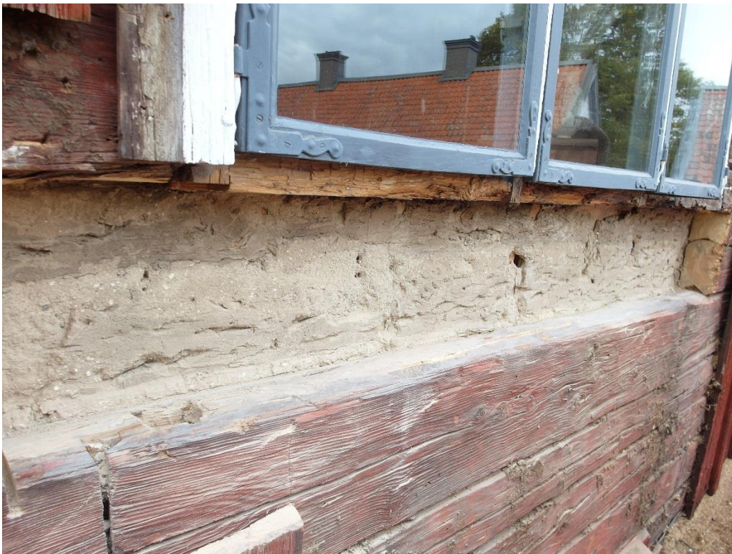
Lerkliningan sitter kvar fast två stockar är borta.
