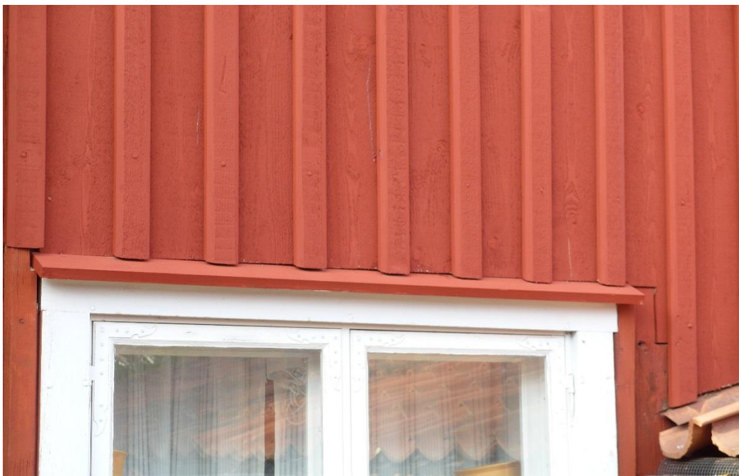
Ny panel mellan fönstren och en ny vattbräda över fönstret.
