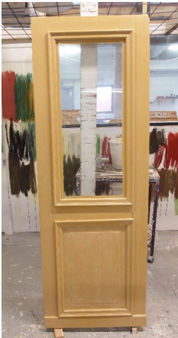
En av de ådringsmålade innerdörrarna. Insidan av ytterdörren eftermålning.
