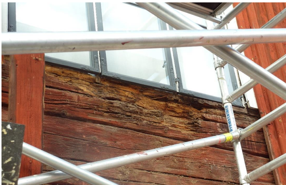
Rötskadan under fönstret.
