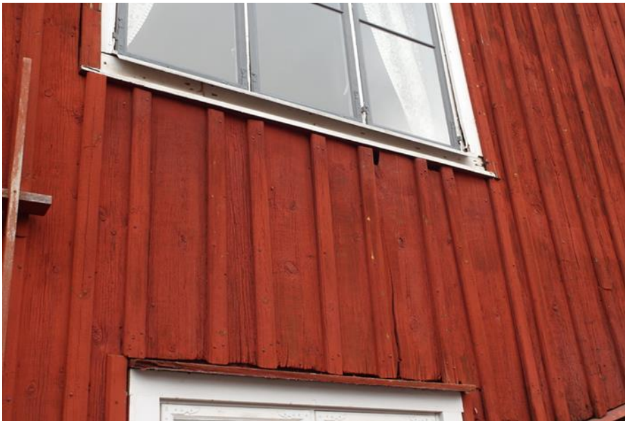
Trelufts-fönster med rötskador bakom panelen. Rötskadad vattbräda över bv fönster.
