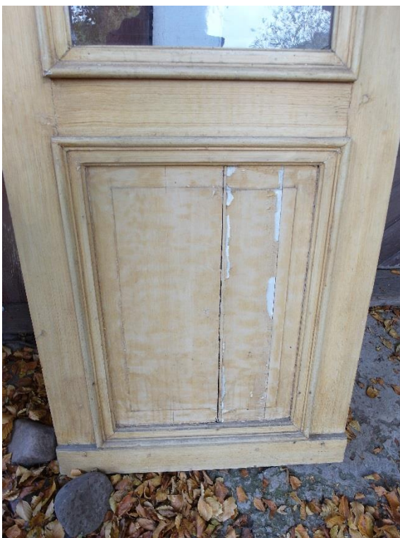
Innerdörr med ådring, som ska efterlikna björk, i spegeln.
