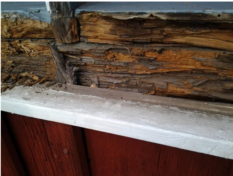
Synliga rötskador i under fönstret.
