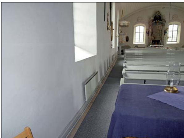
Norra långhusväggen med de äldre elementen.
