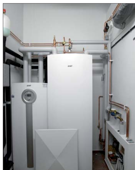
Apparatrummet i tillbyggnaden.
