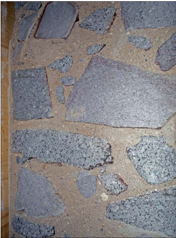
Detalj av västra snittytan.
