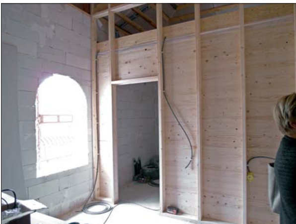
Innerväggarna är konstruerade med regler, råspont och gipskivor.
