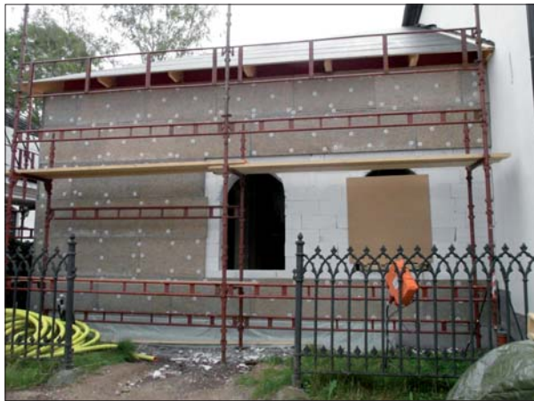
Tillbyggnadens stomme är av lättbetong och fri-bärande fackverktakstolar.
