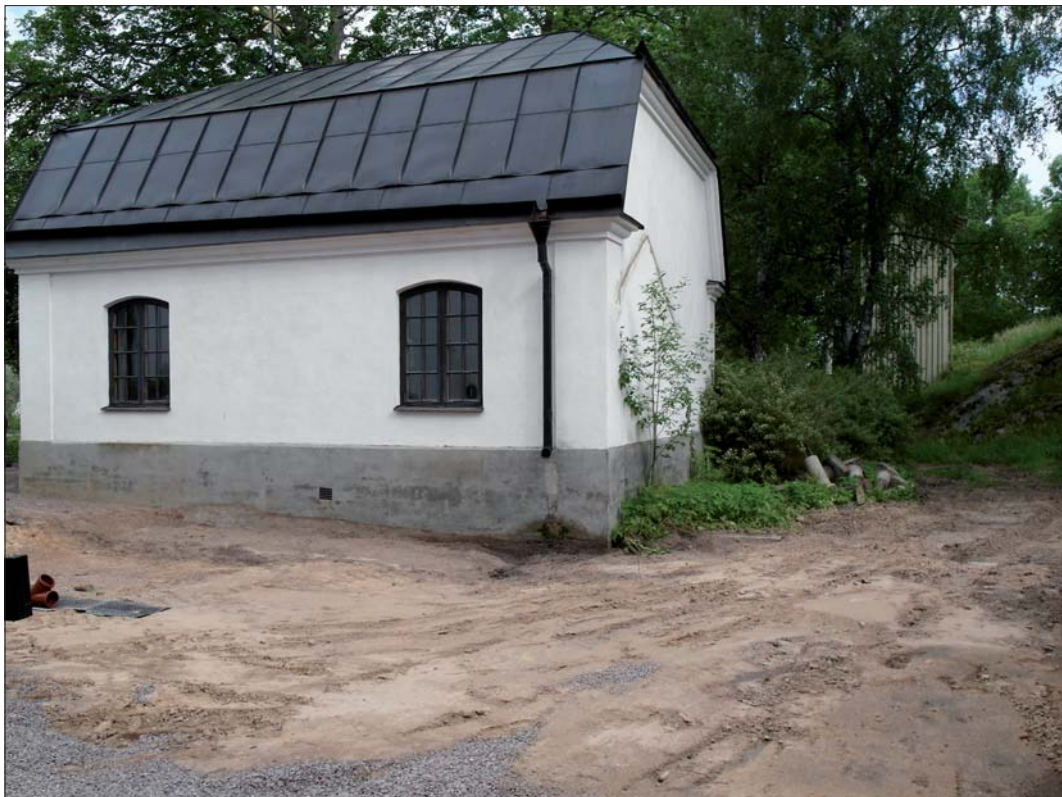
Markarbeten mellan tillbyggnad och gravkapell har påbörjats.
