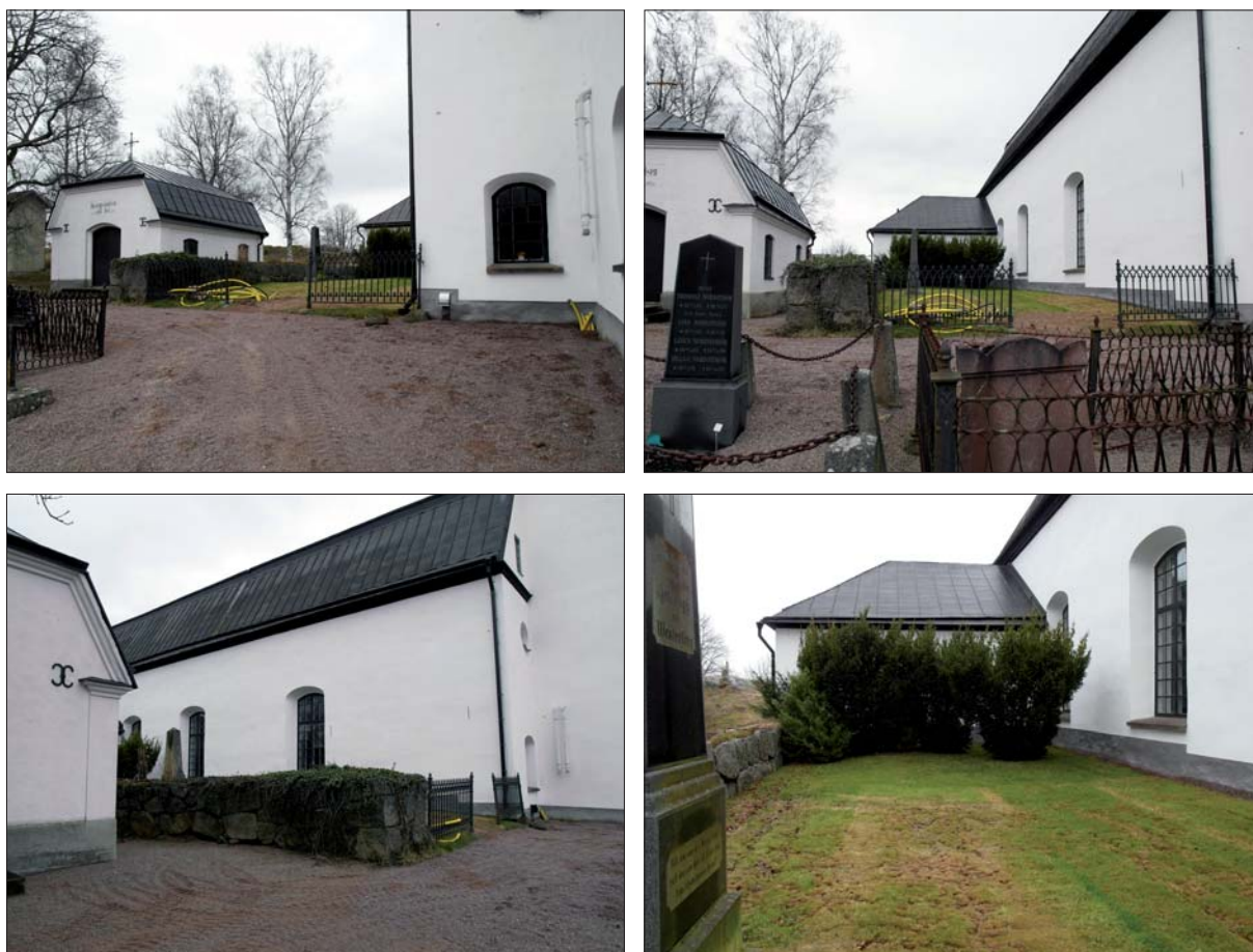
Fyra fotografier som visar området norr om kyrkan före tillbyggnad.
