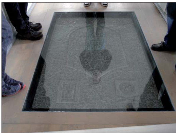
En glasskiva lades i den nya golvnivån över gravhällen i mittgången.
