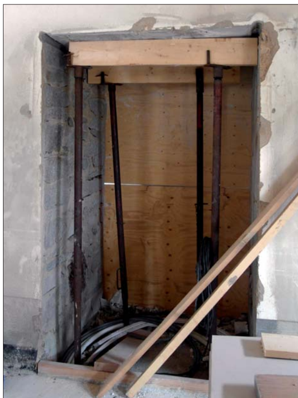
En dörröppning togs upp i norra långhusväggen. Till vänster syns den stock som löper i murverket.
