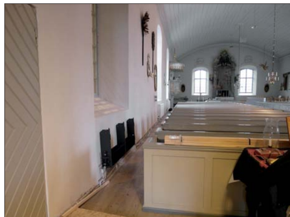
De nya konvektorerna monteras.
