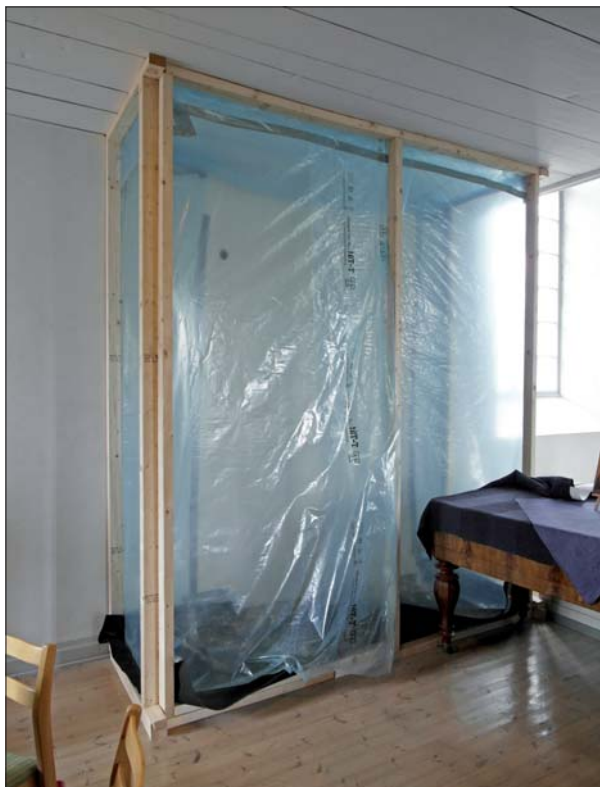
I kyrkorummet gjordes en intäckning för det nya dörrhålet.
