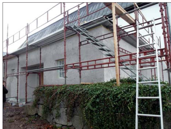
Utvändiga putsarbeten har påbörjats.
