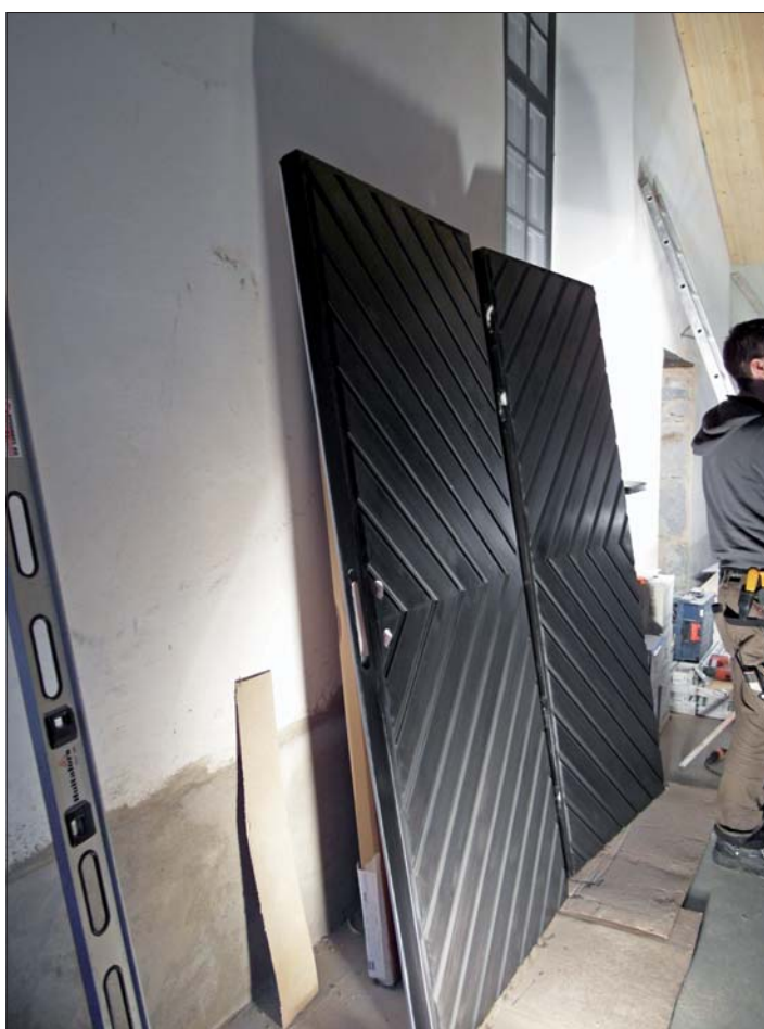
Tillbyggnadens ytterdörrar har målats.
