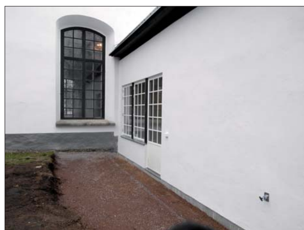
Tillbyggnadens östra fasad.
