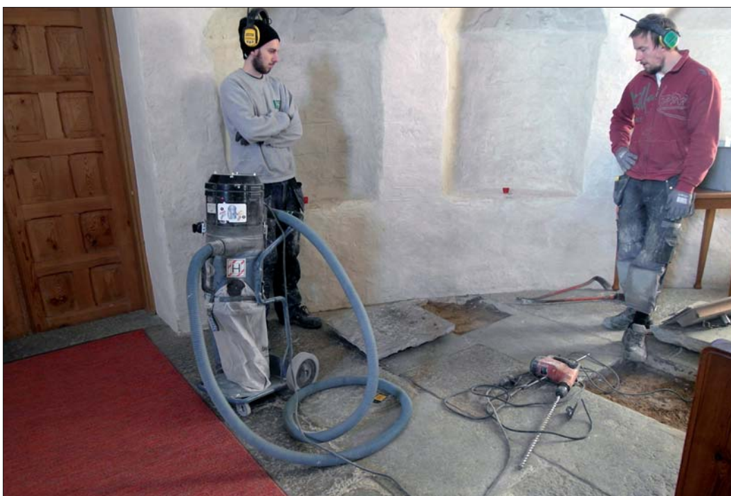
Golvet undersöktes där de nya pelarna skulle stå.
