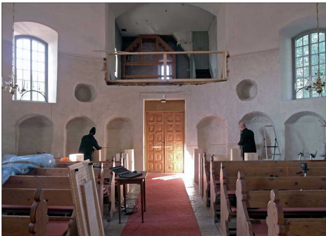
Den gamla läktarbarriären har tagits ned och nya läktaren mäts in.
