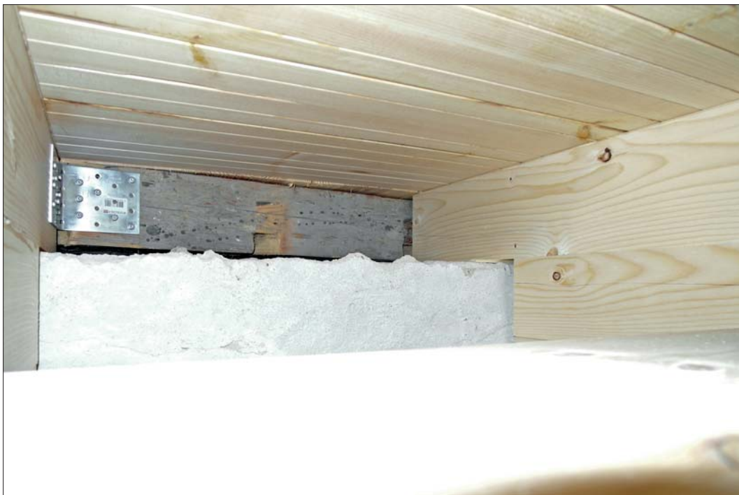
Anslutning med balksko till tornrummets golvbjälklag.
