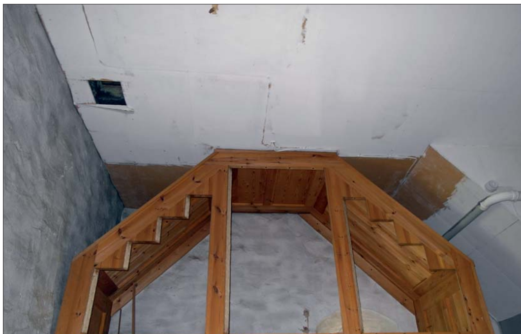
Taket i tornrummet var sedan tidigare klätt med skivor.
