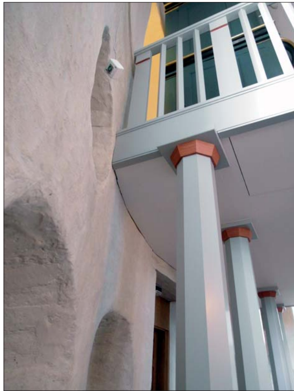
Anslutningen till väggen i söder.
