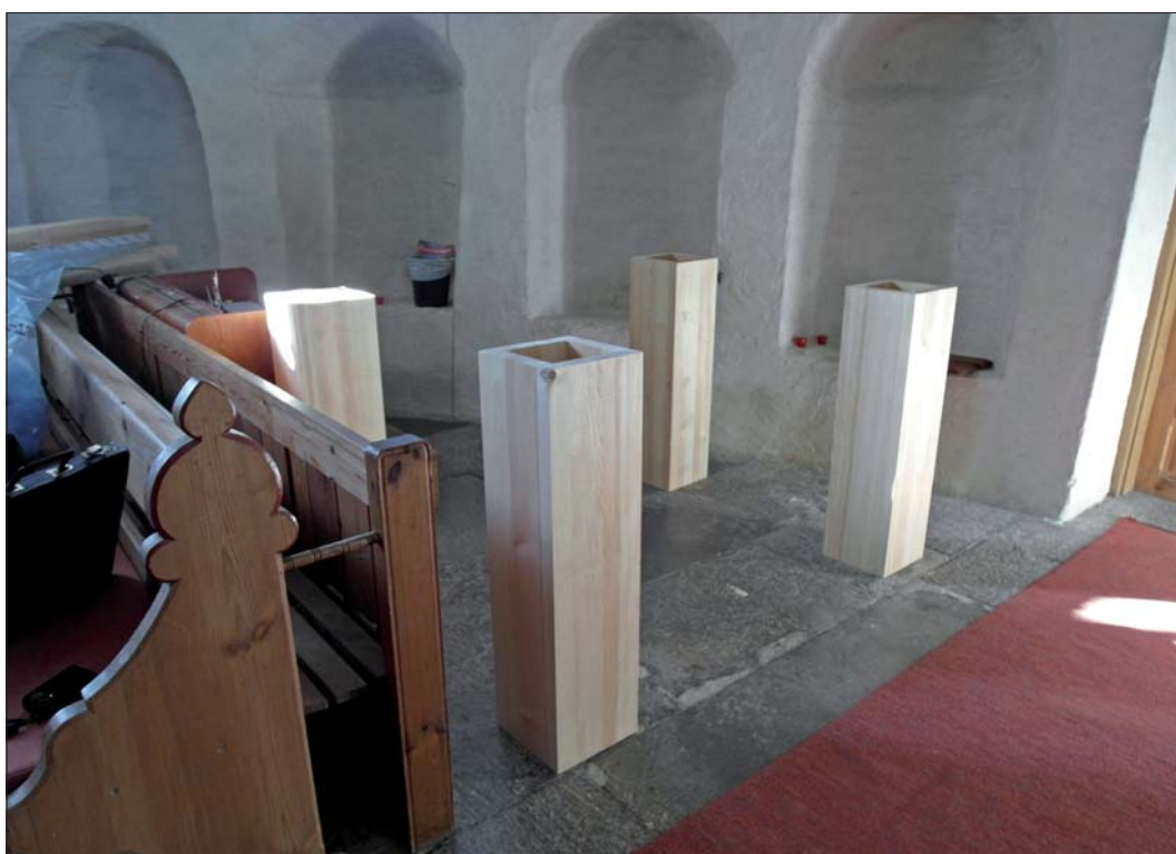
Bottendelarna till de nya pelarna.
