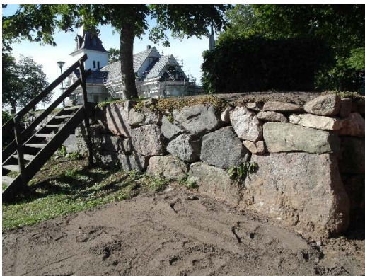
Den södra murens östra del är lagd med ett mer varierat stenmaterial och övergår i östra muren, som i vissa partier är lagd med obearbetad sten.
