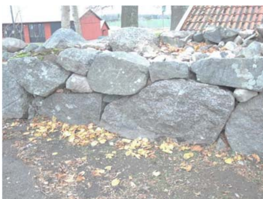
T v: Del av norra murens insida efter omläggning. T h: norra murens östra del, där muren har övergått till stödmur.
