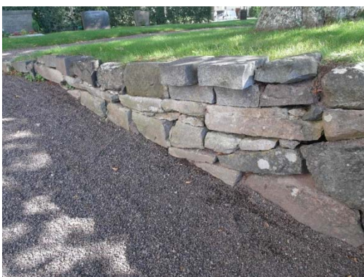
T v: Gången från västra grinden är kantad med murar i fallande höjd. Murarna är lagda med bearbetad gråsten och kalkstensskivor. T h: Innanför torningången står ett runstensfragment som hittades i bogårdsmuren på 1940-talet.
