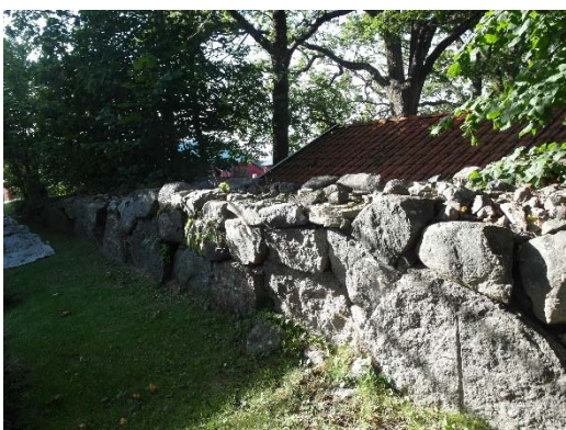
T v: Norra murens östra del från insidan. Det är en fullmur med enstaka stenar med skjutsöm. T h: Norra murens västra del från utsidan. Här är muren en stödmur med större andel kluven sten än i östra delen.
