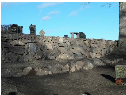
Huvudmur och stödmur efter omläggning.
