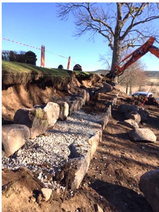
Nytt fyllnadsmaterial läggs bakom ytermanteln på både stödmur och huvudmur. Överst i stödmuren läggs ett lager jord. Foto Norrmans sten och markanläggning.
