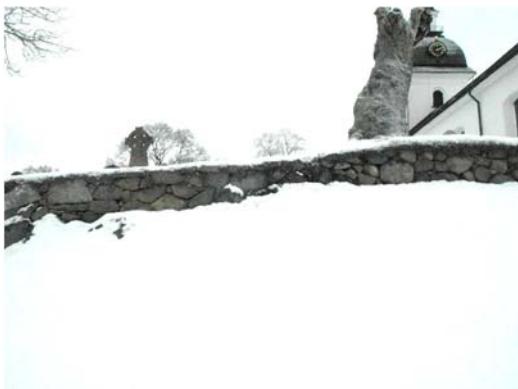
Den östra muren kan delas in i tre delar. T v: Längst i söder är muren uppbyggd av naturklivna stenar och därpå av mindre och rundare gråsten. T h: Den norra delen är uppbyggd av större klivna stenar.
