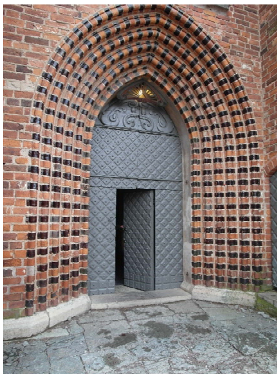
T v: Porten tätades med sadelgjord. Foto Fönster & Hantverk. T h: Västra porten efter ommålning och trälagningar.
