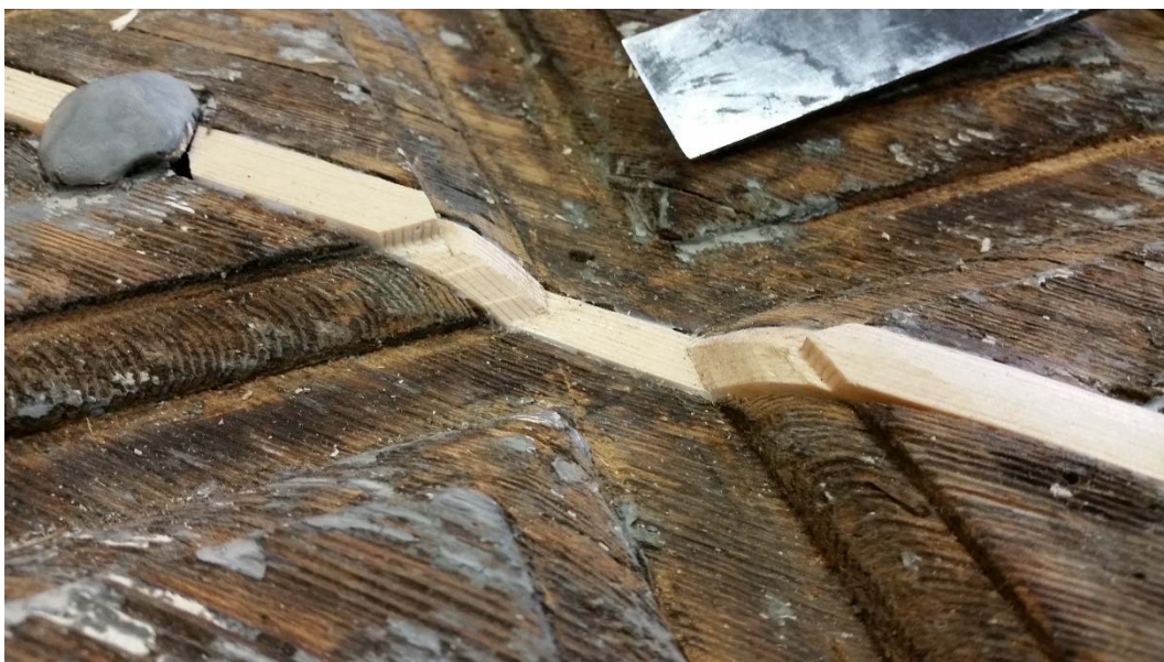
Trälagning. Foto Fönster & Hantverk.
