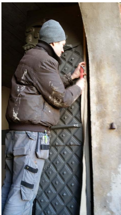
T v: Porten tätades med sadelgjord. Foto Fönster & Hantverk. T h: Västra porten efter ommålning och trälagningar.
