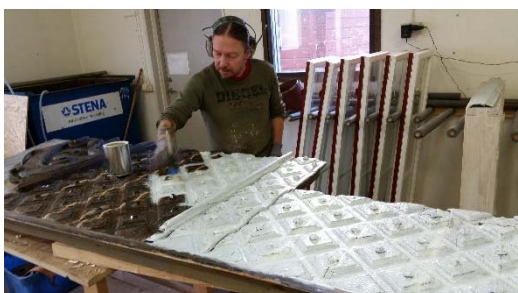
Halvoljning och grundmålning. Foto Fönster & Hantverk.
