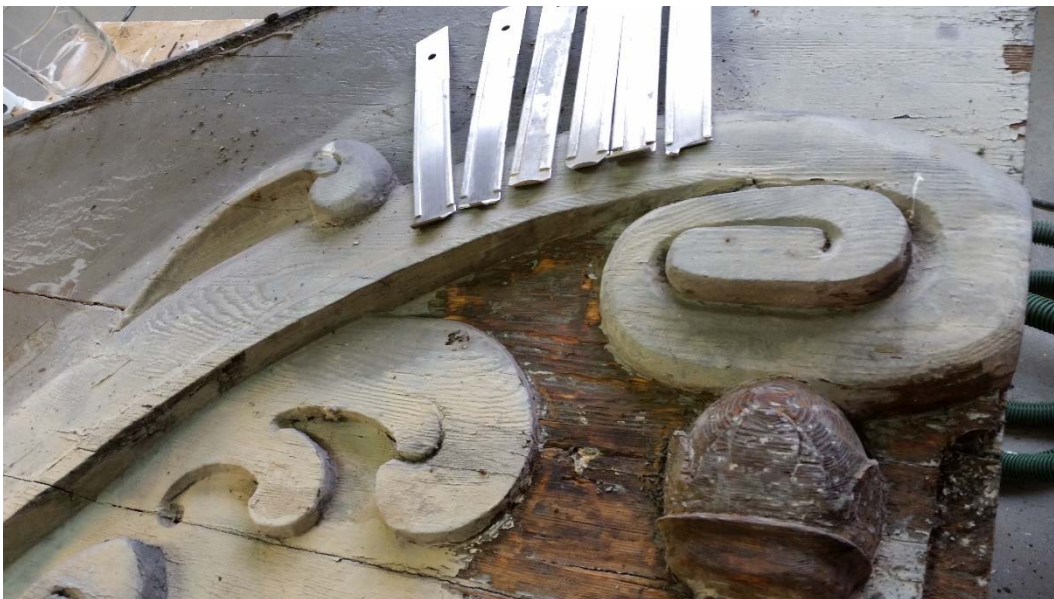
För att kunna skrapa porten tog man fram stål med olika profiler. Foto Fönster & Hantverk.
