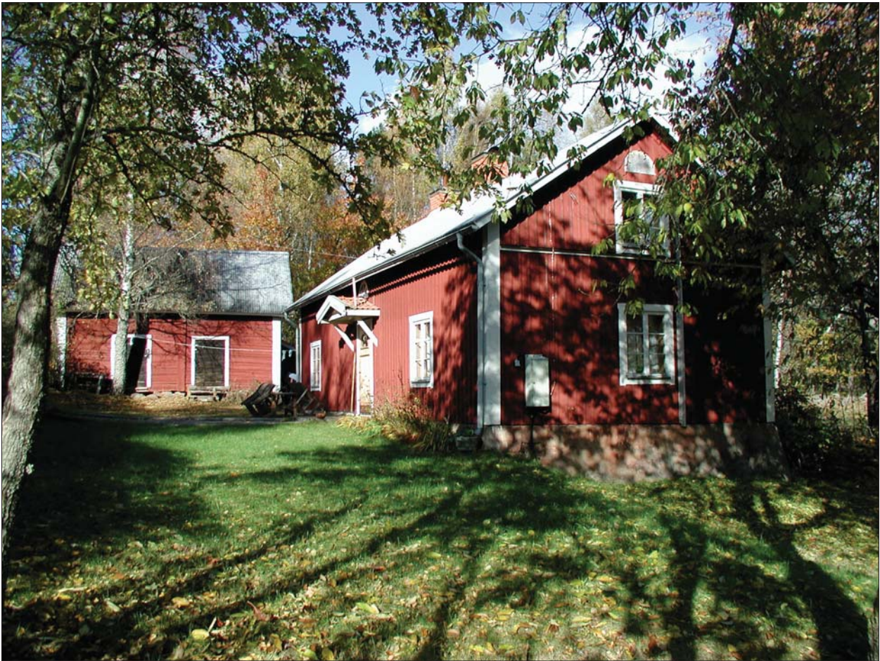
Mangårdsbyggnad och bod, Östra Haddåsen 1:9.
