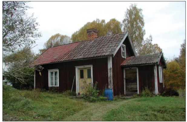
Äldre mangårdsbyggnad, Ugglehult 1:5.
