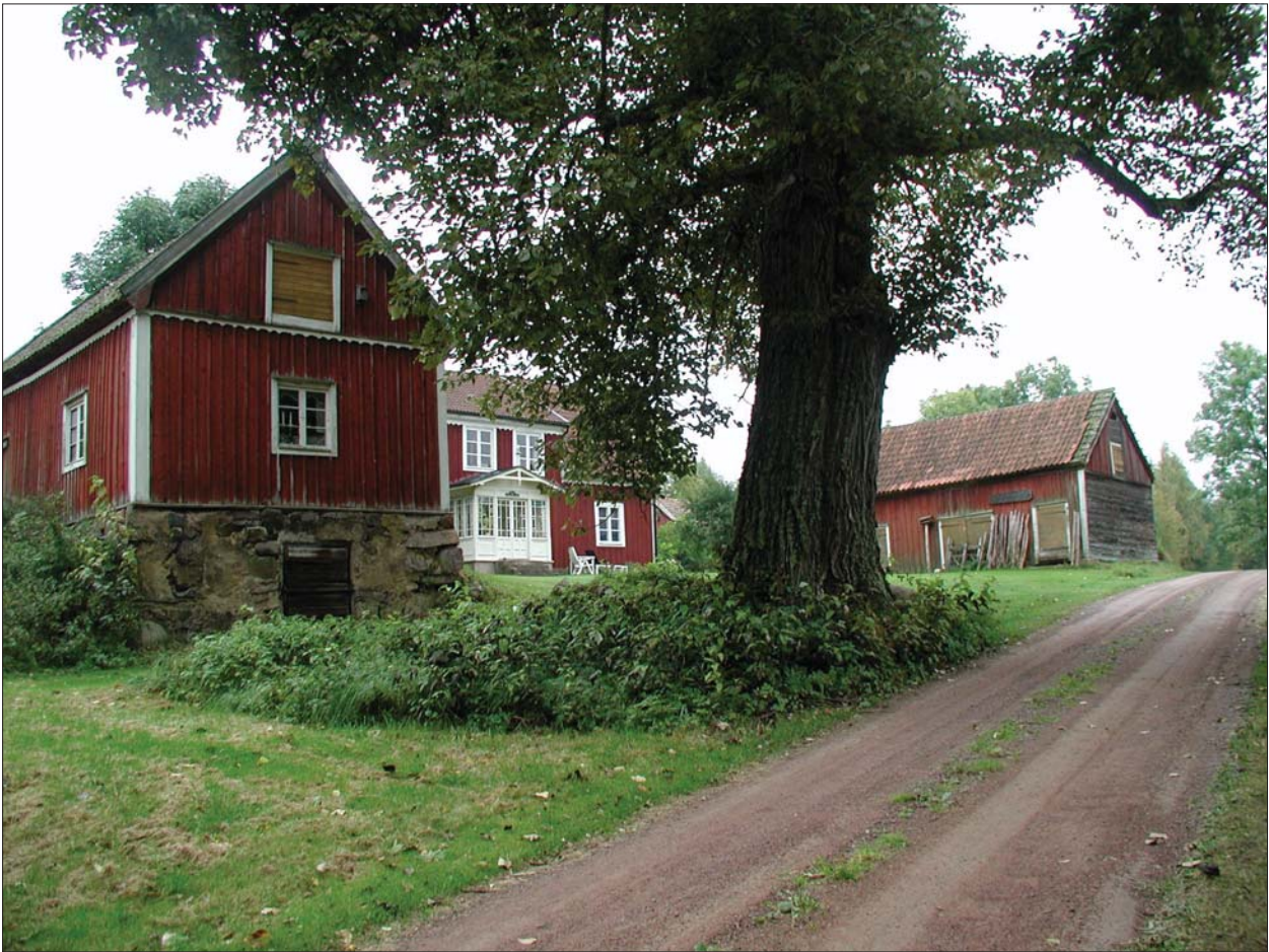
Mangårdsbyggnad, magasin och flygel, Bankaby 1:9 "Storegår'n".
