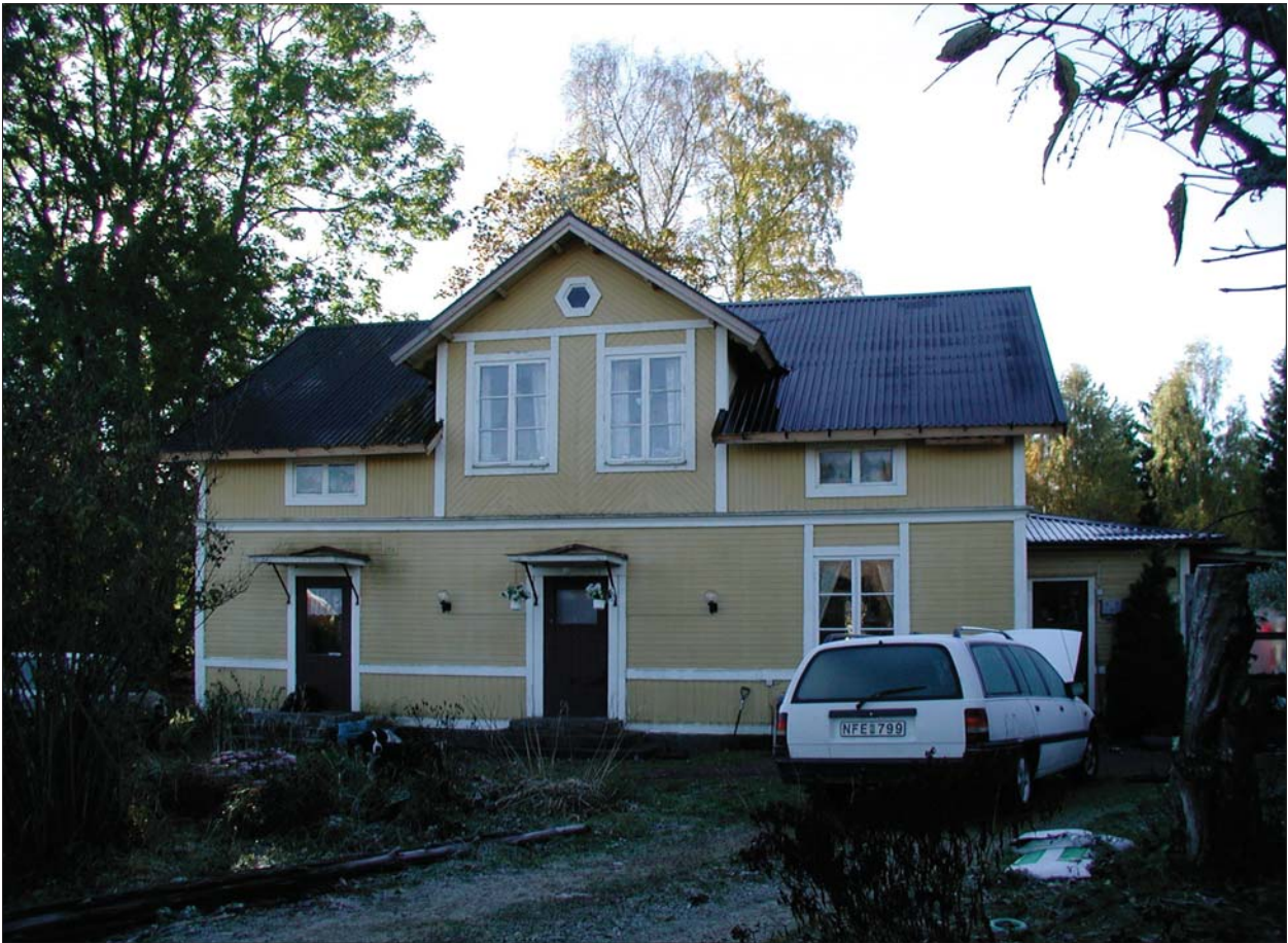
Mangårdsbyggnad, Västra Haddåsen 2:10.
