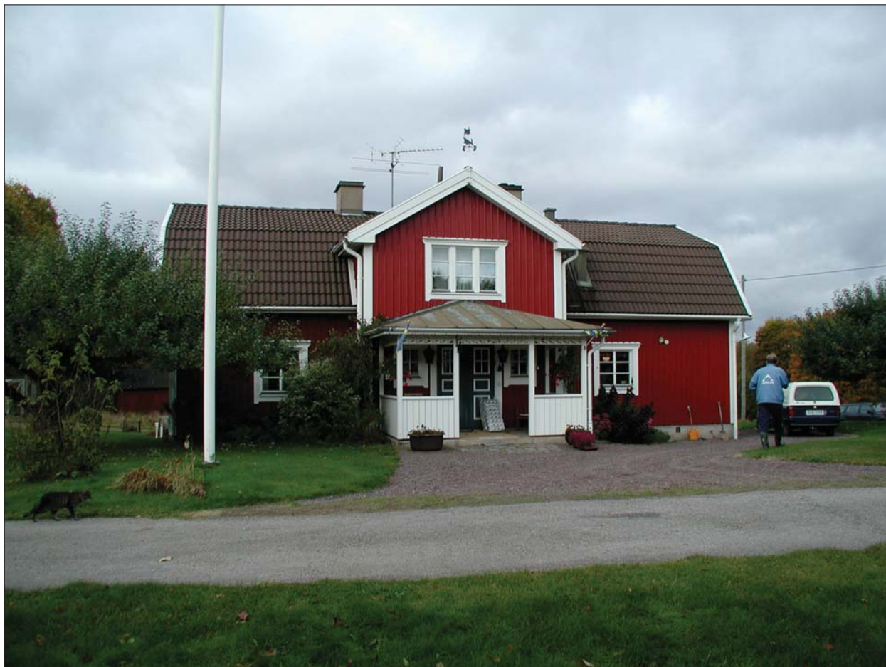
Mangårdsbyggnad, Lilla Aleryd 2:7.
