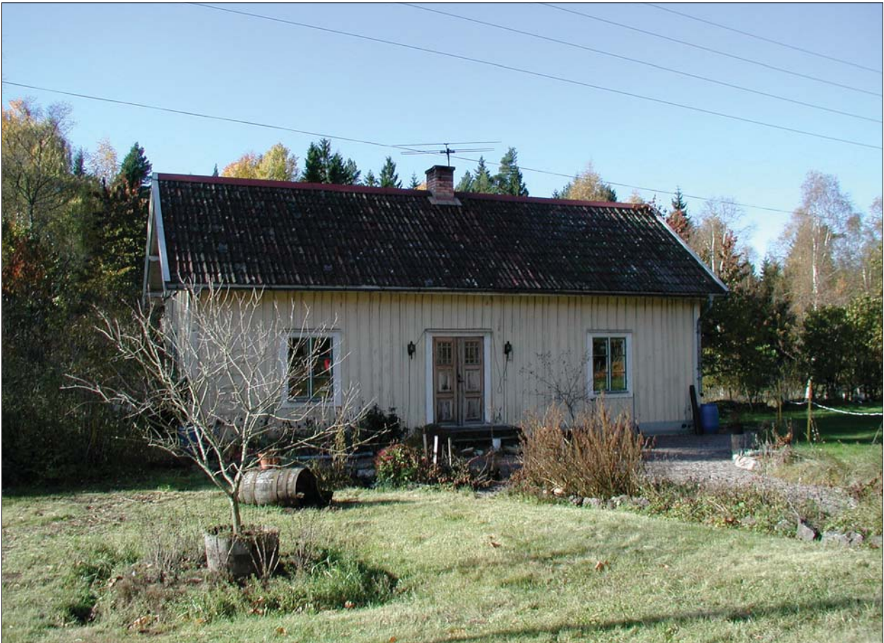
Mangårdsbyggnad, Tällekullen 1:6 "Gustavslund".
