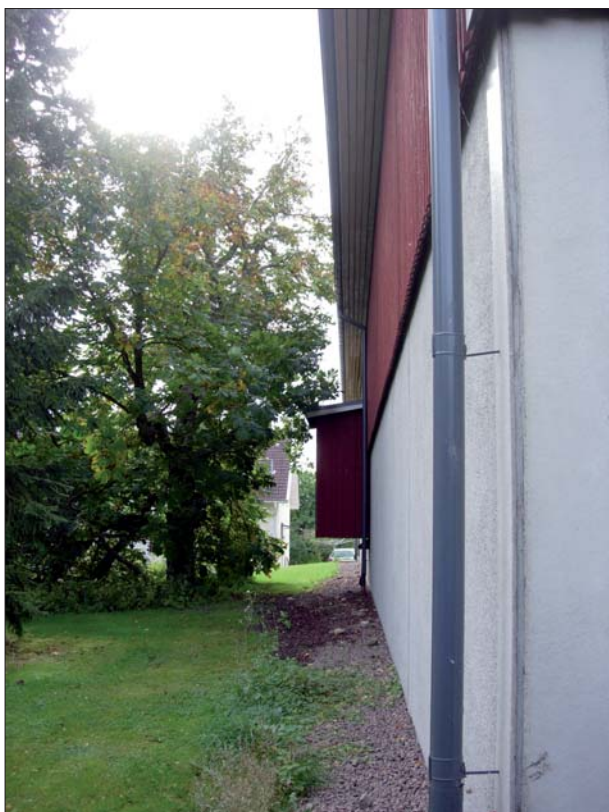
Figur 8. I bakgrunden mangårdsbyggnaden till Bjälbo Trädgård 3:5. Till höger i bild hus V, uppförd ca 1996 utan arkeologisk undersökning. Foto ÖLM
