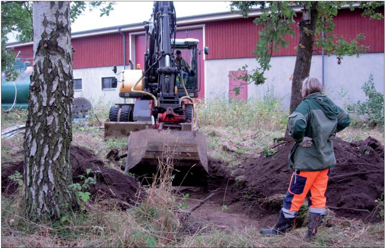
Figur 14. Område B, schakt 6. Foto ÖLM.
