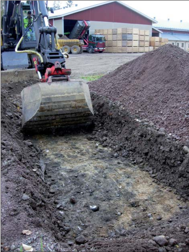
Figur 11. Område A, schakt 11. Foto ÖLM.
