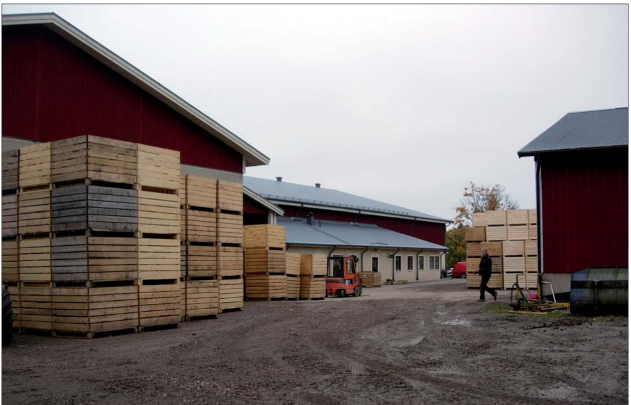
Figur 5. Område A i förgrunden. Huset till vänster betecknat I på schaktplan. Byggnationen föregicks av arkeologisk undersökning 1988 och 1992. Foto ÖLM.
