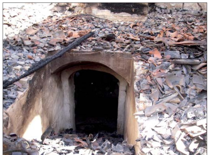
Figur 42. Nergången till von Roxendorffs gravkoret innan röjningsarbetet. Foto ÖLM.
