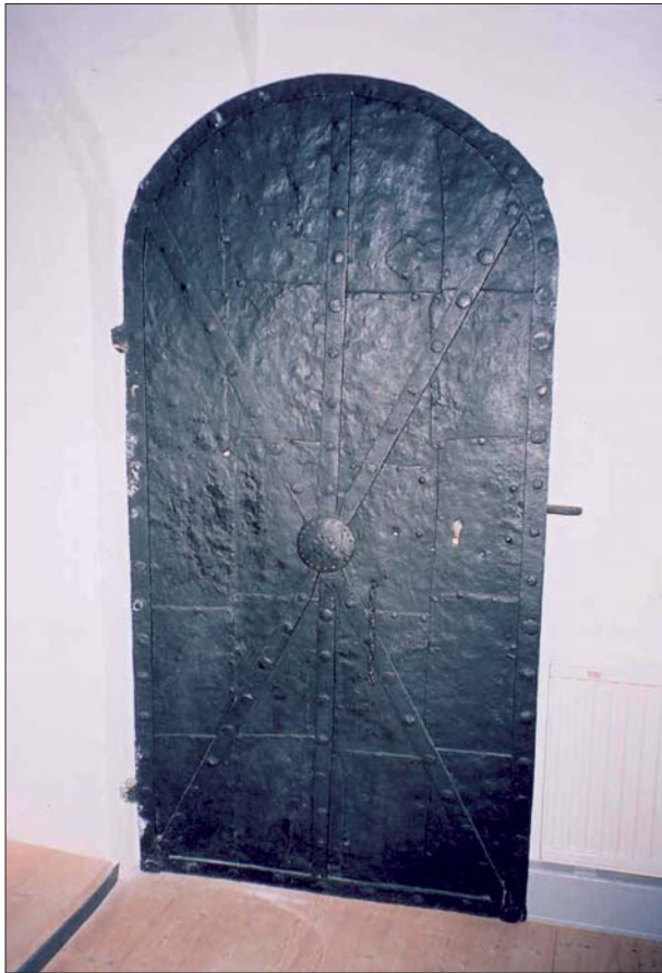
Figur 17. Dörren i korväggen in till sakristian. Foto ÖLM.
