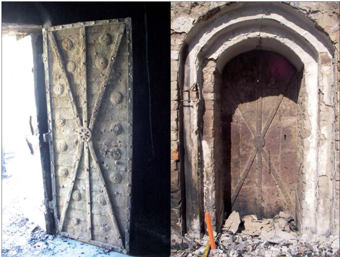
Figur 35. Två av kyrkans fyra medeltida dörrar efter branden; till vänster dörren intill tornet från långhuset, till höger dörren intill sakristian sett från långhuset. Foto ÖLM.
