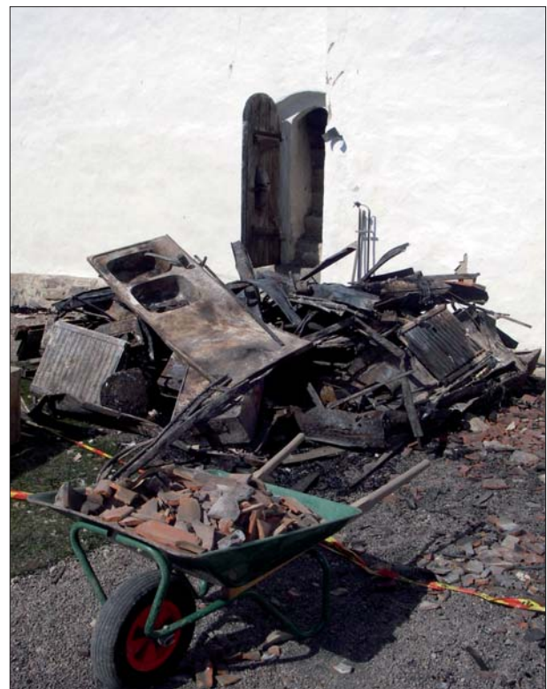
Figur 50. Under upprensningens inledande skede uppsamlades större metallföremål framför långhusets sydportal innan de borttransporterades. Foto ÖLM.
