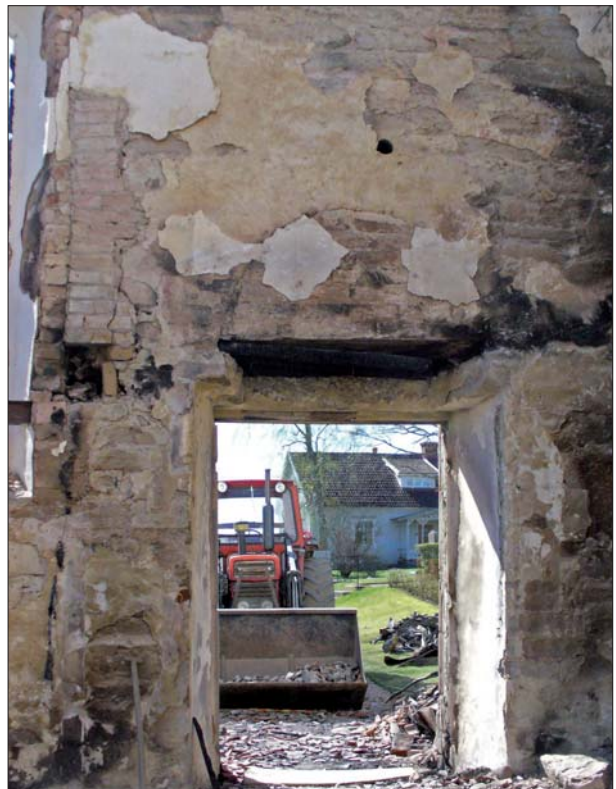
Figur 48. Utanför sydportalen ställdes en traktor upp där brandmassorna dumpades. Foto ÖLM.
