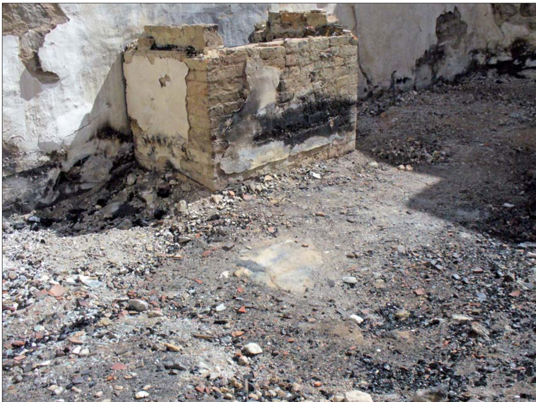
Figur 54. Valvhjässan till tunnvalvet i von Roxendorffska gravkoret framför altaret blev synligt då brandmassorna röjts undan. Foto ÖLM.
