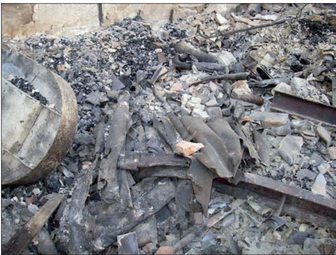
Figur 41. Framför ingången till tornet täcktes golvytan av brandmassor i flera lager med bland annat rester av orgeln. Foto ÖLM.
