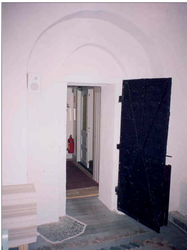
Figur 19. Dörren i långhusets västvägg in till tornets bottenvåning. Foto ÖLM.
