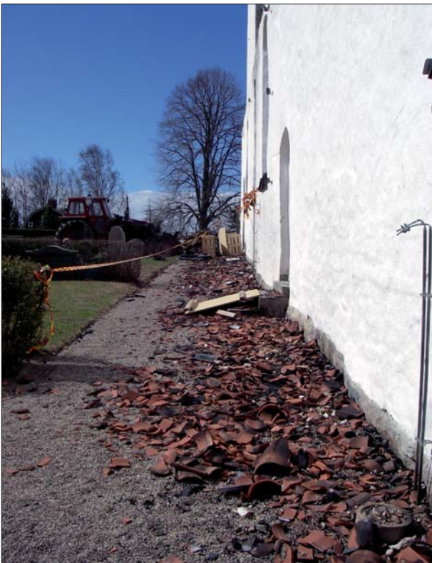
Figur 47. Krossat taktegel täckte marken intill kyrkans ytterväggar. Foto ÖLM.
