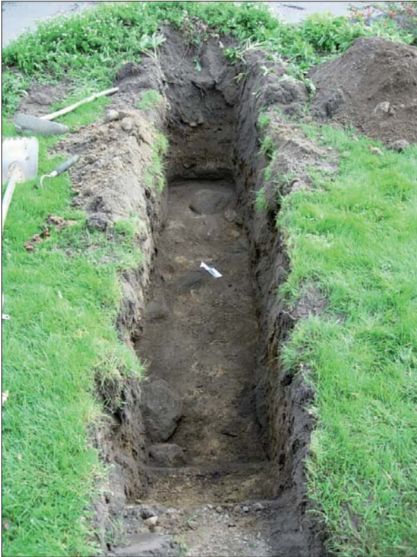
Figur 4. Bild föreställande byggnadslämningar direkt på undergrunden. Foto ÖLM.
