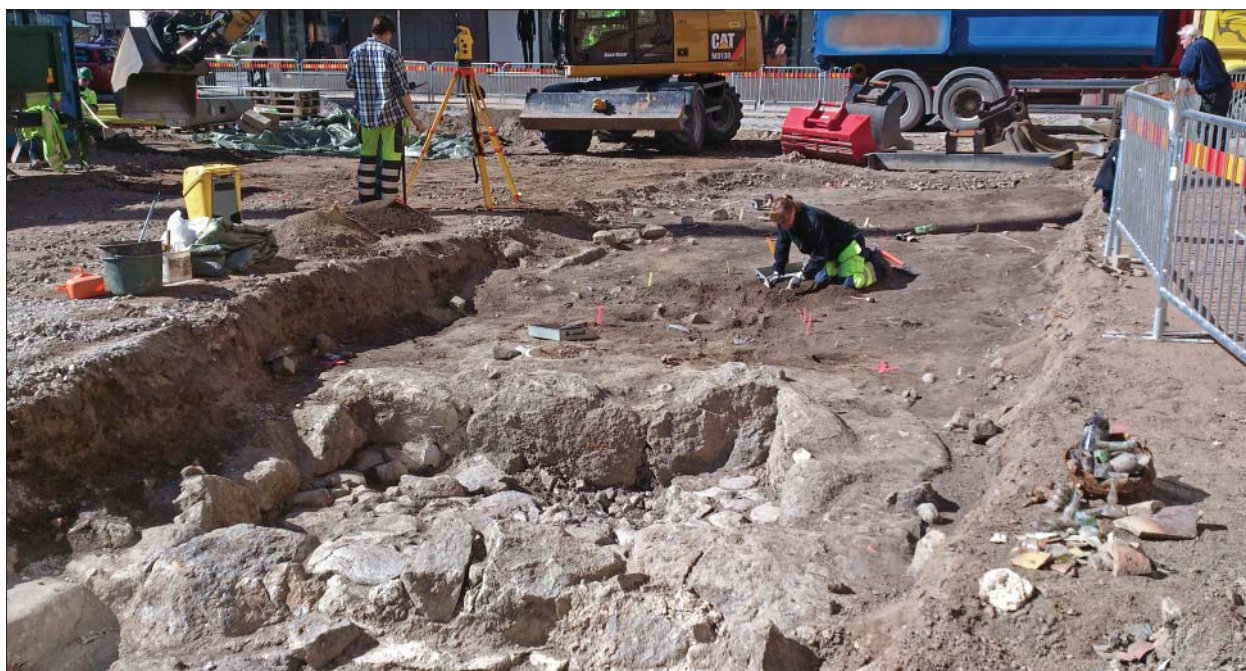
Figur 16. Arbete pågår: totalstation etableras, undersökningsytan rensas och i bakgrunden schaktas äldre bärlager bort. Foto Ann-Charlott Feldt, Östergötlands museum.
