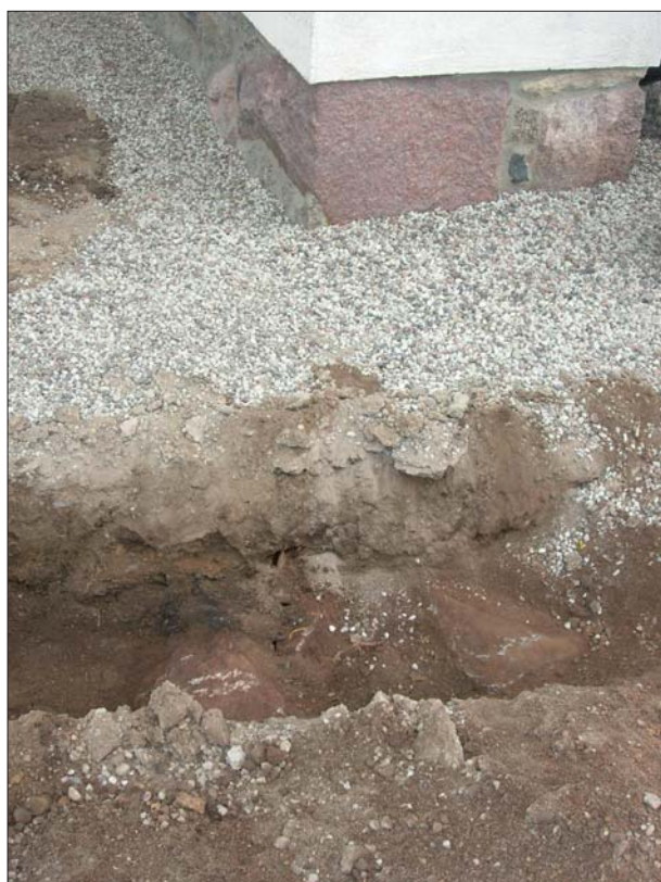
Figur 5. Fundamentet till den medeltida kyrkans västra långhusvägg. Foto Christer Carlsson, ÖLM.
