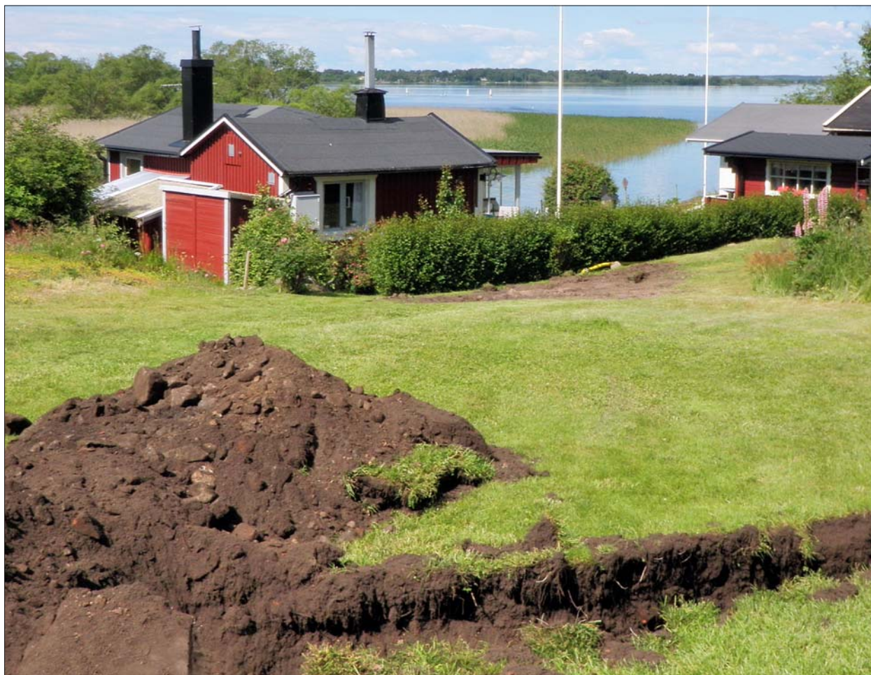
Figur 6. Stångholmens nordvästra del med schakt 3 i förgrunden. Foto Ann-Charlott Feldt, ÖLM.
