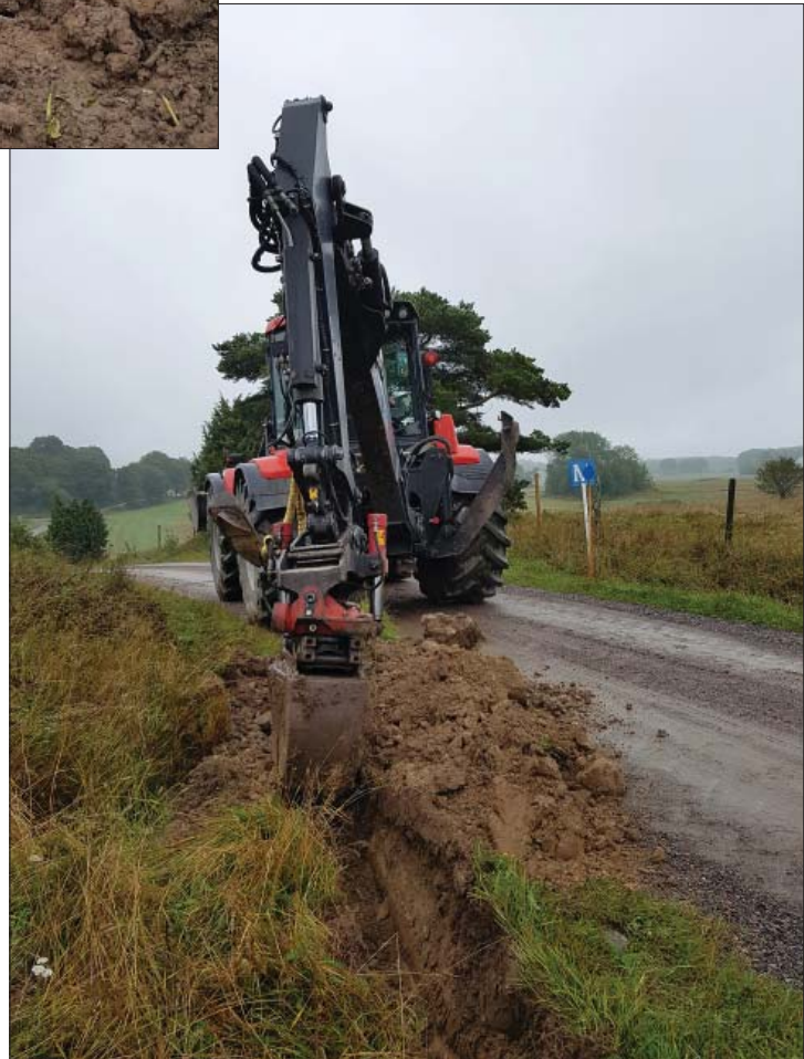
Figur 6. Grävning av schakt 259. Foto mot öster, Anders Olofson, ÖM.
