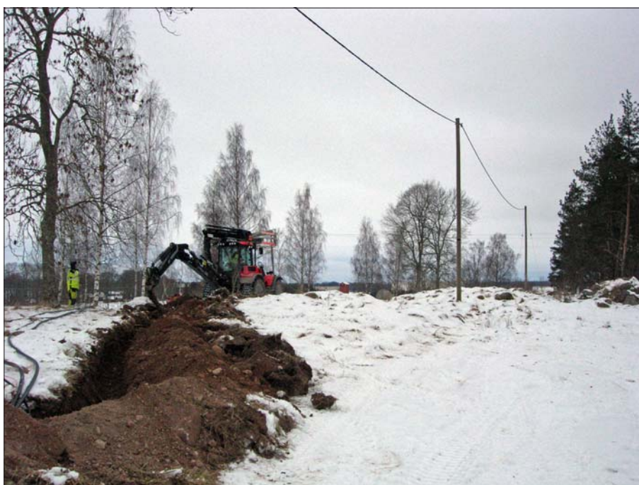
Figur 7. Kabelschaktet grävs genom RAÄ 110, mars 2009. Fotot taget från sydöst. Foto Emma Karlsson, ÖLM.
