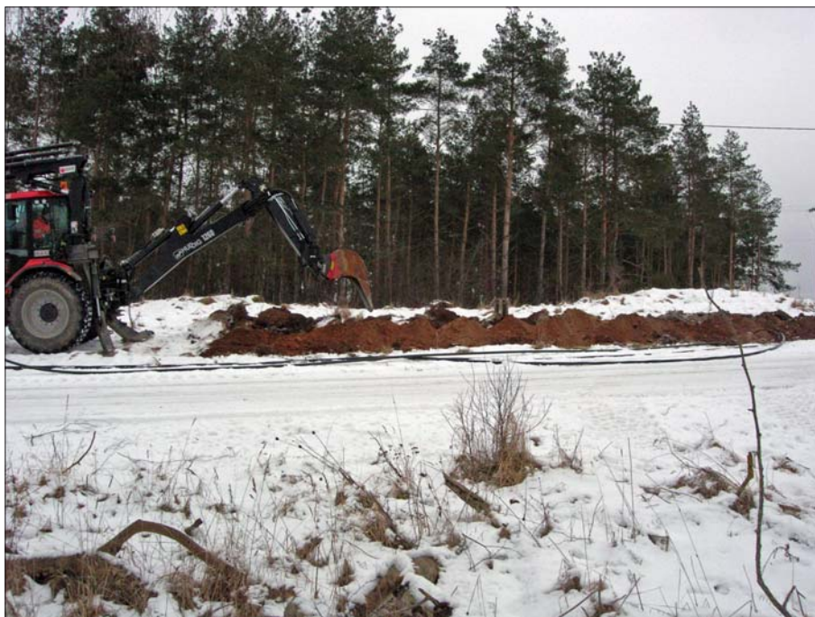
Figur 6. Kabelgrävning inom RAÄ 110, intill väggkant. Fotot taget från väster. Foto: Emma Karlsson, ÖLM.
