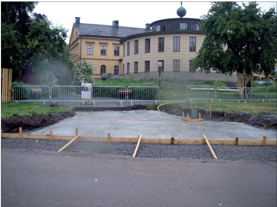
Figur 7. Källaren har täckts över med betong. Foto Ann-Charlott Feldt, ÖLM.
