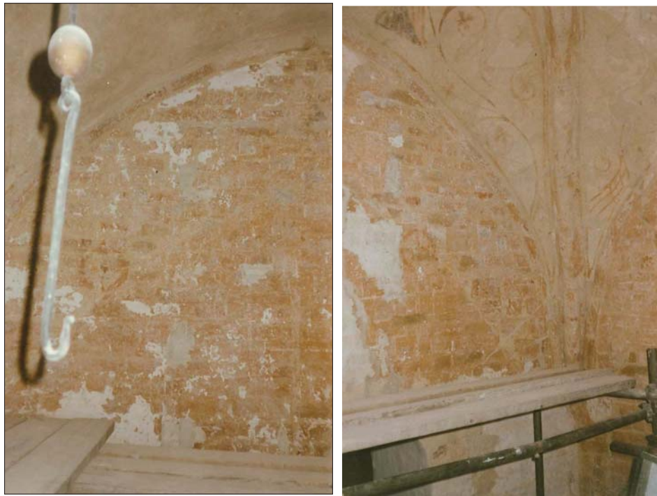
Figur 14. Norra korväggens västra respektive östra del under pågående arbete. Foto Ann-Charlott Feldt, ÖLM.
