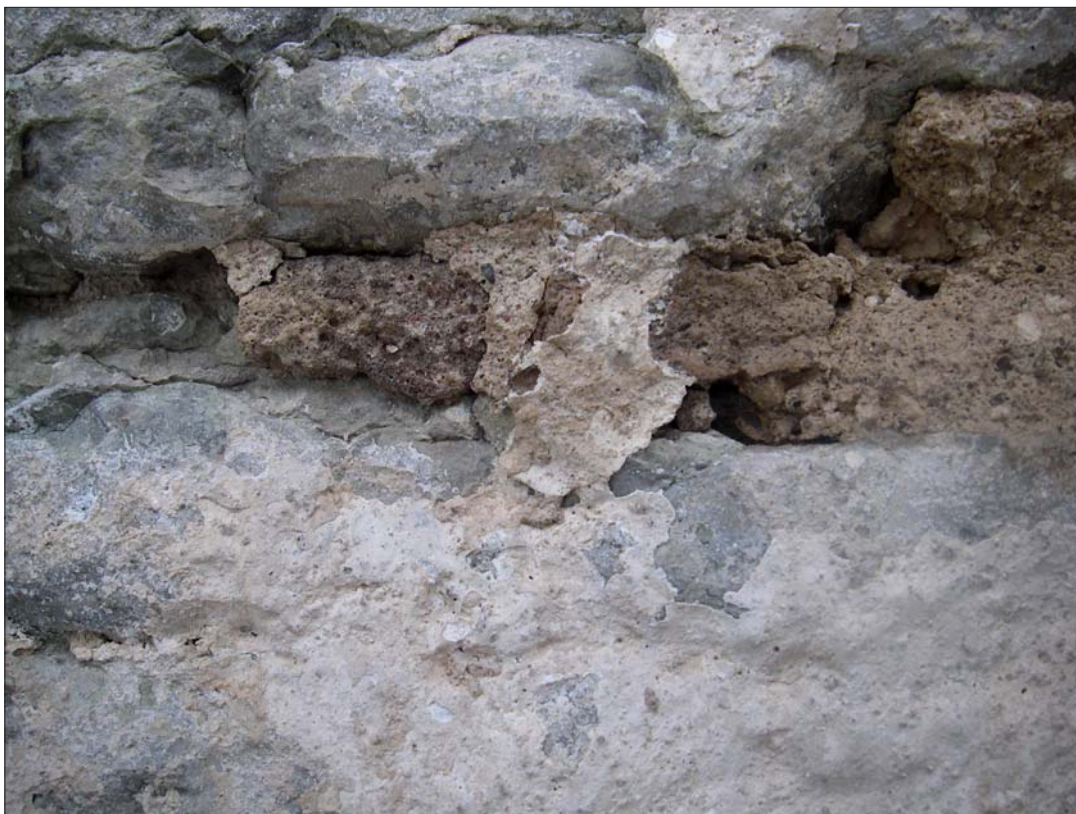
Figur 17. Fas 2. Hårt bränt 1300-tals bruk med vitt smuligt 1500-tals bruk utanpå.
