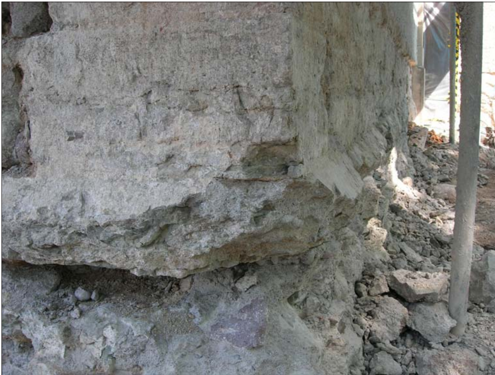
Figur 9. Avbilad kalkstenssockel på tornets fasad. Foto Ann-Charlott Feldt, ÖLM.
