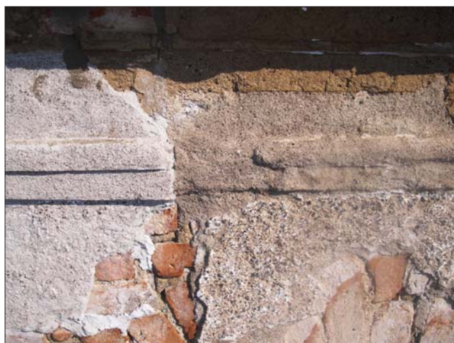
Figur 20. Mjölby kyrktorns takfot med spår av flera olika reparationer. Foto Eva Modén, ÖLM.
