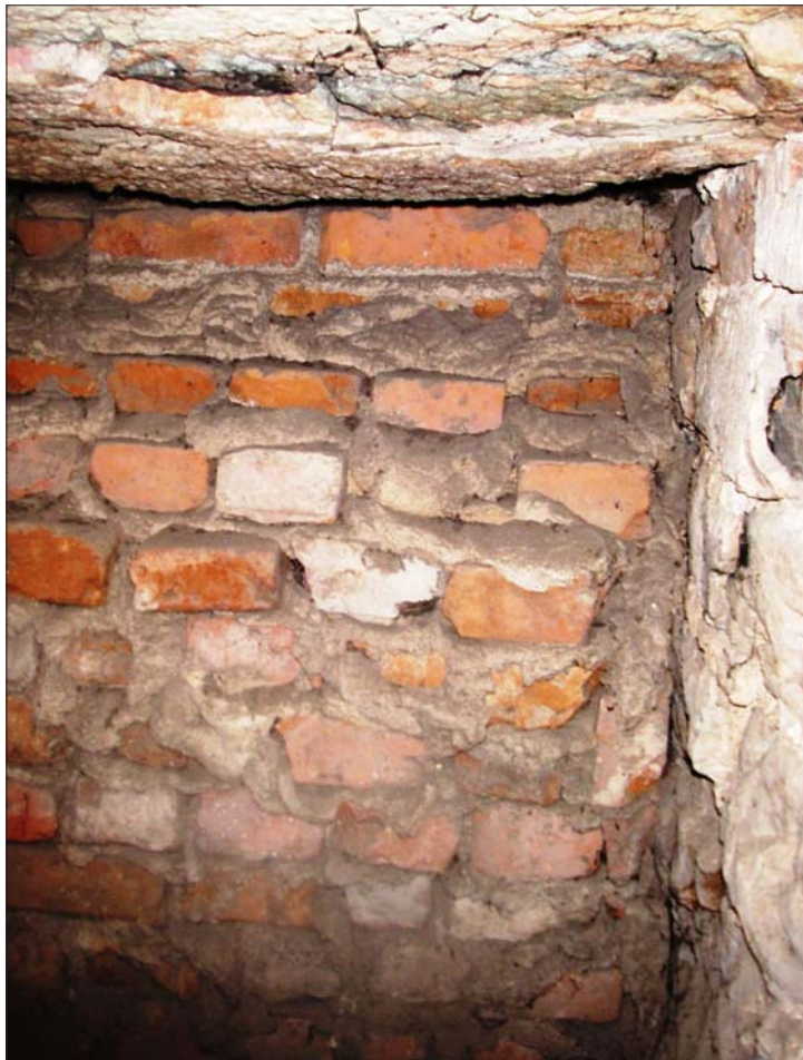
Figur 6. Igenmurad dörr som troligen tillhört en emporvåning i den medeltida kyrkan. Foto Eva Modén, ÖLM.
