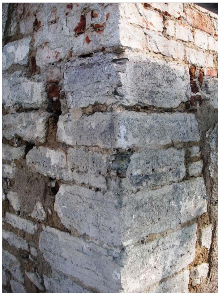
Figur 8. Hörnkedja av kalksten. Foto Eva Modén, ÖLM.
