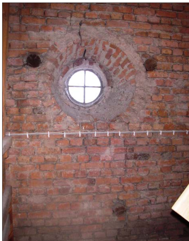
Figur 21. Invändig tegelmur i Mjölby kyrktorn. Rester av bomträ i många av de ursprungliga bomhålen. Foto Eva Modén, ÖLM.
