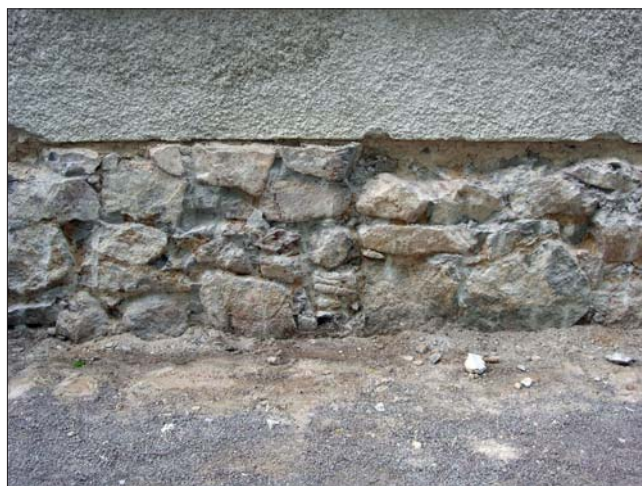
Figur 18. Långhusets sockel efter att cementsockeln blivit bort. Foto Ann-Charlott Feldt, ÖLM.
