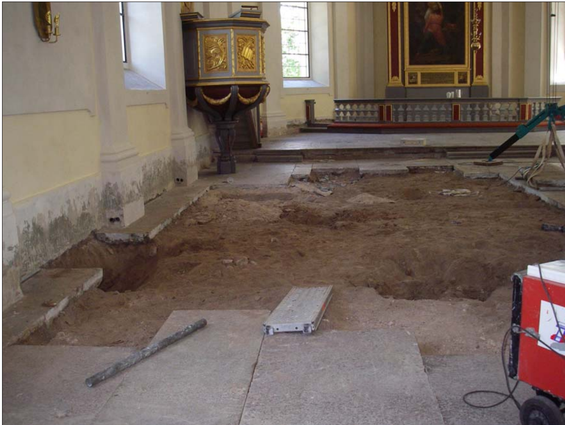
Figur 27. Mjölby kyrkas golv renoveras. Foto Ann-Charlott Feldt, ÖLM.
