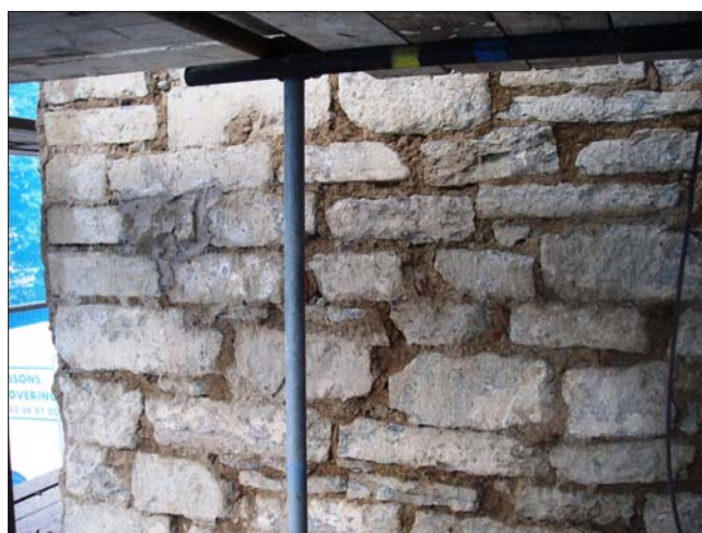
Figur 19. Långhusets västra vägg murad med återanvänd kalksten och mycket mörkt kalkbruk som troligen tillverkats av bränt medeltida bruk. Foto Eva Modén, ÖLM.
