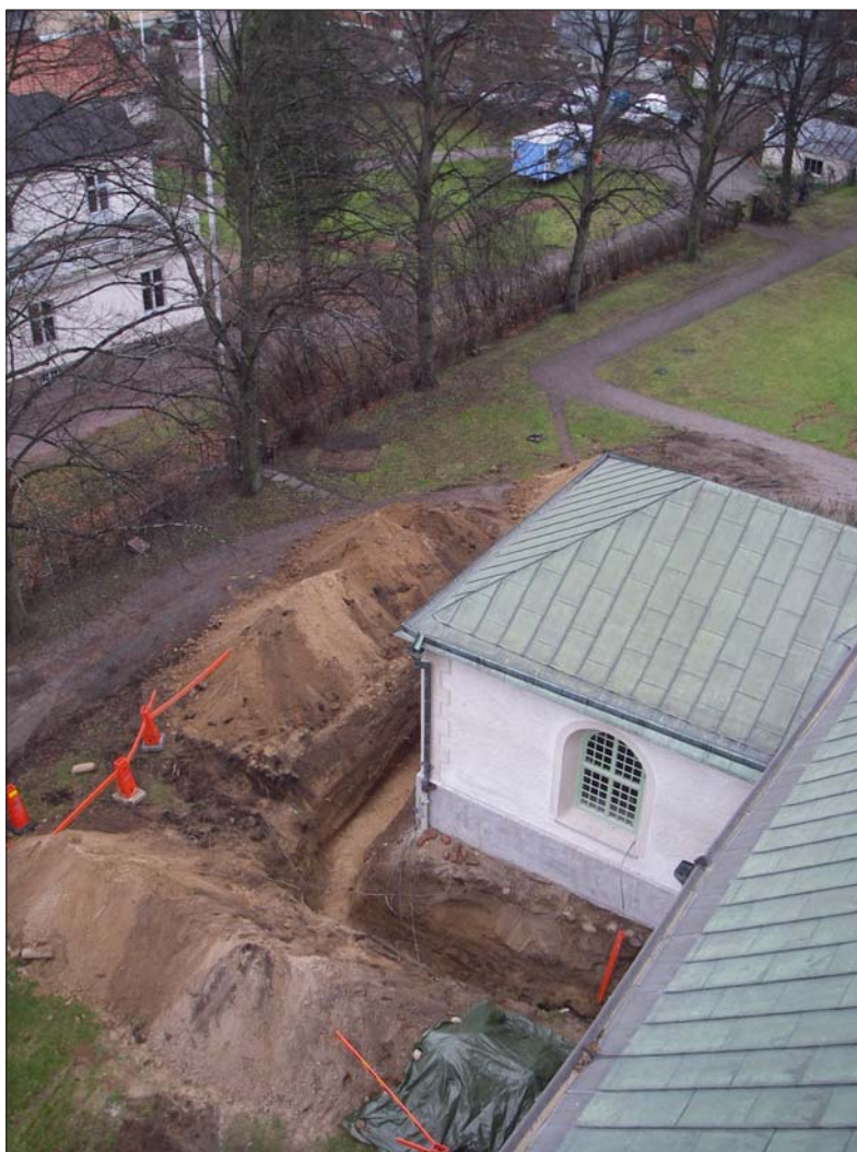
Figur 31. Sakristian med dräneringsschakt. Foto Ann-Charlott Feldt, ÖLM.
