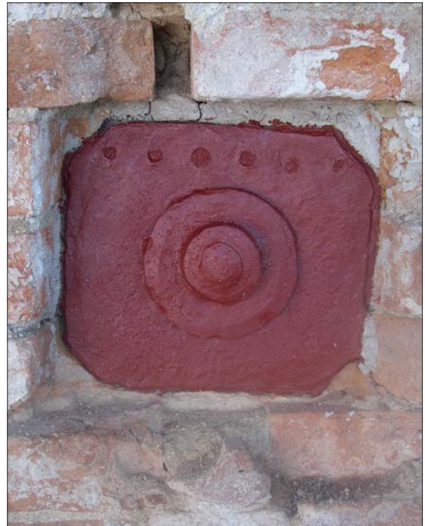
Figur 24-25. Extra förstärkning av klockbjälklaget. Stångjärn med järnplattor som ankarjärn, troligen ditsatta vid 1906 års renovering. Foto Eva Modén, ÖLM.
