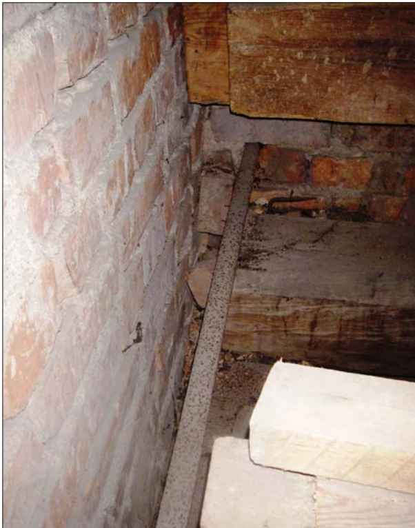
Figur 24-25. Extra förstärkning av klockbjälklaget. Stångjärn med järnplattor som ankarjärn, troligen ditsatta vid 1906 års renovering. Foto Eva Modén, ÖLM.
