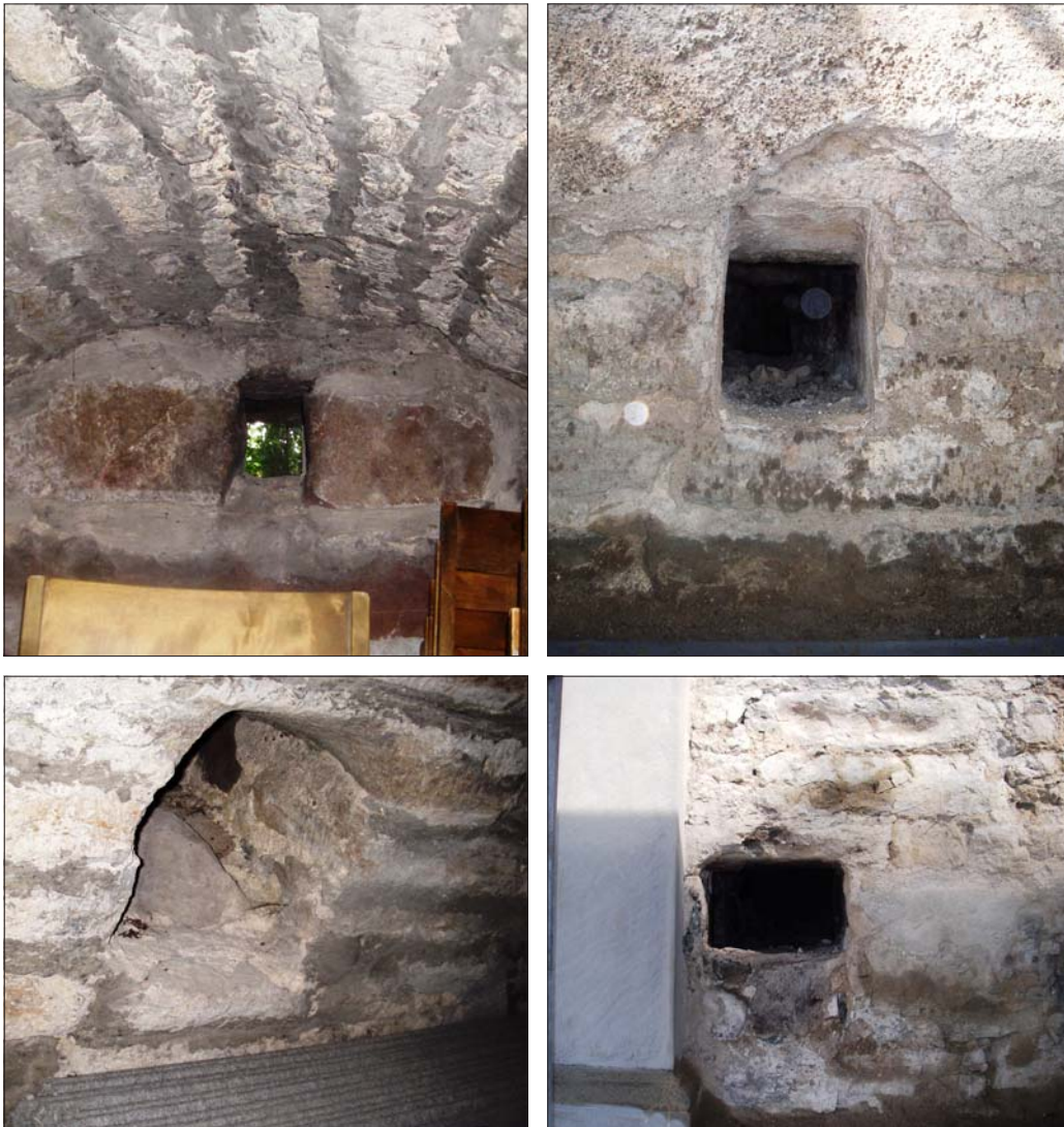
Figur 13-16. Två av de tre nyupptäckta ljusgluggarna till bottenvåningens två tornkammare i det medeltida tornet, inifrån och utifrån. Foto Eva Modén, ÖLM.
