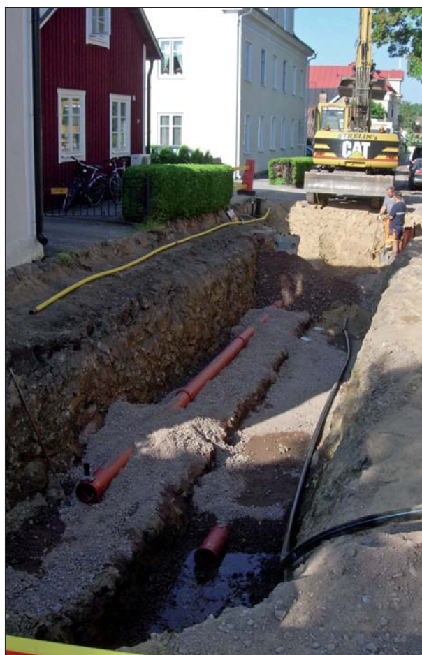
Figur 5. Schaktet i Gräsgatan, mot söder. Foto Mats Magnusson, ÖLM.
