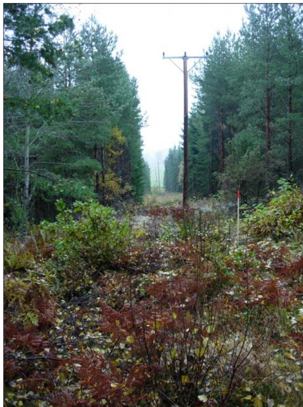
Figur 5. Ledningsgata, söder om Skravestad som skulle byggas om. Mot öster. Foto Erika Räf, ÖLM
