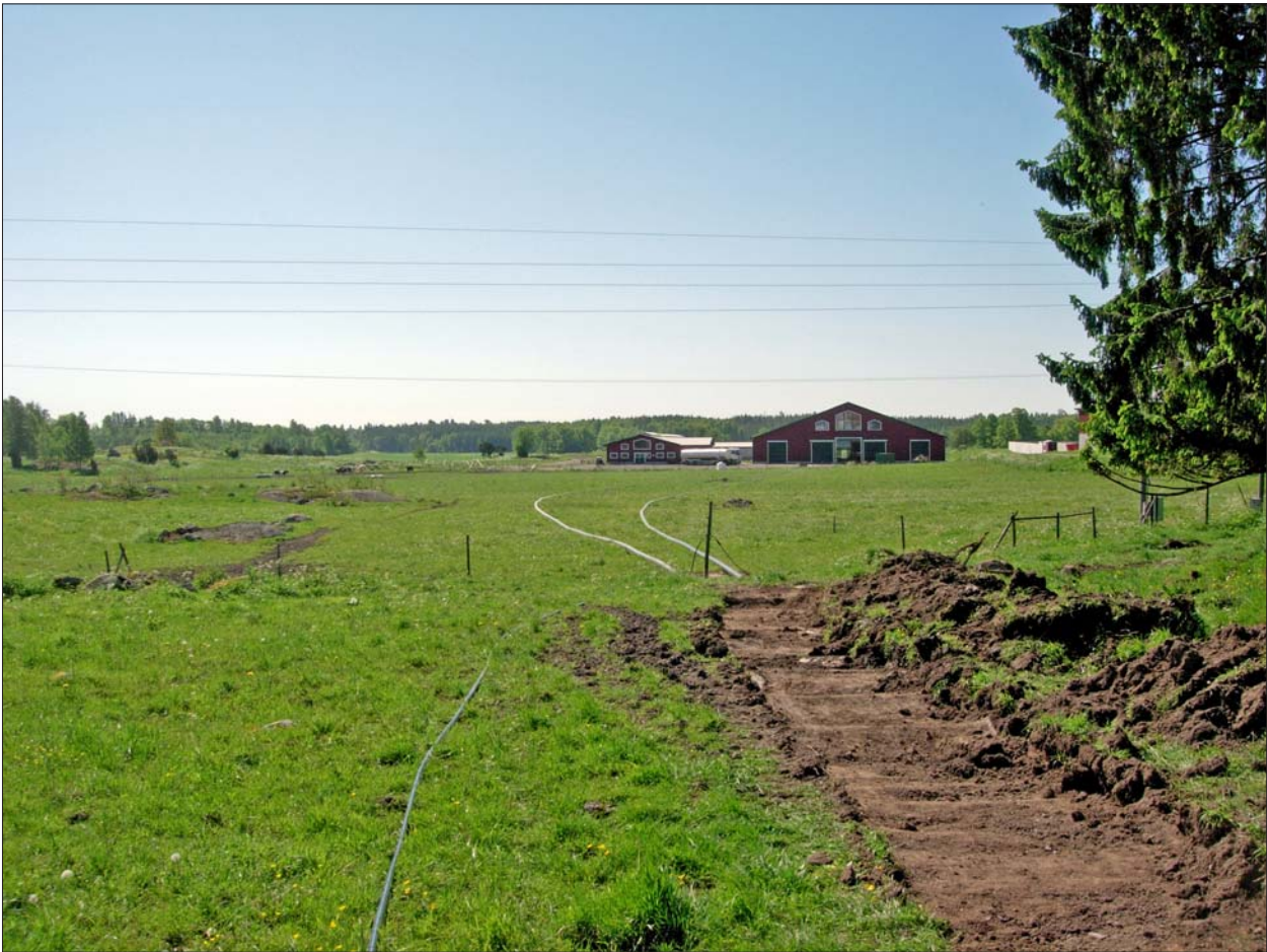
Figur 5. Översikt över ledningssträckan mot söder, fram till djurstallarna. I förgrunden ett av sökschakten. Foto: Erika Räf, ÖLM.
