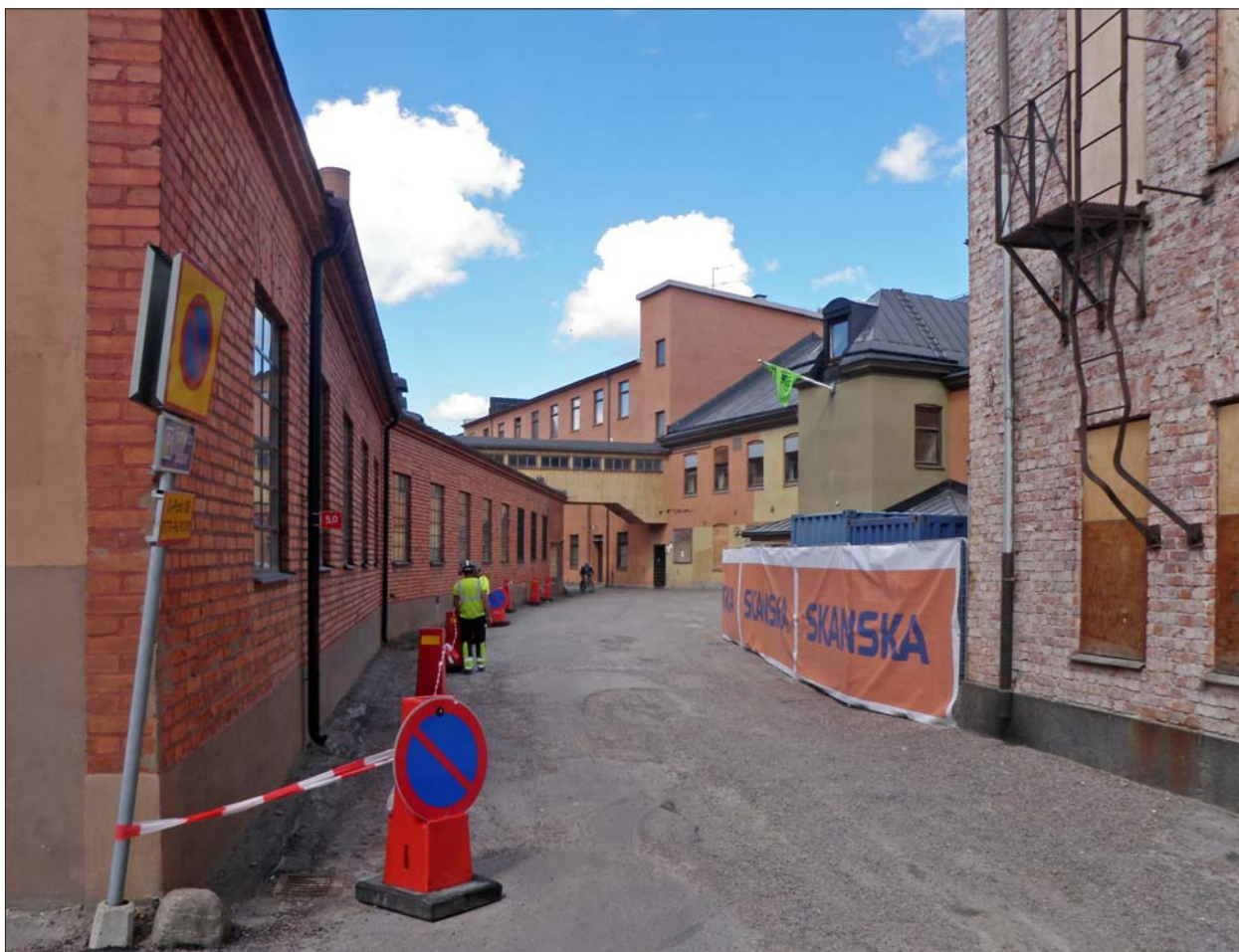
Figur 11. Längs Norra Grytsgatan är industrilandskapet fortfarande påtagligt nedslitet och renoveringar och upprustning bara i sin linda. Schaktet löpte här på gatans södra sida två meter ut från husväggen där avspärrningskonerna står. Foto Olle Hörfors, ÖLM.
