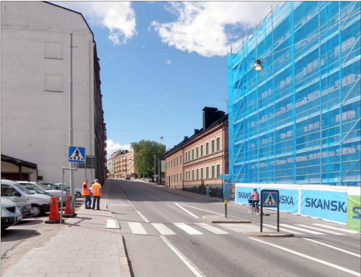
Figur 10. Kungsgatan. Schaktet löpte längs trottoaren till vänster i bild. Norra Grytsgatan mynnar i Kungsgatan mellan det med byggnadsställningar täckta huset och det gula längre upp. Foto Olle Hörfors, ÖLM.
