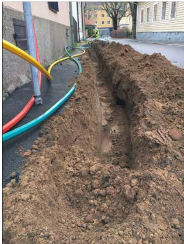
Figur 8. Schaktet i Teatergatan. Foto från norr. Helén Romedahl, ÖM.
