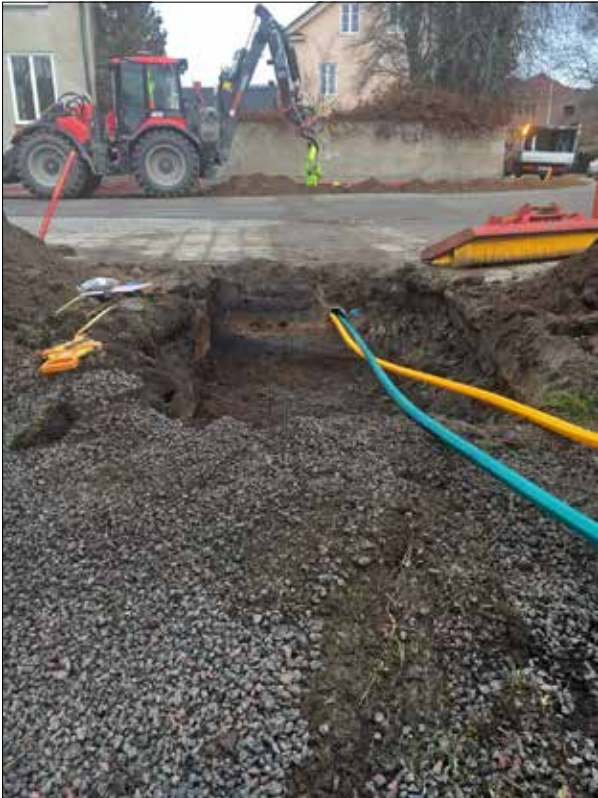
Figur 6. Schaktet ut mot Gråbrödragatan. Foto från väster. Helén Romedahl, ÖM.
