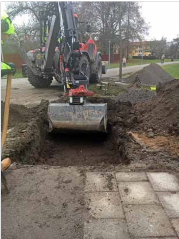
Figur 7. Schaktet ut mot Gråbrödragatan. Foto från öster. Helén Romedahl, ÖM.
