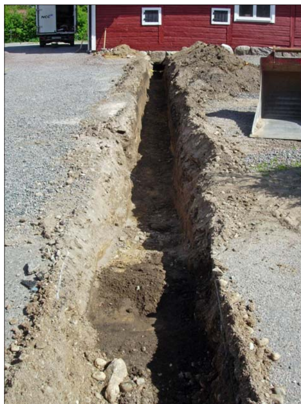
Figur 6. Schaktet i Follingegatan 12. Foto Mats Magnusson, ÖLM.
