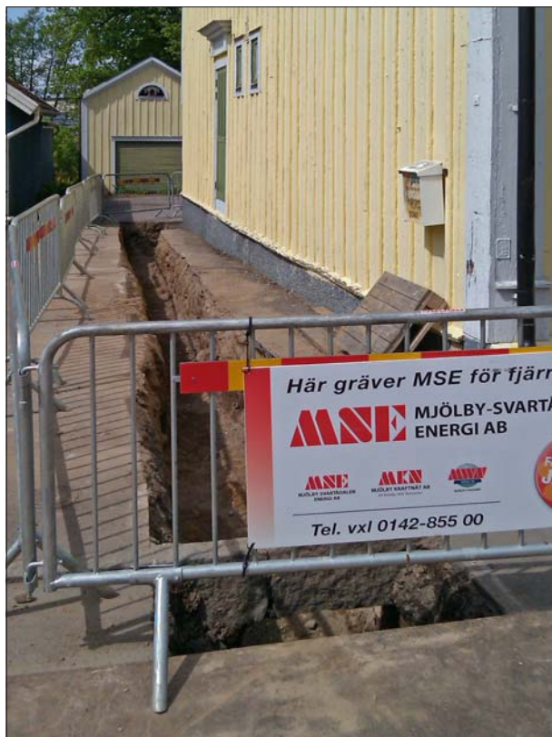
Figur 5. Schaktet i Follingegatan 28. Foto Mats Magnusson, ÖLM.
