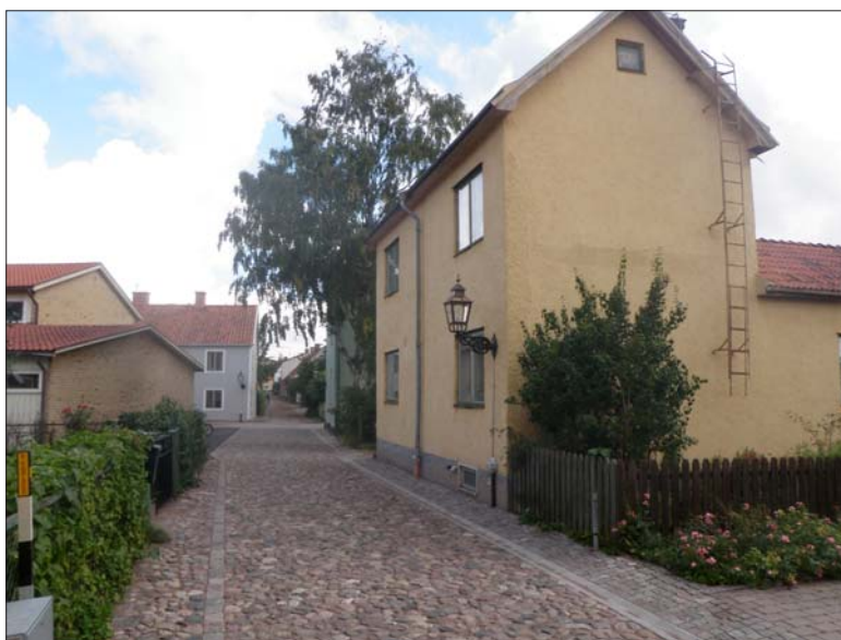
Figur 4. Groggatan. Det gula rappade huset är kvarteret Komministern 12. Profil ritades här på båda sidor av schaktet. Profil 2 upprättades i Backegatan strax bakom det grå huset som syns längst bort i bild. Bild Olle Hörfors 2010.
