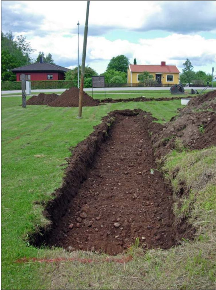
Figur 5 t v. Utredningsschakt intill ishockeyrinken. Foto mot V Erika Räf, ÖLM.
