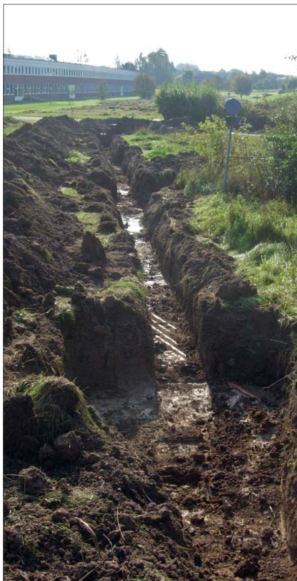
Figur 3. Schaktet mot SSÖ. Foto Mats Magnusson, ÖLM.
