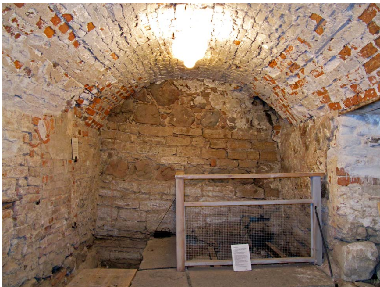
Figur 8 nedan. Södra muren med brandskadat murverk och mönstermurning. Foto Eva Modén.
