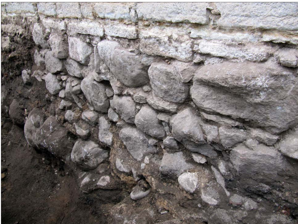
Figur 17. Det äldsta husets västra grundmur med ett annorlunda utseende. Dagermurens kalkstenar ses överst. Schaktet togs upp i april 2010. Foto Eva Modén.
