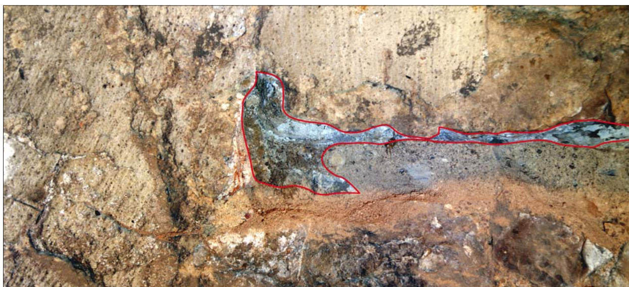
Figur 13. Murbruksfog i kalkstenshuset. Brukstyp 2A, här markerat med röd linje, med grövre ballast med en sotig yta från branden syns bakom omfogningsbruket. Foto Lasse Norr, ÖLM.
